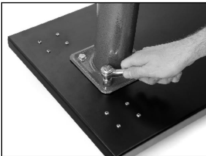
Рисунок 3. Установка опоры коллектора.
