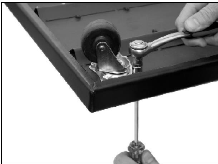
Рисунок 2. Установка поворотных роликов.
