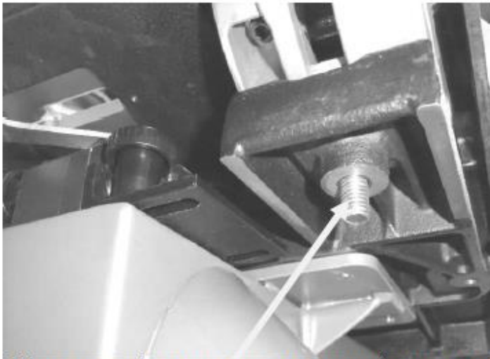
Шпилька фиксации качающейся опоры
