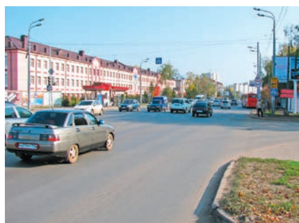
Горьковское шоссе (реконструкция, дорога стала четырёхполосной)
