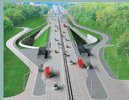
Горьковское шоссе (после реконструкции дорога стала шестиполосной, построены трёхуровневая развязка, эстакады, тоннель, разворотные узлы, пешеходные переходы)
