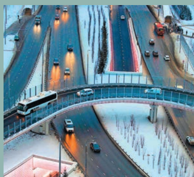
Горьковское шоссе (после реконструкции дорога стала шестиполосной, построены трёхуровневая развязка, эстакады, тоннель, разворотные узлы, пешеходные переходы)
