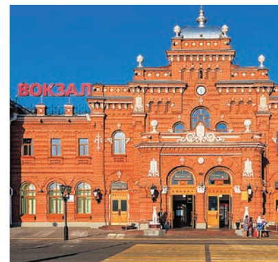
Ж/Д вокзал (реконструкция)
