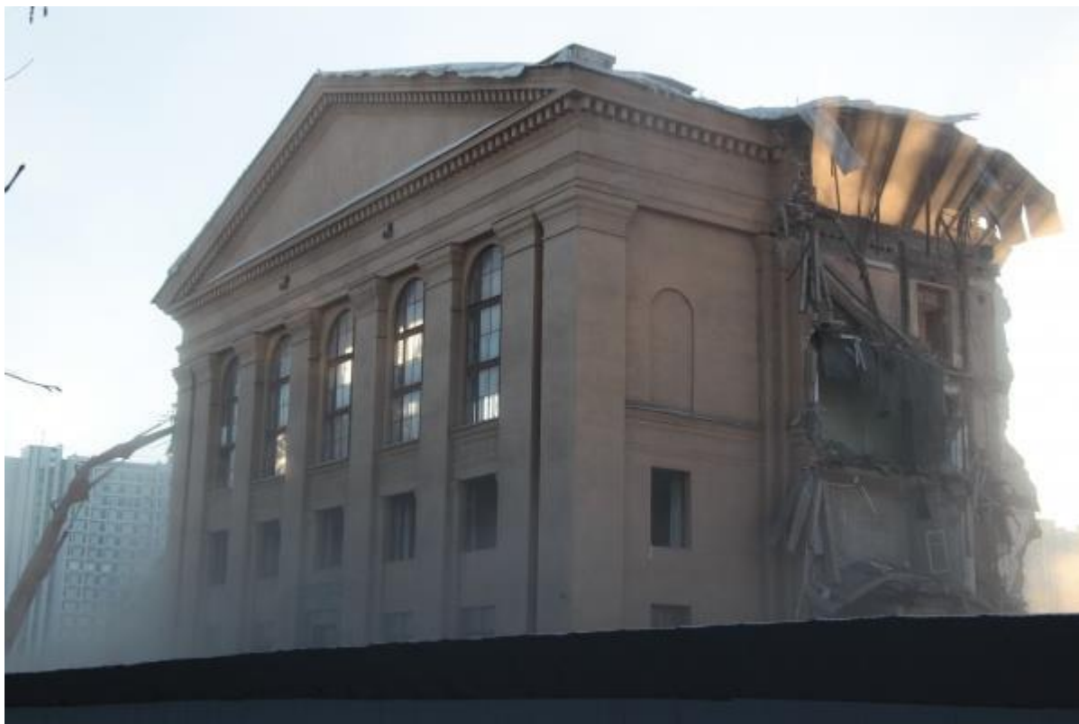
Снос главного здания. 2016 год.
