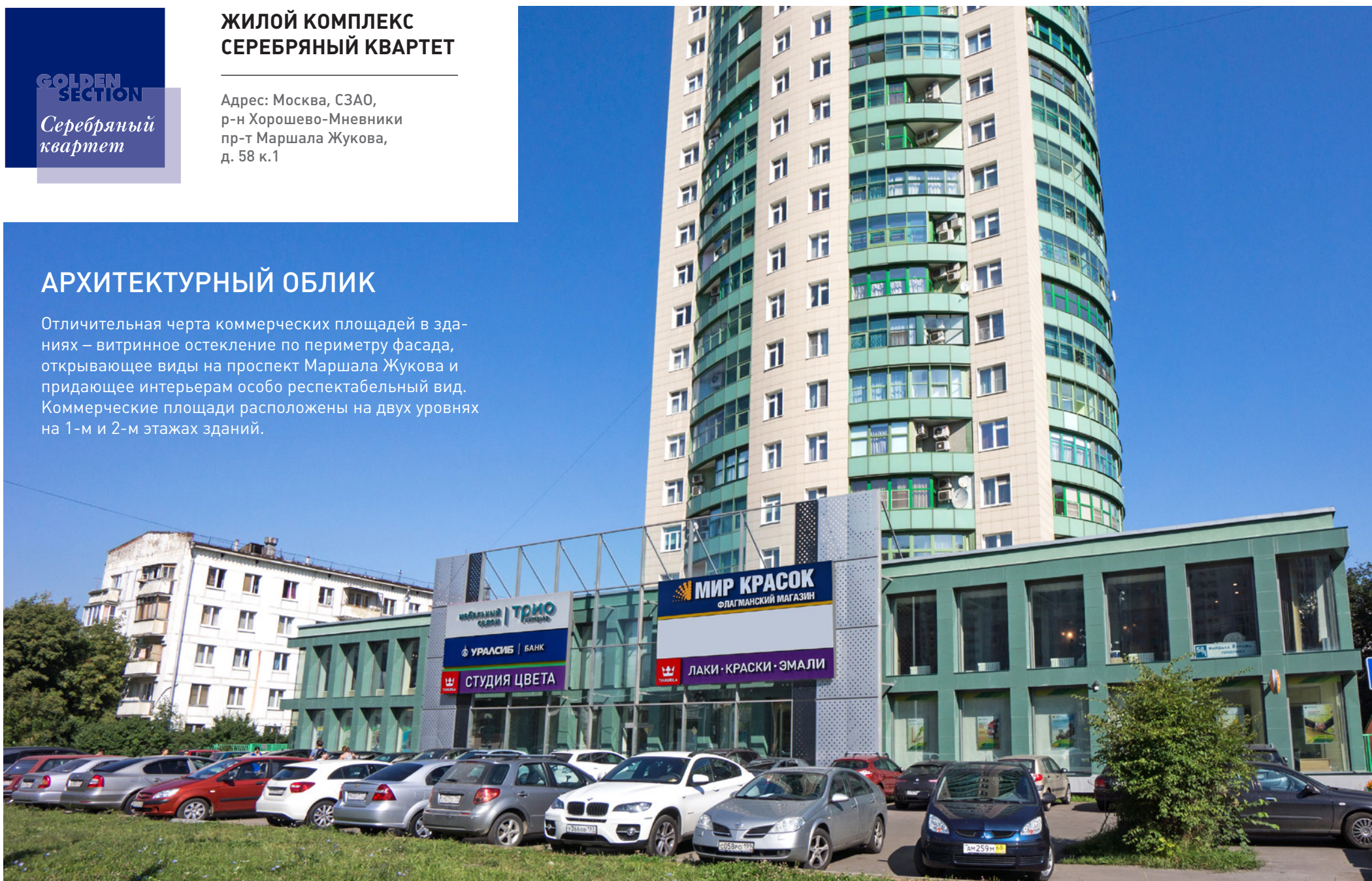
Фасад стилобата. Вид с проспекта Маршала Жукова
