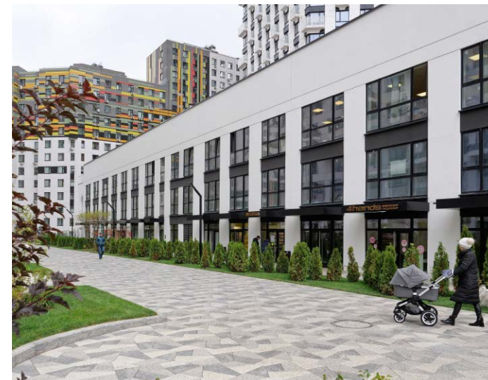
Галерея Wellton Towers / ул. Народного Ополчения, д. 15
