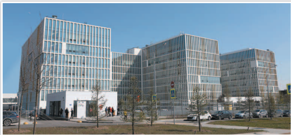
Московский многопрофильный клинический центр «Коммунарка»
