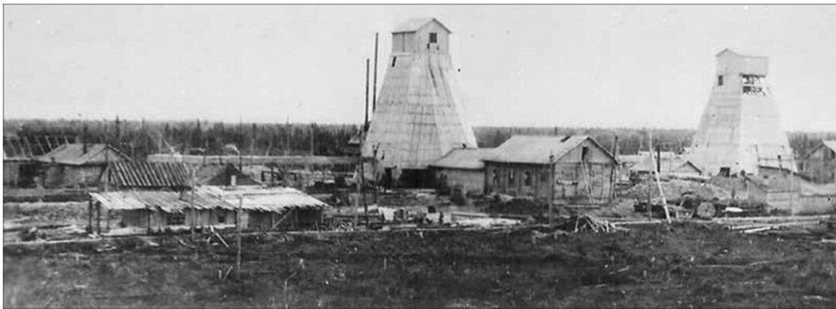
Закладка стволов первой нефтешахты. Ярега 1937 г.
