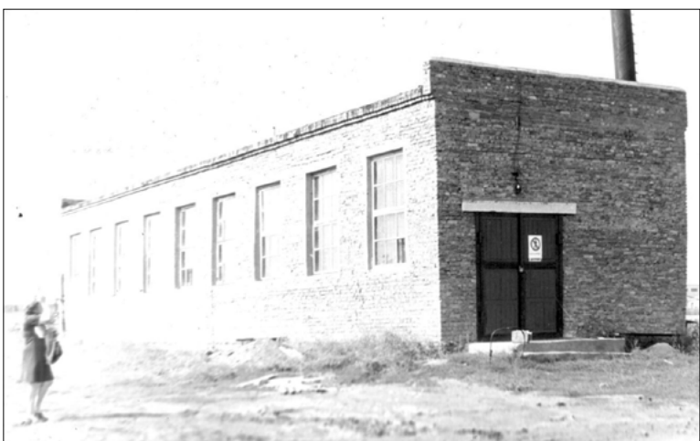
Котельная № 53, 1980-е гг. / Фото из архива АПТС
