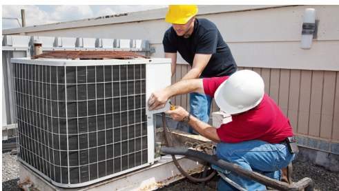
Услуги по монтажу инженерных систем
