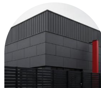
ФАСАДЫ, КРОВЛЯ, ВОРОТА
