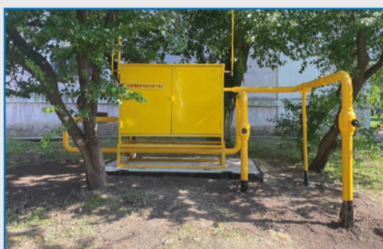
Монтаж газорегуляторного оборудования в Луганской Народной Республике
