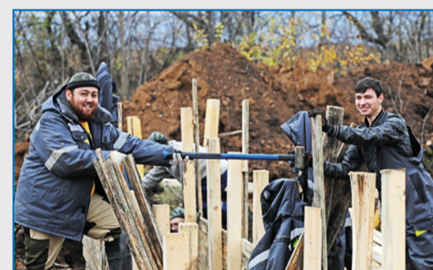
К работам на линии обороны привлечены работники Комплекса городского хозяйства Москвы
