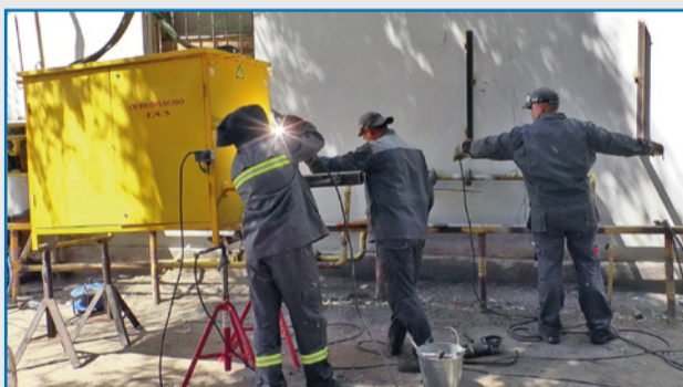
Работы по замене шкафных газорегуляторных пунктов в Луганской Народной Республике
