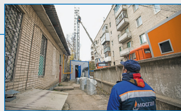
Строительство котельной в Луганской Народной Республике
