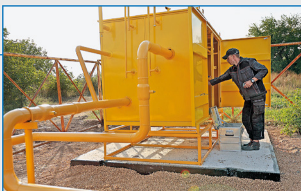
Работы по замене шкафных газорегуляторных пунктов в Донецкой Народной Республике
