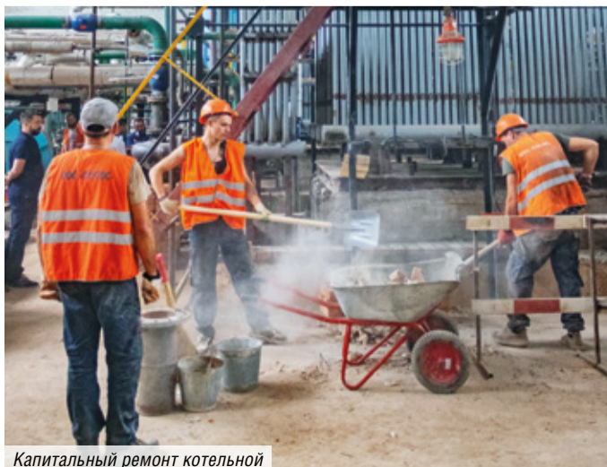
Капитальный ремонт котельной
