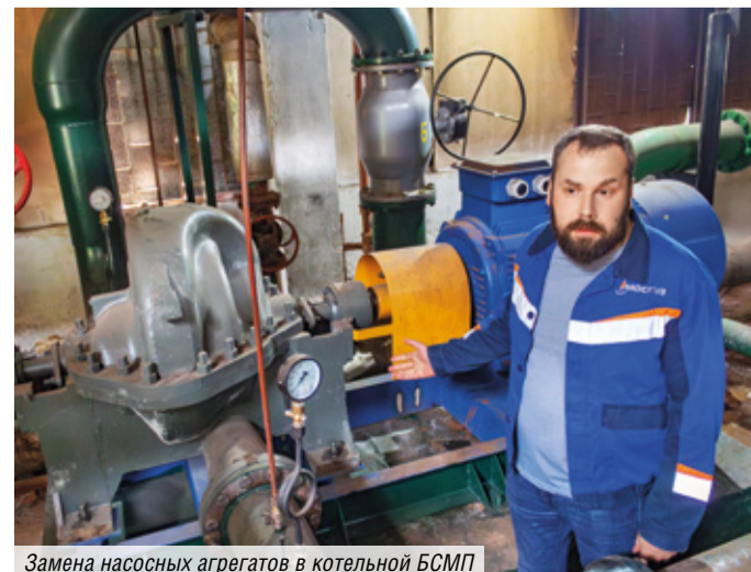
Замена насосных агрегатов в котельной БСМП
