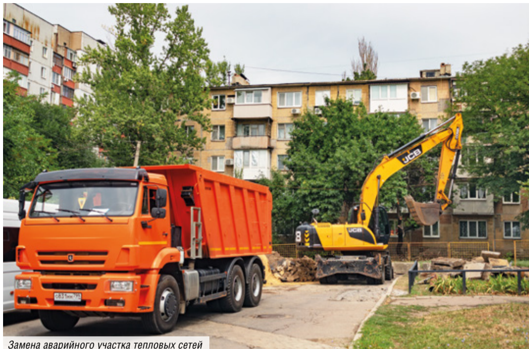
Замена аварийного участка тепловых сетей
