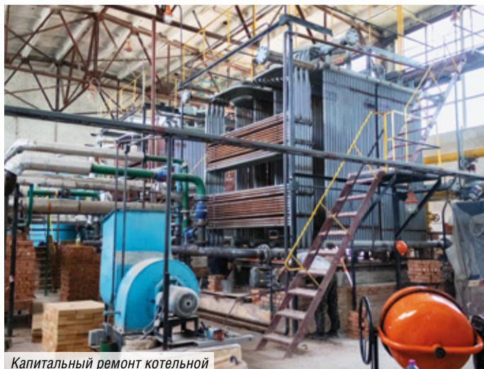
Капитальный ремонт котельной
