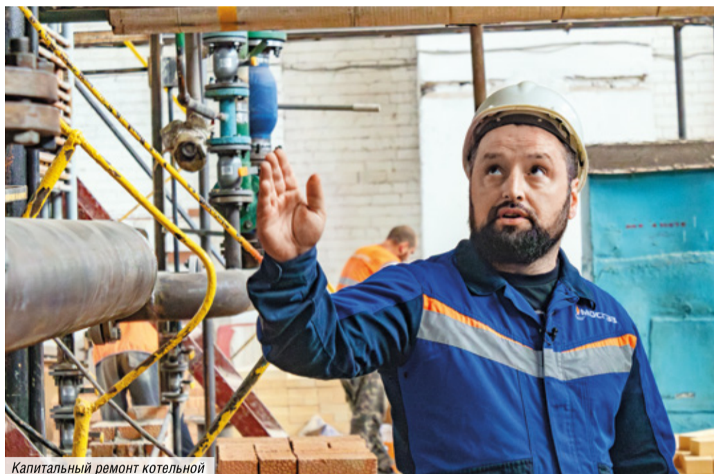
Капитальный ремонт котельной
