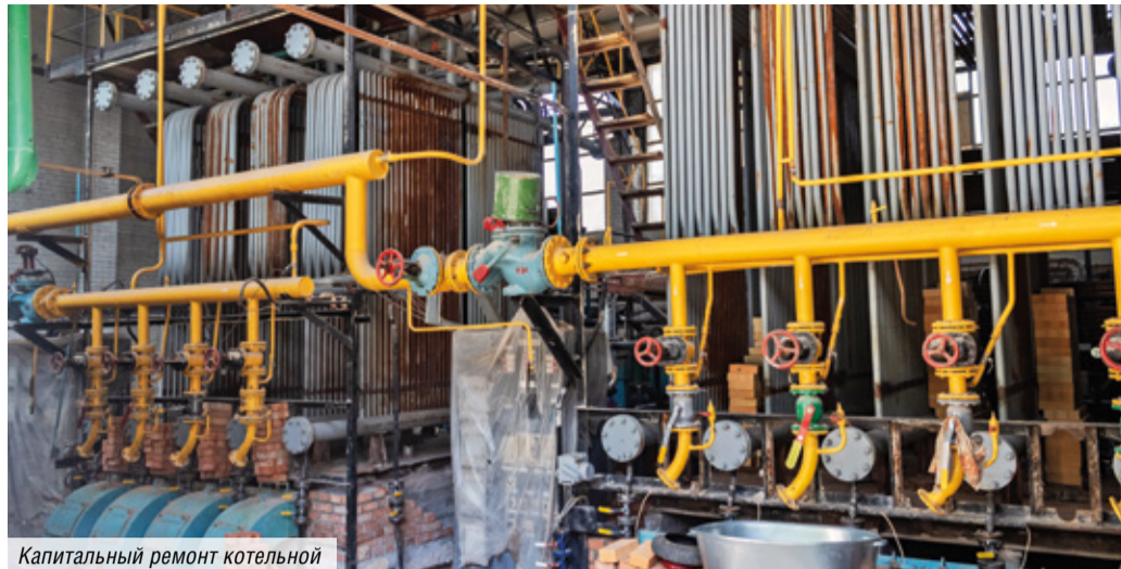
Капитальный ремонт котельной
