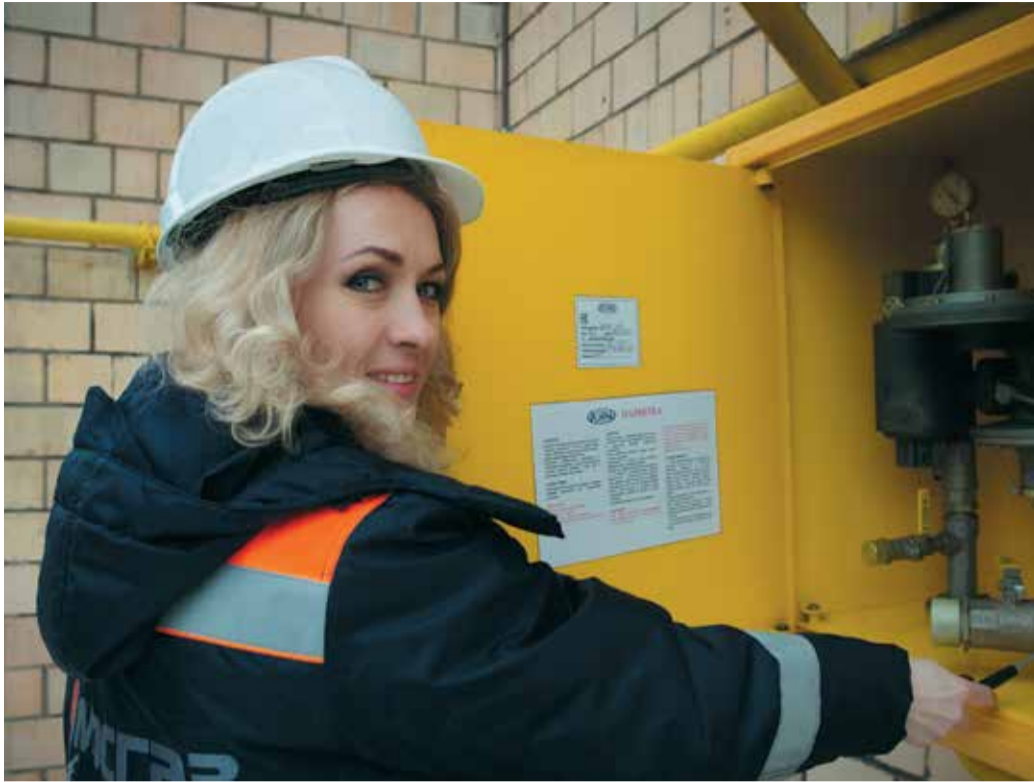
Мананкова Евгения, мастер по ремонту и обслуживанию шкафных и блочных газорегуляторных пунктов Управления ГВСД и ГРС
