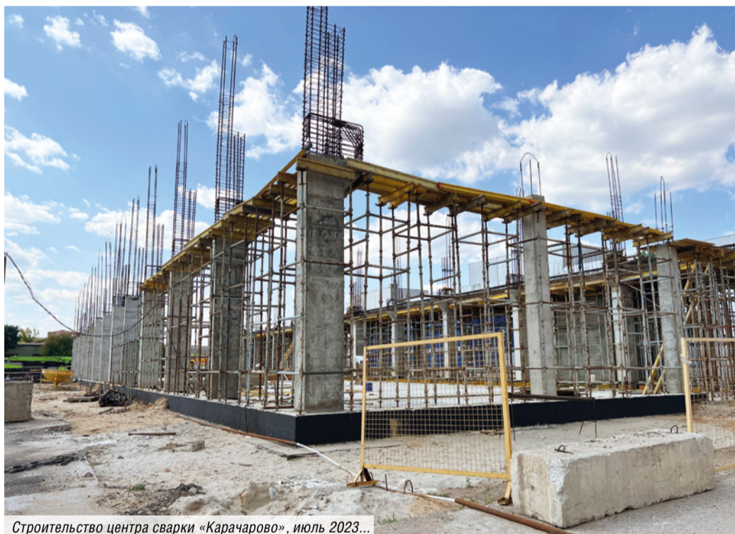
Строительство центра сварки «Карачарово», июль 2023...
