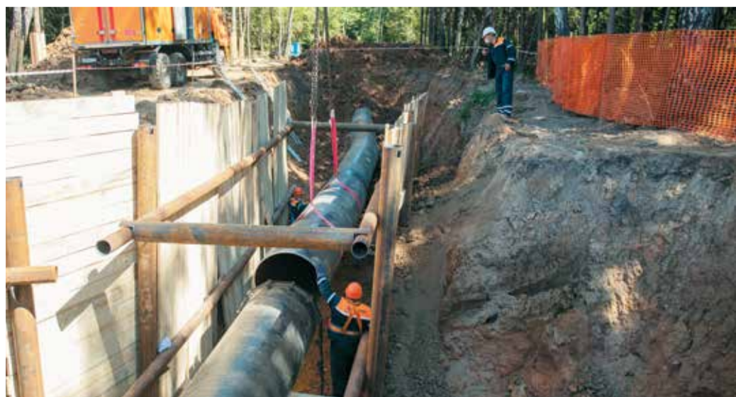
Работы по строительству газопровода в ТиНАО СХТ Ратники
