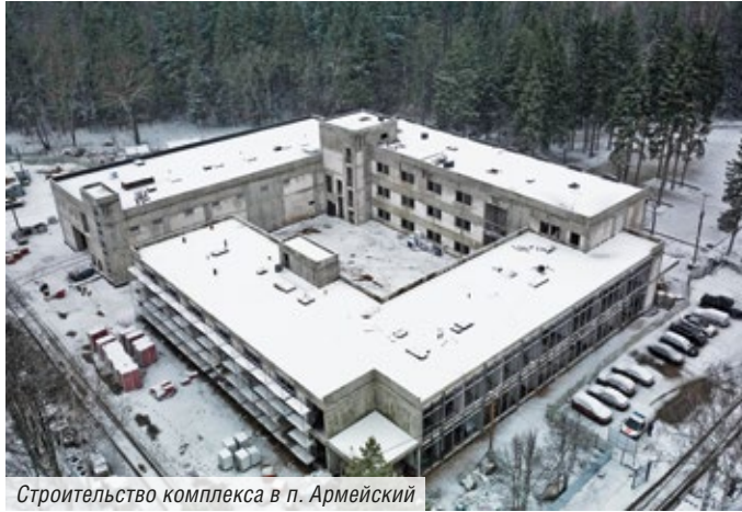
Строительство комплекса в п. Армейский
