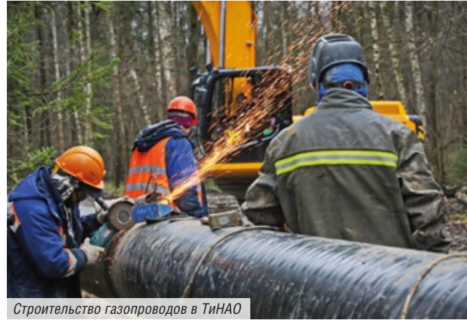
Строительство газопроводов в ТиНАО
