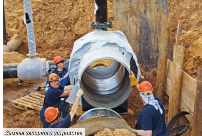
Замена запорного устройства
