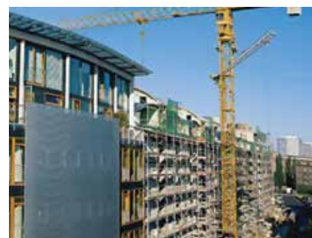
Строительство крупных торговых и складских комплексов
