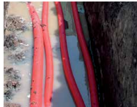
Рис.1 Применение кластеров для многорядной кабельной канализации.
