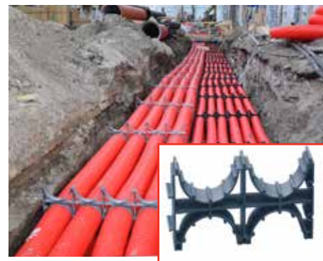
Рис.1 Применение кластеров для многорядной кабельной канализации.
