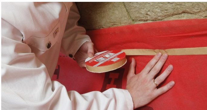
Рис. 5. Укладка и фиксация пароизоляционной пленки
