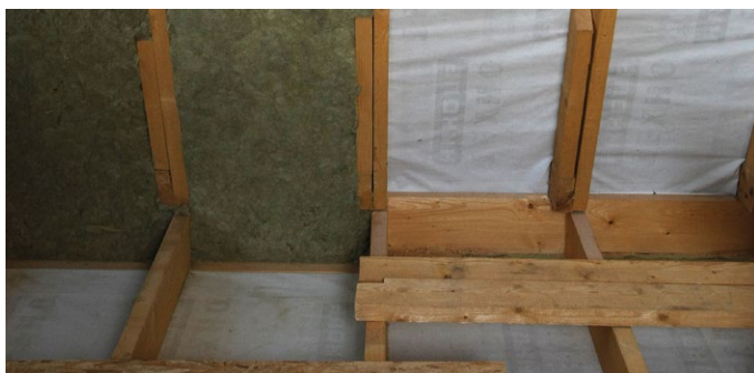
Рис. 2. Подготовленная система для дальнейшего монтажа теплоизоляции
