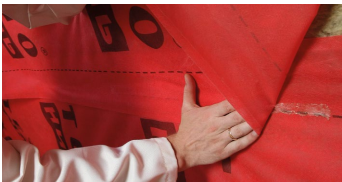
Рис. 6. Проклейка стыков пароизоляционной пленки
