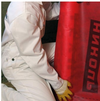
Рис. 5. Укладка и фиксация пароизоляционной пленки
