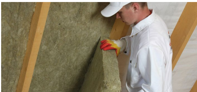
Рис. 3. Монтаж теплоизоляции враспор между стропилами
