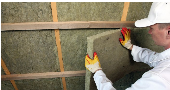
Рис. 4. Укладка второго слоя теплоизоляции
