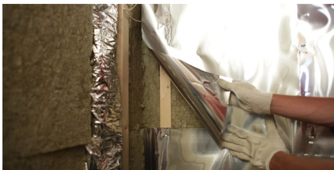
Рис. 3.2.а. Проклейка стыков пароизоляции
