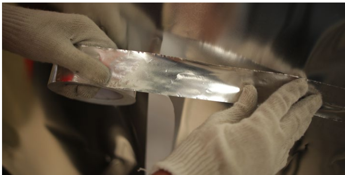
Рис. 3.2.6. Проклейка стыков пароизоляции
