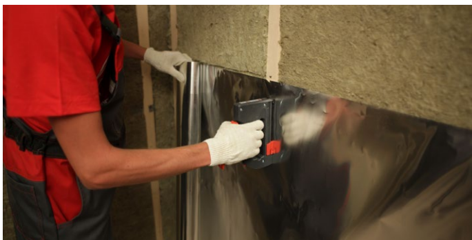
Рис. 3.1. Монтаж пароизоляции
