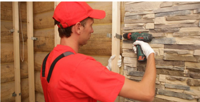
Рис. 1.1. Установка каркаса под теплоизоляцию
