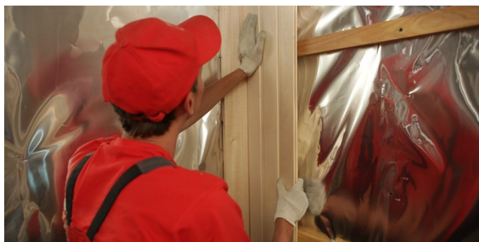
Рис. 4.1. Устройство внутренней обшивки
