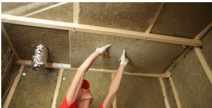
Рис. 2.1. Укладка плит теплоизоляции
