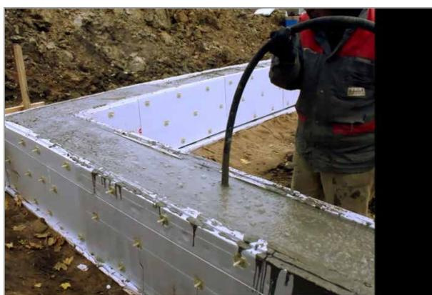
Виброуплотнение бетона с помощью глубинного вибратора.
