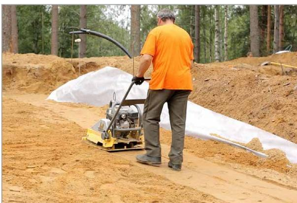
Уплотнение песка следует производить виброплитами послойно, с проливкой водой. Толщина слоев должна быть не более 150 мм.
