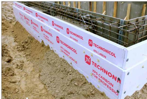
Для сохранения пространственной жесткости конструкции несъемной опалубки следует произвести обратную засыпку пазух котлована на высоту не менее 60 % от общей высоты ленточного фундамента или установить подпорки.
