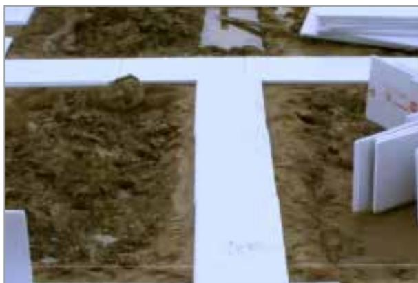
На подготовленное основание уложить плиты экструзионного пенополистирола, совместив торцы плит. L-кромки обеспечивают плотное совмещение плит теплоизоляции между собой и позволяют минимизировать образование мостиков холода.
