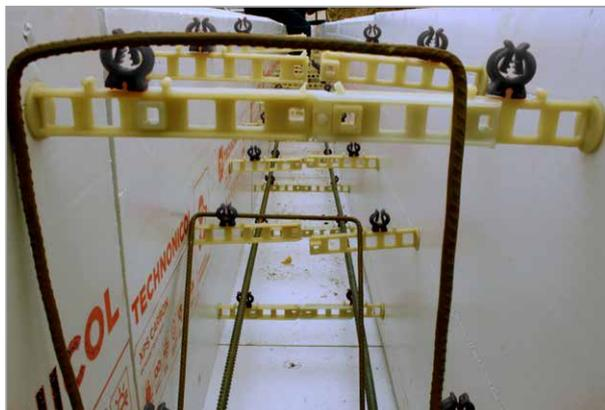
Размер хомутов и расчет их количества указан в рабочих чертежах. После укладки хомутов следует установить рабочую арматуру, закрепив ее с помощью фиксаторов.
