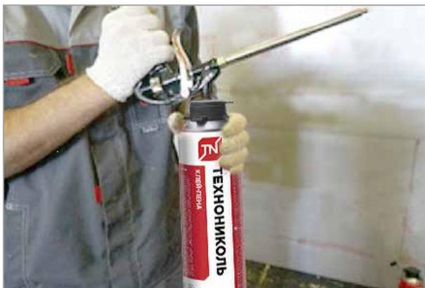
Щели между теплоизоляционными плитами ТЕХНОНИКОЛЬ CARBON ECO необходимо заполнить клей-пенной ТЕХНОНИКОЛЬ Professional для пенополистирола.
