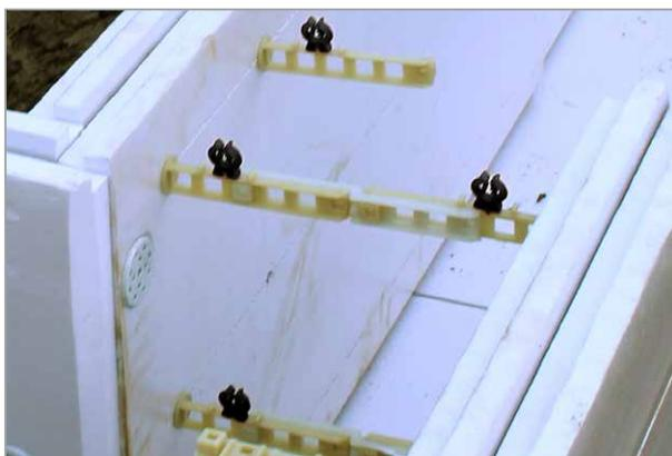
Необходимо установить модульный элемент стяжки (фиксатором арматуры вверх) на плите XPS ТЕХНОНИКОЛЬ CARBON, проколов плиту стержнем.
