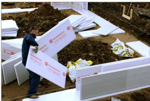
Плиты из экструзионного пенополистирола, используемые для устройства внешнего и внутреннего слоев несъемной опалубки, следует установить в проектное положение и закрепить между собой с помощью модульного элемента стяжки.
