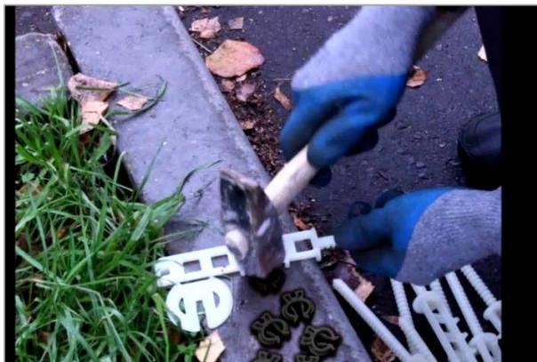
Фиксатор арматуры нужно установить на модульный элемент стяжки для несъемной опалубки на расстоянии, необходимом для обеспечения защитного слоя. В зависимости от места установки фиксатора толщина защитного слоя бетона может составлять от 30 до 70 мм.
