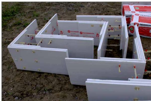
Перед началом монтажа следует собрать угловые элементы несъемной опалубки с использованием модульного элемента стяжки и винтового крепежа. В случае применения двухслойной теплоизоляции необходимо обеспечить разбежку швов между слоями на величину 400 мм.
