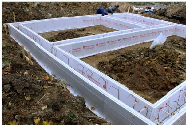
Перед началом монтажа рабочей арматуры следует уложить в форму распределительные хомуты. Для пространственной фиксации рабочей арматуры используются распределительные хомуты из арматуры  $\varnothing 8$  или  $\varnothing 6$  AIII, устанавливаемые с шагом 300 мм.
