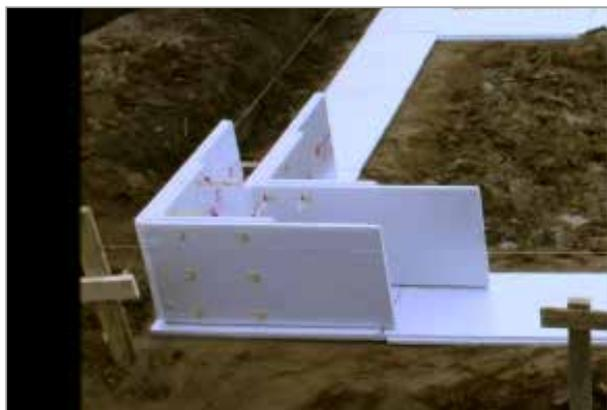
Собранные угловые элементы, используемые для устройства внешнего и внутреннего слоев несъемной опалубки, следует установить в проектное положение и закрепить между собой с помощью модульного элемента стяжки для несъемной опалубки.
