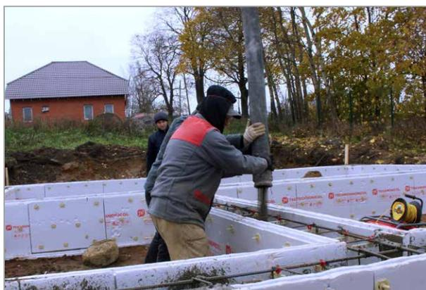
Подача бетона в опалубку при помощи бетононасоса.
