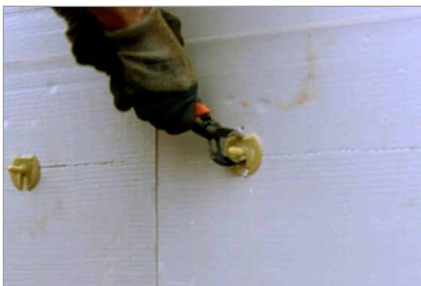
Следует закрепить модульный элемент стяжки на плите. Для этого надо установить на стержень модульного элемента стяжки для несъемной опалубки замок и нажать вниз до упора.
