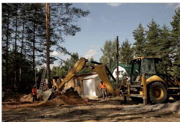
При механической разработке котлована снимается только верхний плодородный слой (30–40 см). По возможности разработку котлована следует провести до материнского грунта.
