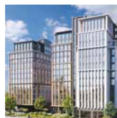
Завершение строительства апарт-отеля Industrial Avenir
