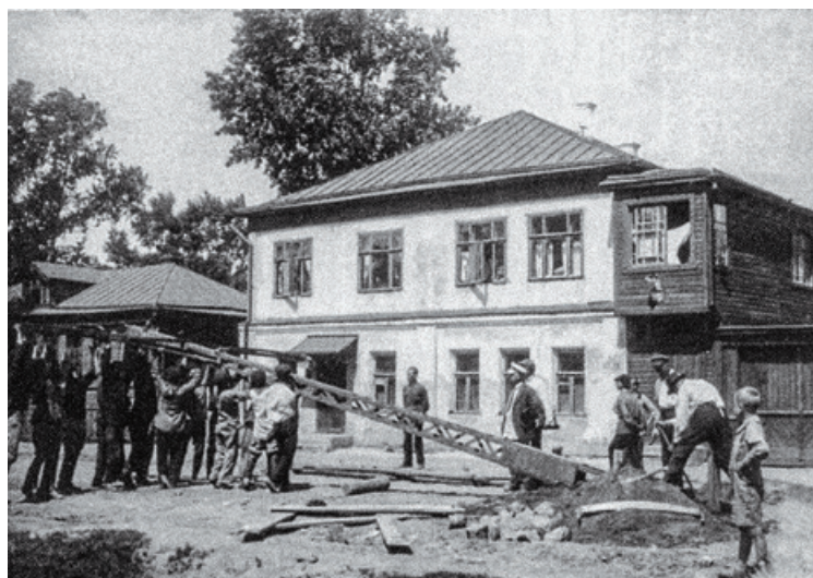
■ Щербаковская ул., установка мачты контактной сети Измайловской линии. 1925 г.
