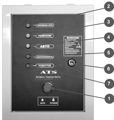
Рис. 14 Контрольная панель блока ATS
