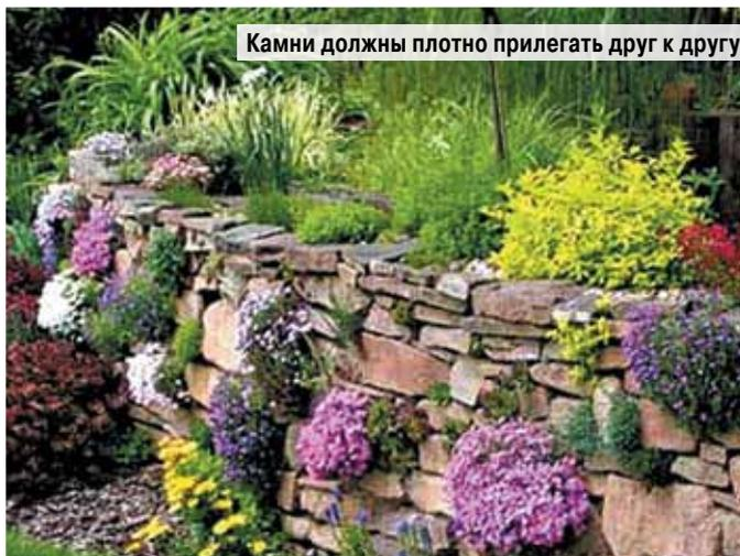
(только из камней) или так называемой мокрой (бетонной). Но в любом случае камни подбираются и укладываются очень тщательно, чтобы они крепко опирались друг на друга, не проседали после зимы и не разваливались от какого-то давления или потоков воды. Просчитывается сила давления грунта, под стенку делается подошва, а внутри стены предусматриваются разгрузочные панели.
