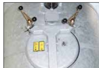
Верхний люк Ø 600 мм на шарнирах
