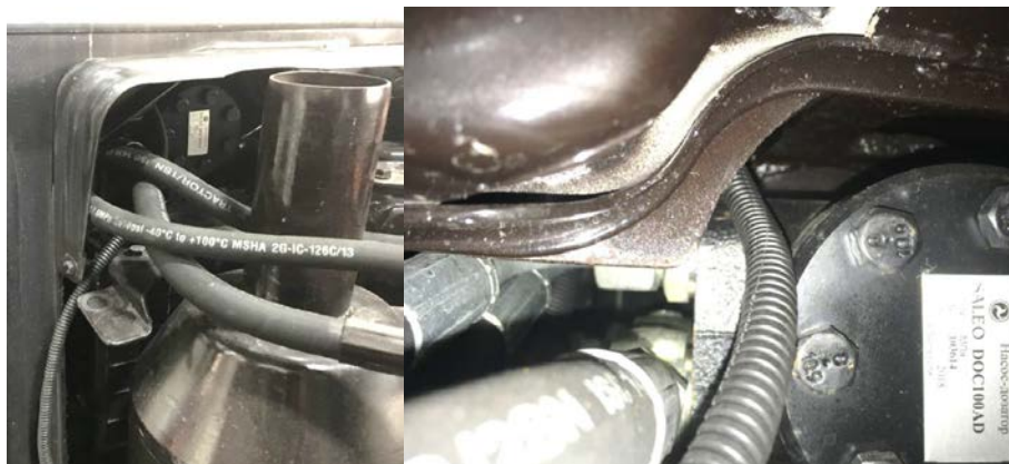
Рис. 4.3.23 – Протяжка жгута кабины в моторном щитке кабины
