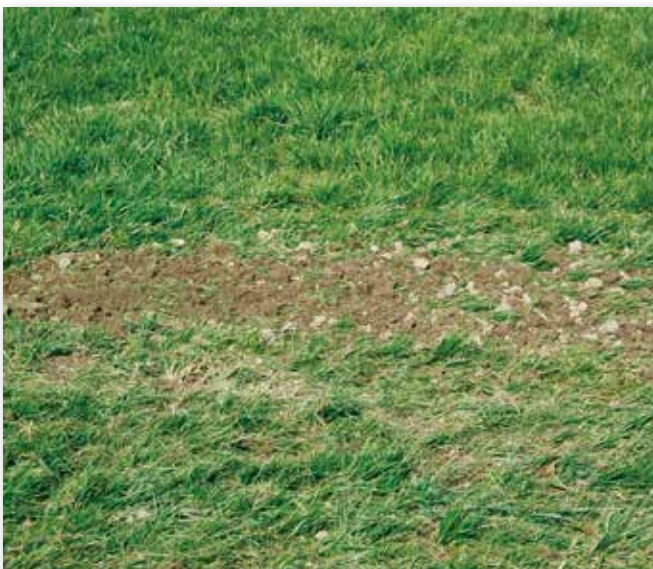
Afbeelding 7: Molshopen kunnen effectief geëgaliseerd worden met egalisatieborden aan de voorzijde van de machine
