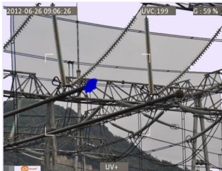
Рис. 5-8. Коронные разряды в реальных условиях электросетей
