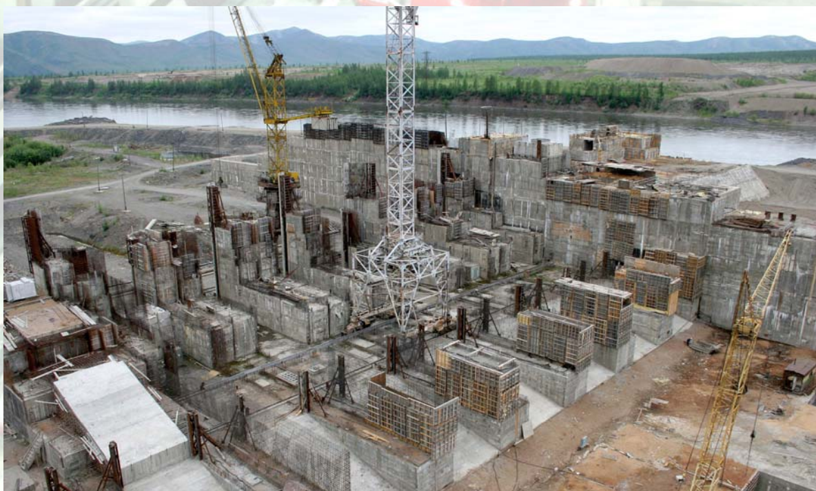
Строительство Усть-Среднеканской ГЭС
