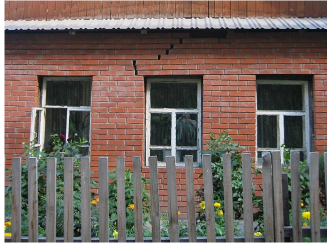
Рисунок 5.2. Трещины в наружных стенах малоэтажных зданий с шириной раскрытия более 20 мм (а, б).
