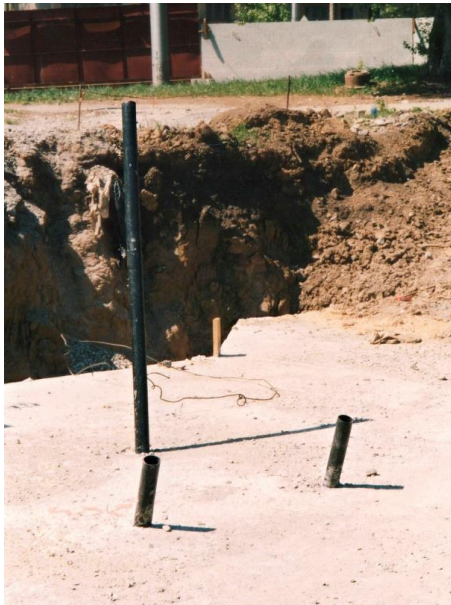
Рисунок 5.8. Инъекционные кондукторы в теле фундаментной плиты: около наружной (а) и около внутренних несущих стен (б).
