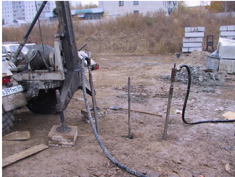
Рисунок 2.15. Группа инъекторов, установленная в проектное положение.
