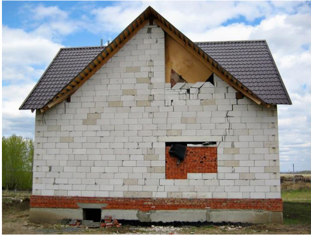
Рисунок 5.2. Трещины в наружных стенах малоэтажных зданий с шириной раскрытия более 20 мм (а, б).
