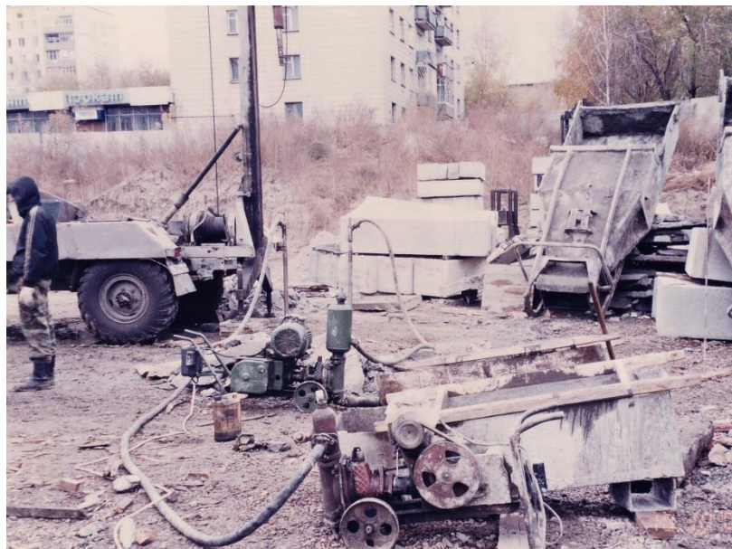
Рисунок 2.16. Одновременная подача инъекционного раствора двумя независимо работающими насосными станциями.
