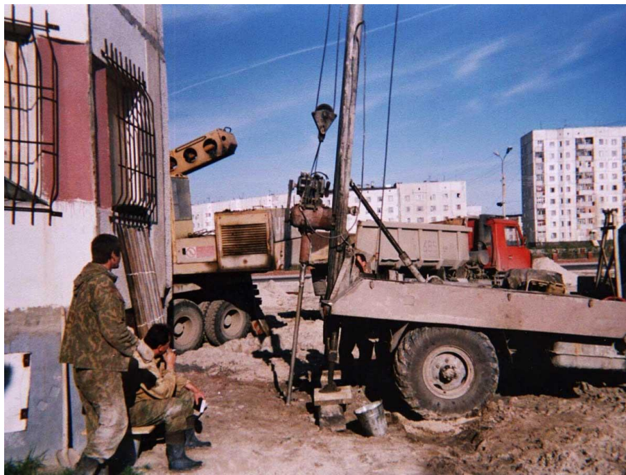
Рисунок 8. Погружение инъектора установкой вибрационного бурения АВБ-2М.
