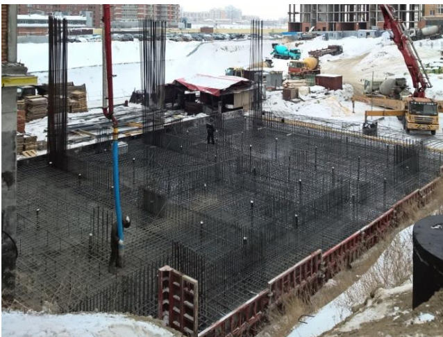
Рисунок 5.7. Инъекционные кондукторы, установленные в фундаментных плитах высотных зданий Новосибирска (а, б, в, г).
