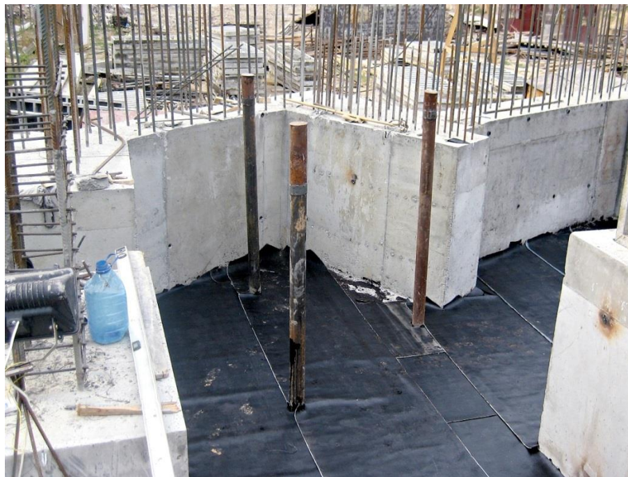
Рисунок 13. Кондукторы, размещенные в вершинах условного равностороннего треугольника.
