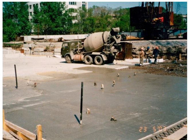
Рисунок 5.7. Инъекционные кондукторы, установленные в фундаментных плитах высотных зданий Новосибирска (а, б, в, г).
