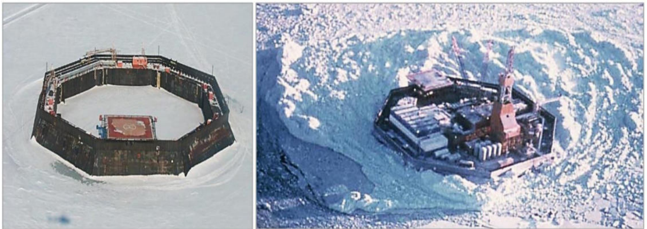
Рисунок 1.2.5 Основания буровых платформ типа CRI : (а) – собранная жесткая конструкция оболочки из 8 кессонов и б) – CRI-Kaubvik в работе, по [33,240,236]
