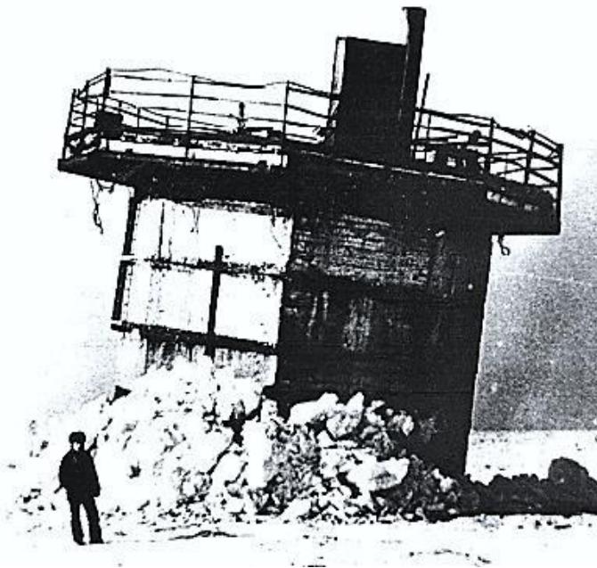
Рисунок 1.7.4 Наклон основания платформы для добычи газа в Азовском море по [277]
