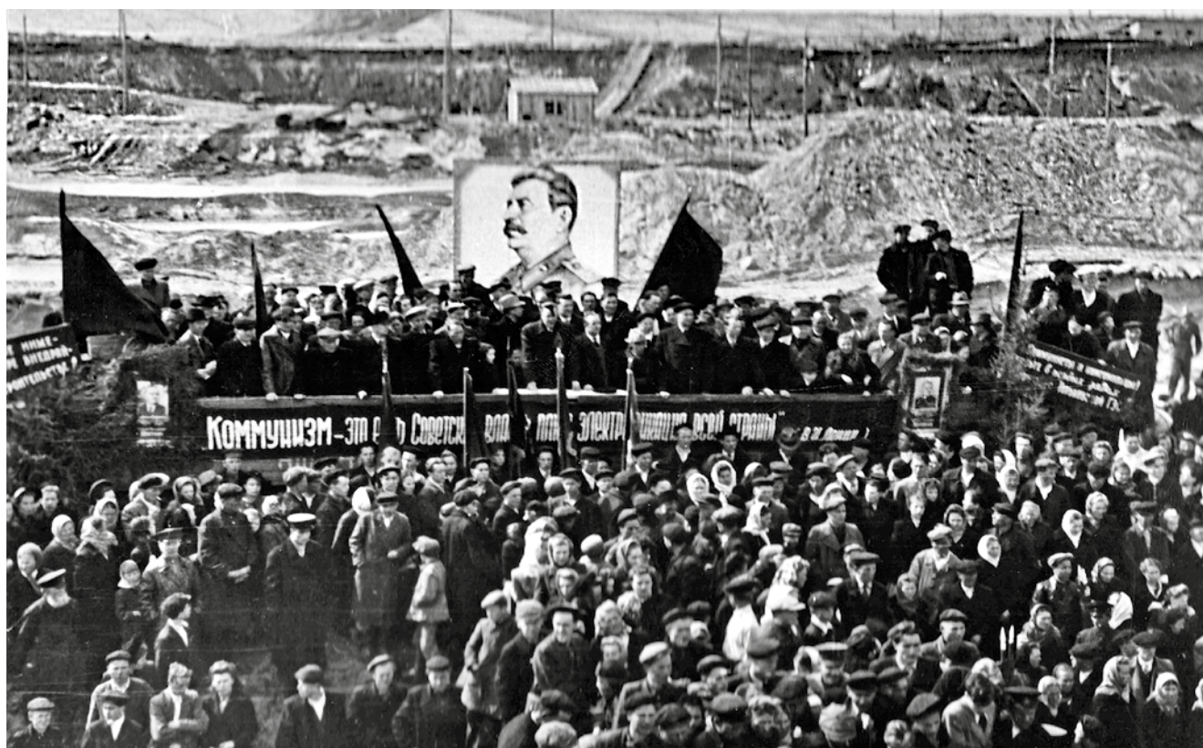
Митинг в котловане по случаю закладки первого кубометра бетона. 1951
