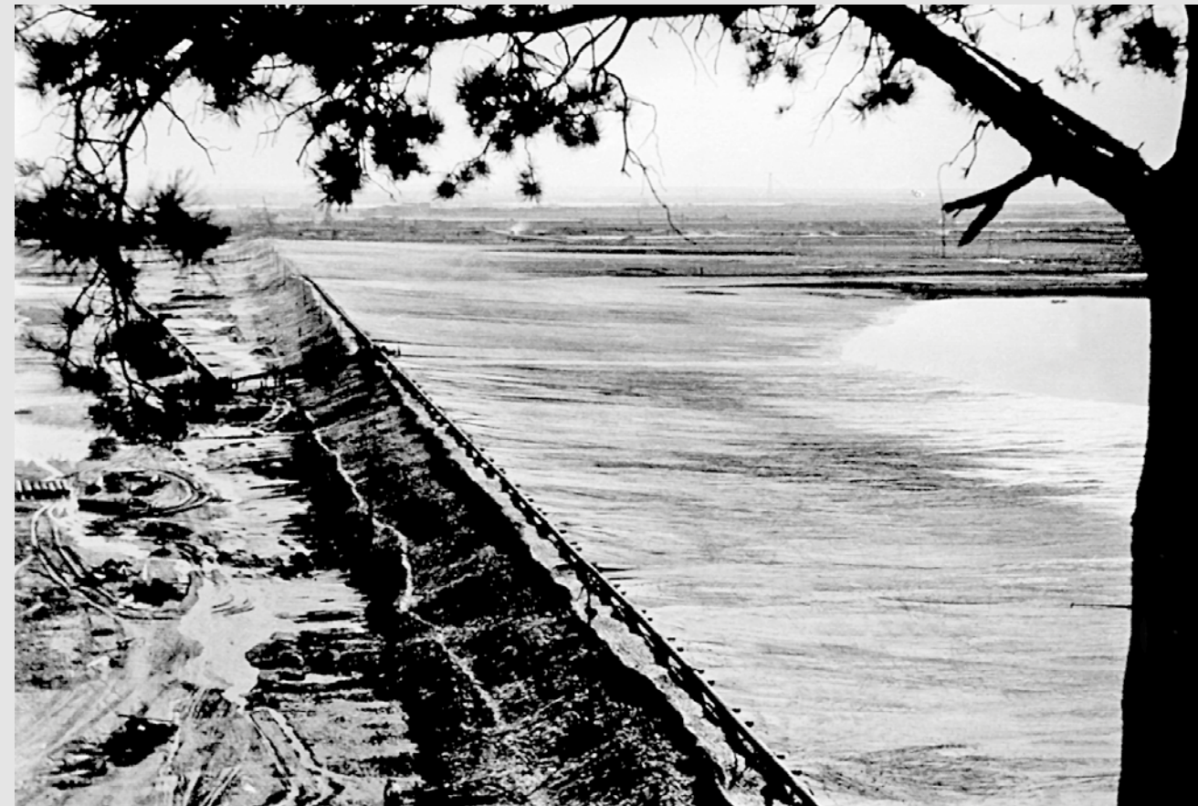
Намыв земляной плотины
