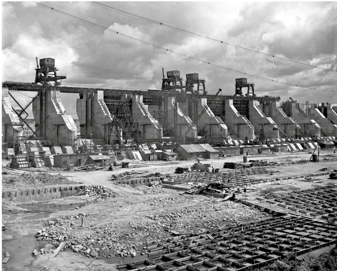
Бетонирование зубцов-гасителей
