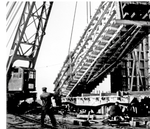
Монтаж колонн подкрановых путей
