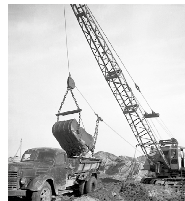
Работы в котловане будущих водосливной плотины и здания ГЭС
