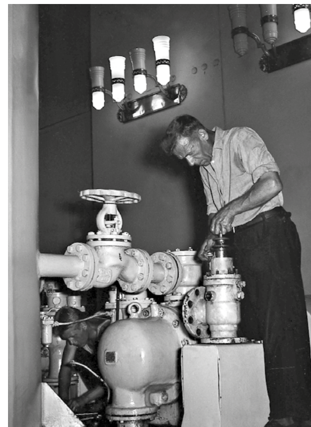
Ремонт узлов маслонапорной установки
