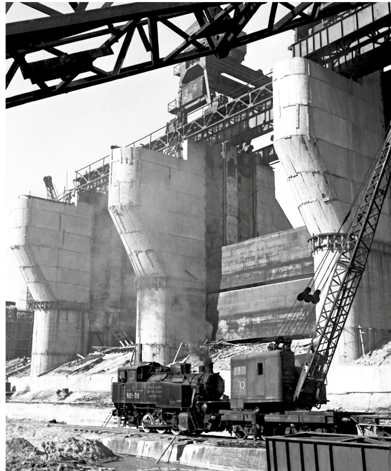
Железная дорога в котловане водосливной плотины
