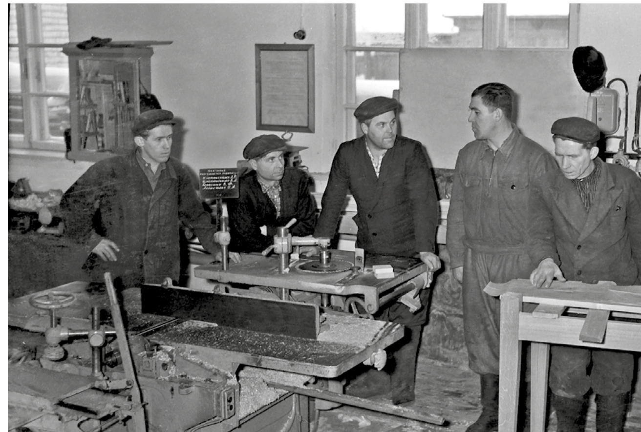
Бригада в столярной мастерской хозяйственного двора ГЭС
