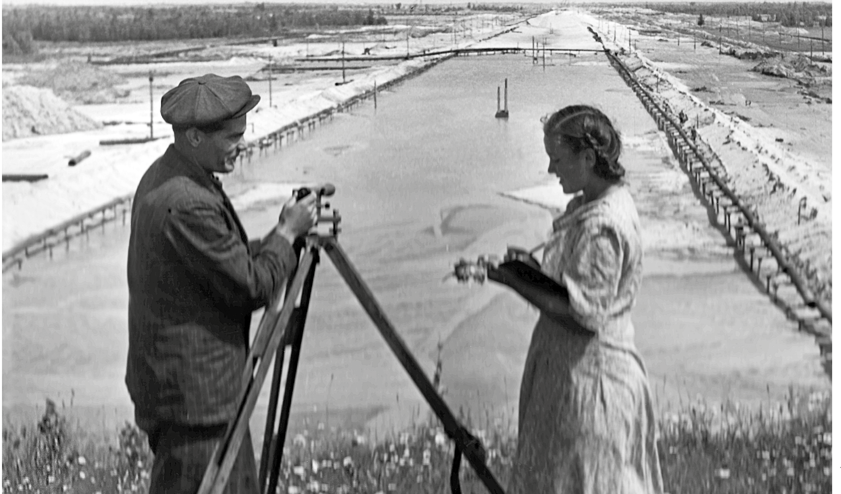
Намыв плотины № 1-2. Вид с Урковской горы. 1952
