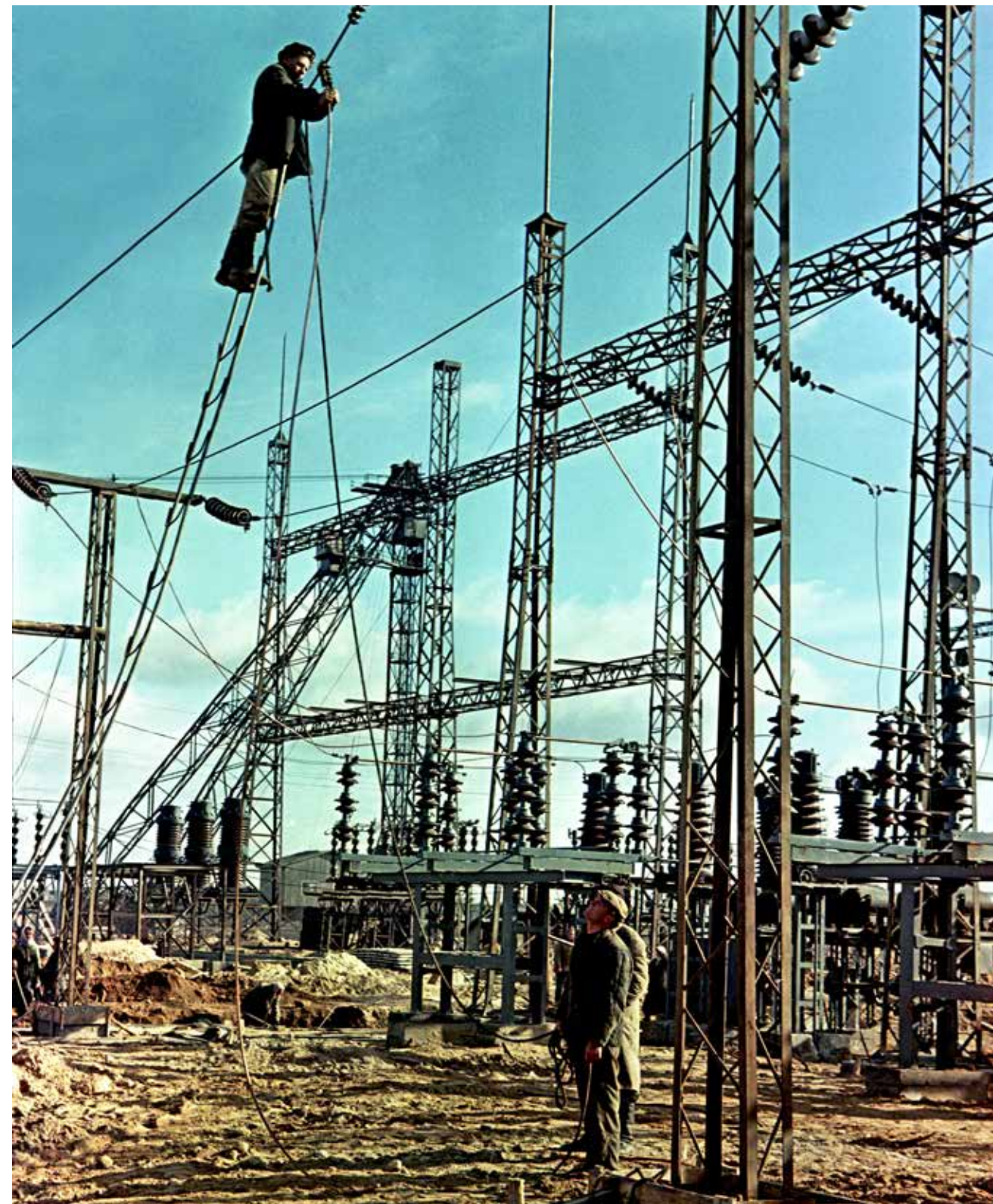
Монтаж оборудования открытого распределительного устройства
