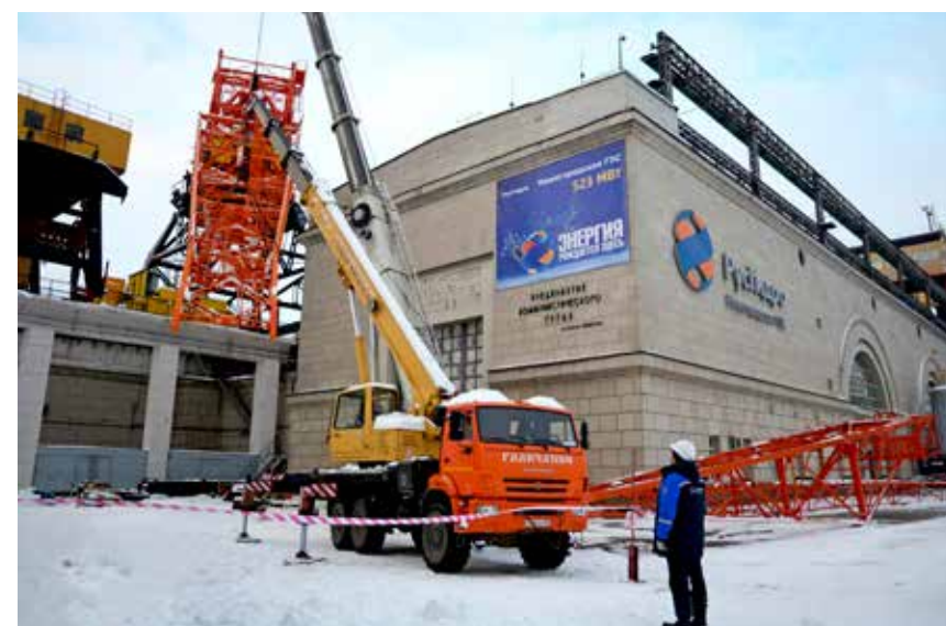
Реконструкция портално-стрелового крана
