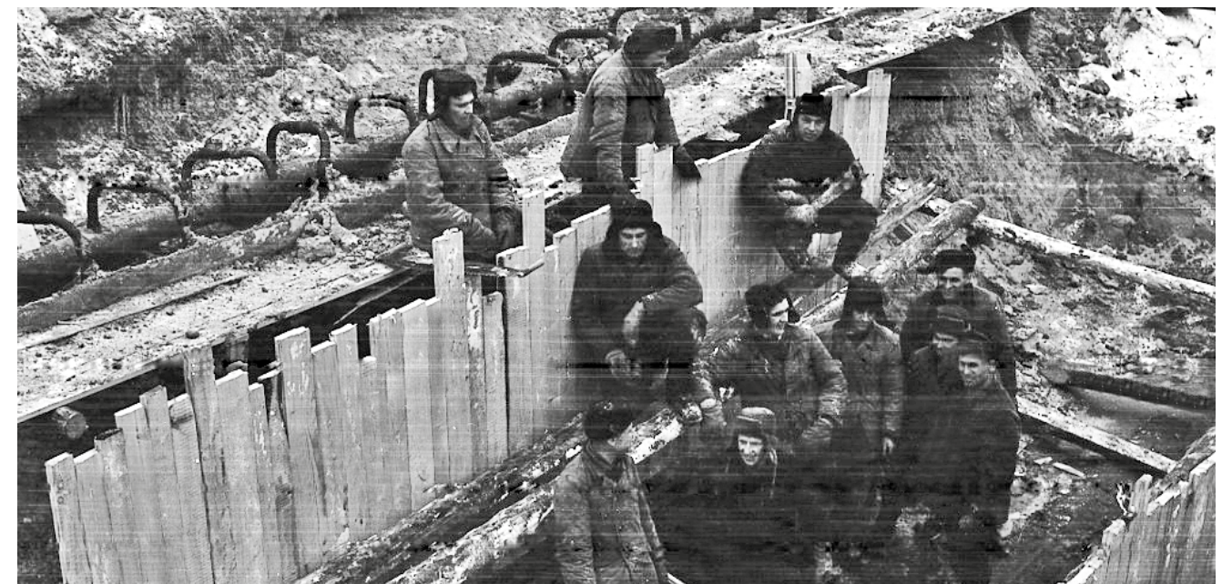
Монтаж иглофильтрационной системы водопонижения
