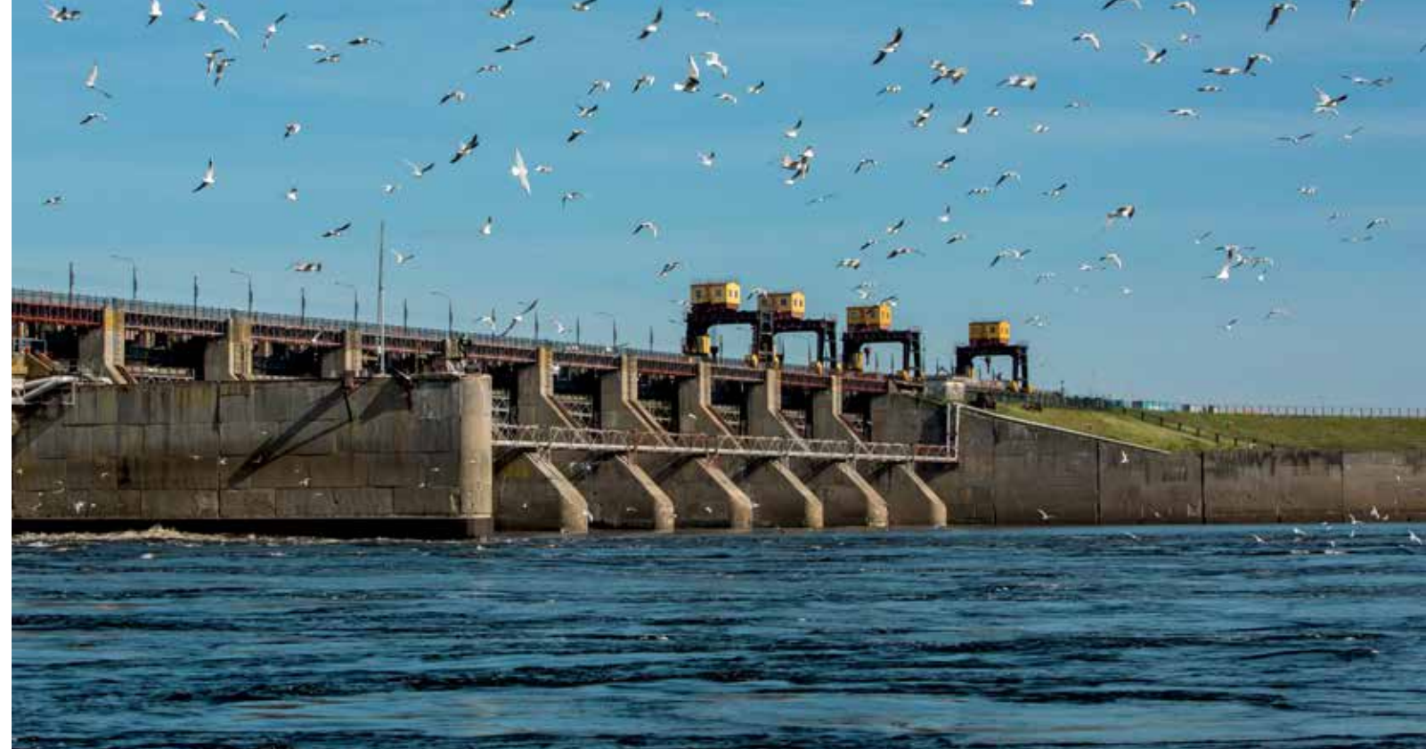
Вид на водосливную плотину Нижегородской ГЭС с нижнего бьефа
