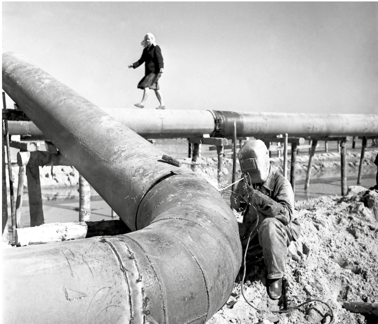
Сооружение трубопровода для подачи пульпы
