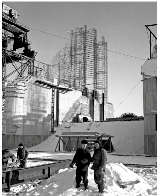
Зимние работы на водосливной плотине
