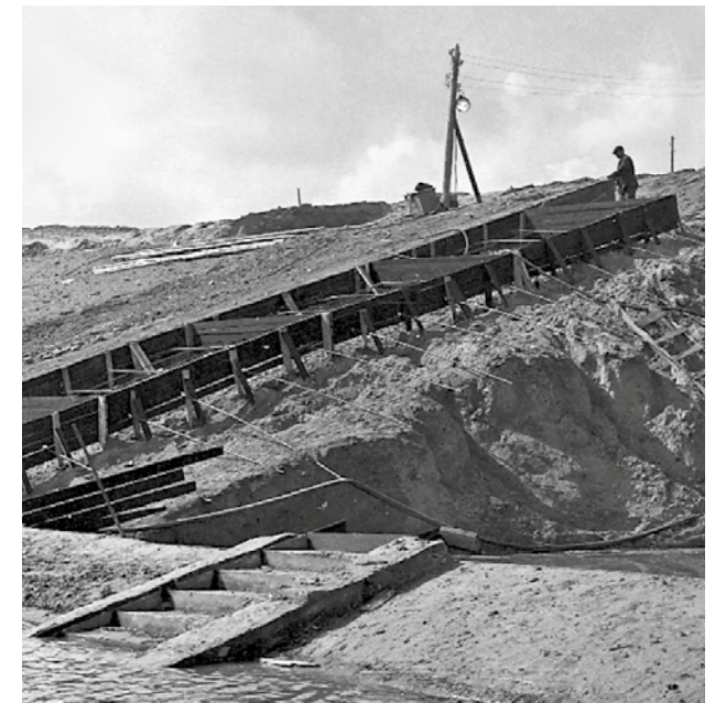
Крепление откоса плотины
