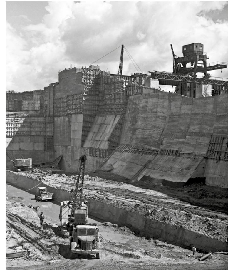
Строительство разделительного бычка
