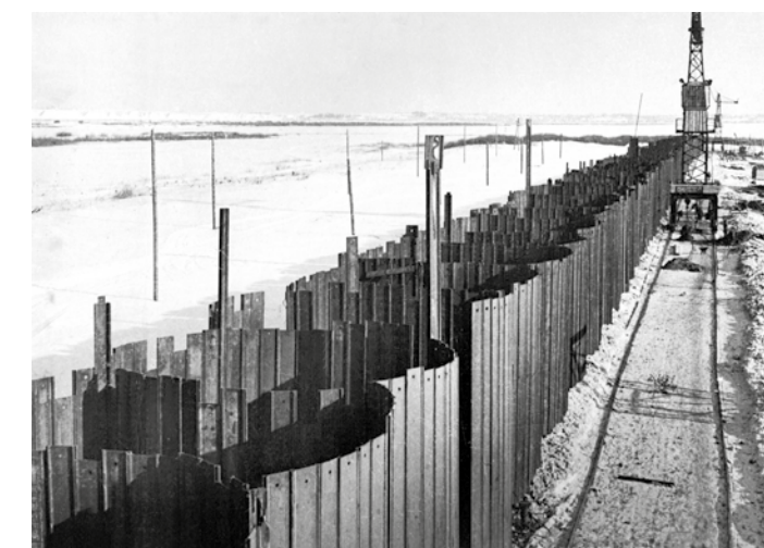
Шпунтовая ячеистая перемычка котлована
