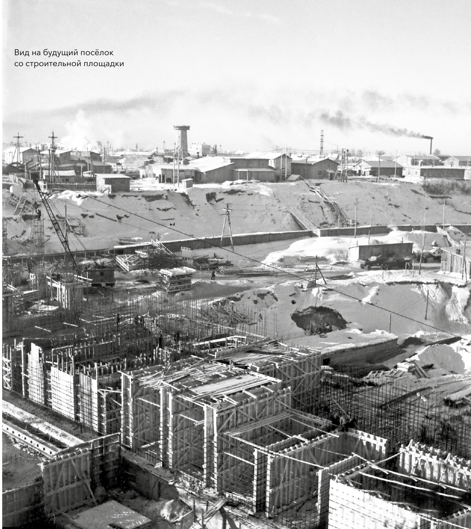
Монтаж колонн подкрановых путей
