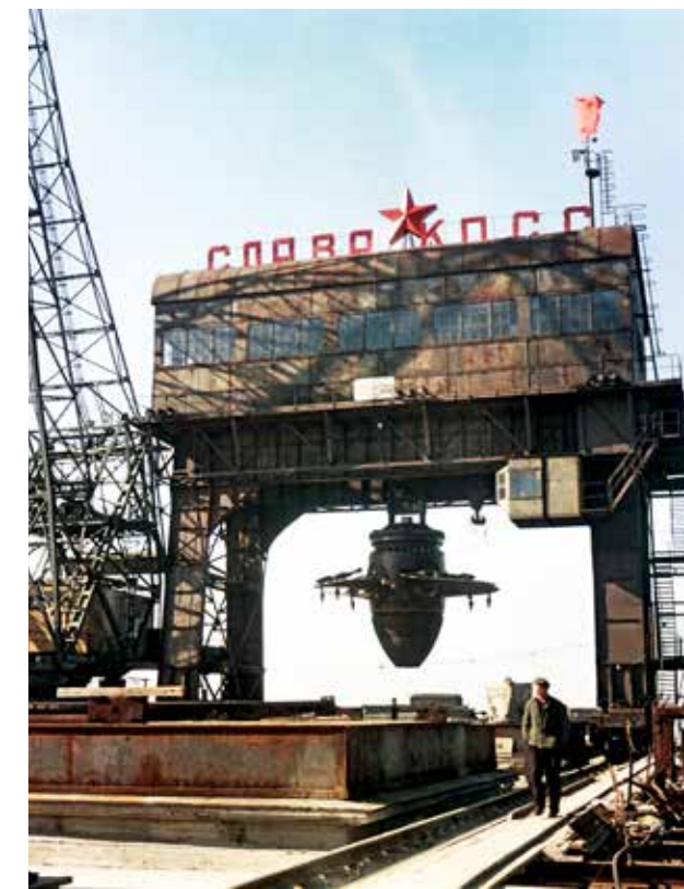
Монтаж рабочего колеса турбины
