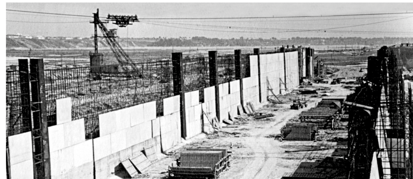
Установка плит-оболочек стен камеры шлюза
