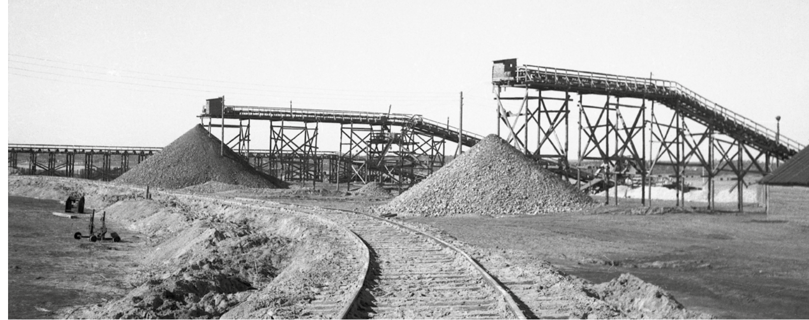
Доставка щебня и гравия на место строительства
