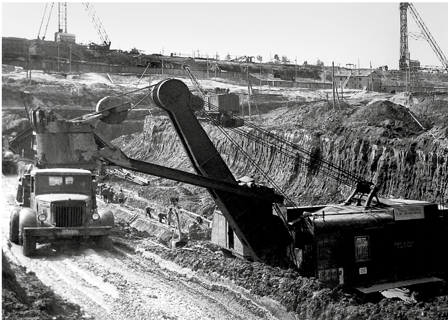
Работа в котловане будущей гидроэлектростанции
