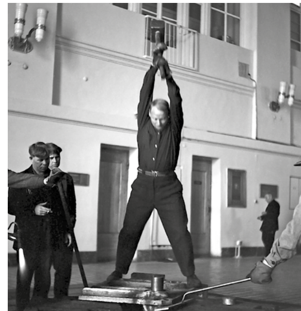
Работы на монтажной площадке
