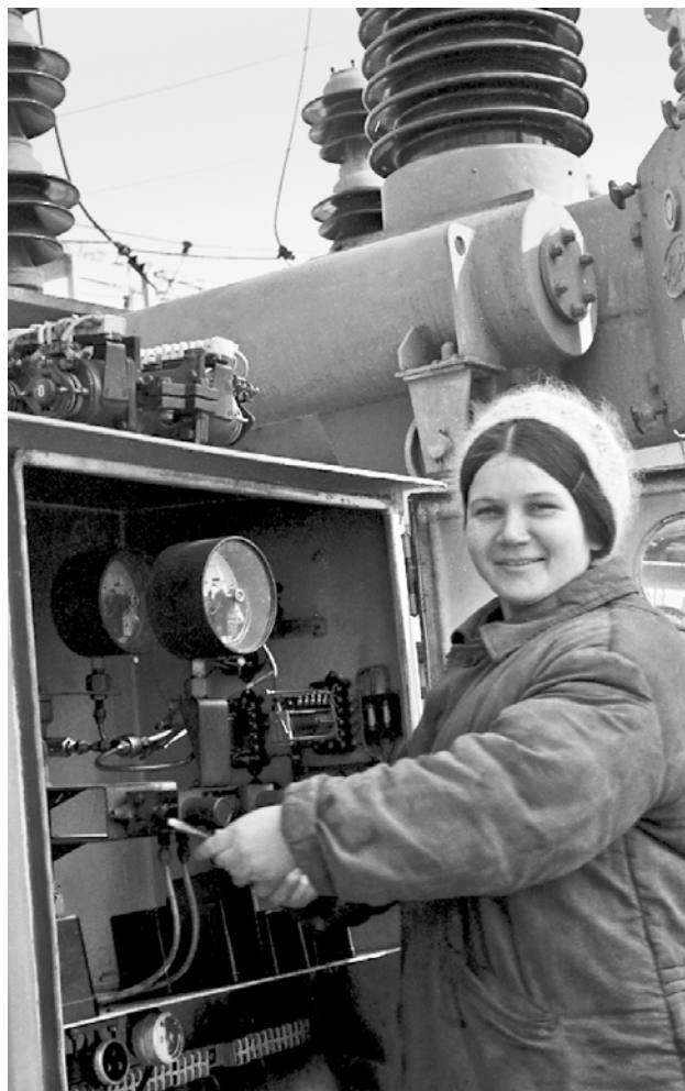
Наладочные работы в шкафу управления воздушным выключателем на ОРУ
