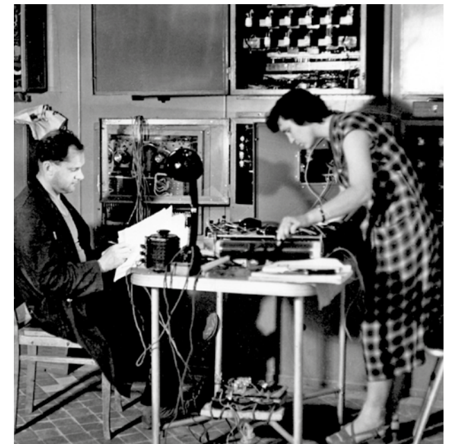
Наладка цепей релейной защиты и автоматики
