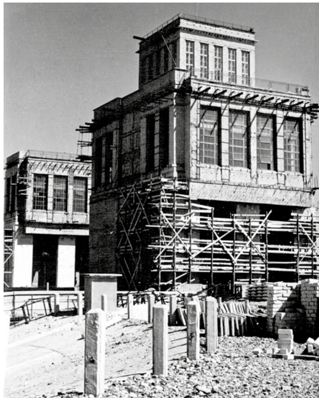
Машинное здание с пультом управления
