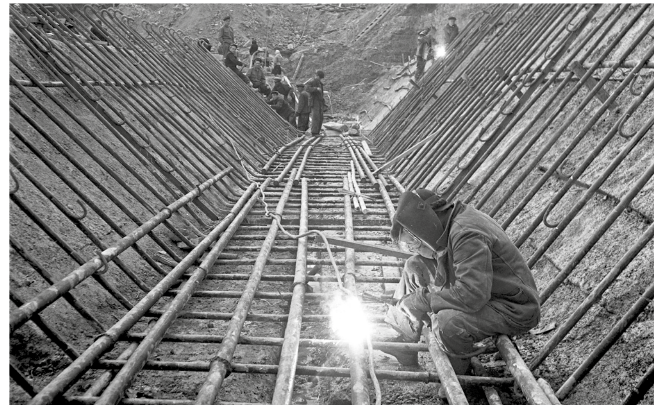
Сварка арматуры консольного водосброса
