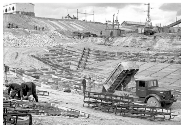
Бетонирование дна отводящего канала
