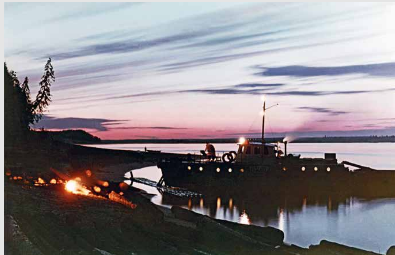
Первые изыскания в районе строительства будущей ГЭС
