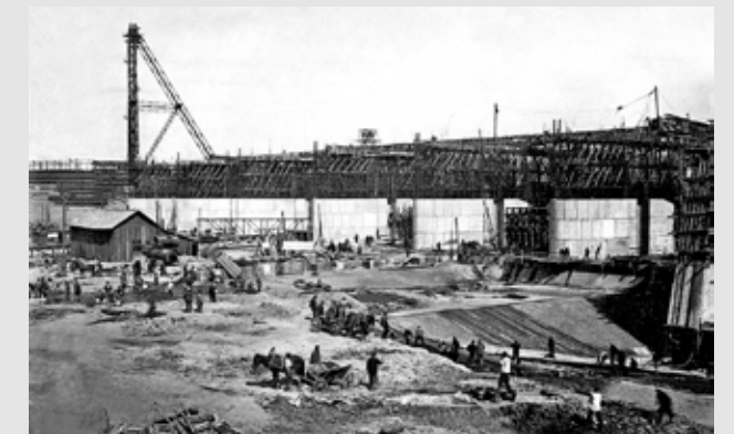
Строительство Угличской ГЭС
