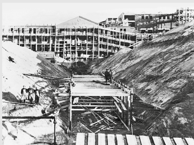
Строительство водоподводящего канала к зданию электростанции. 1924
