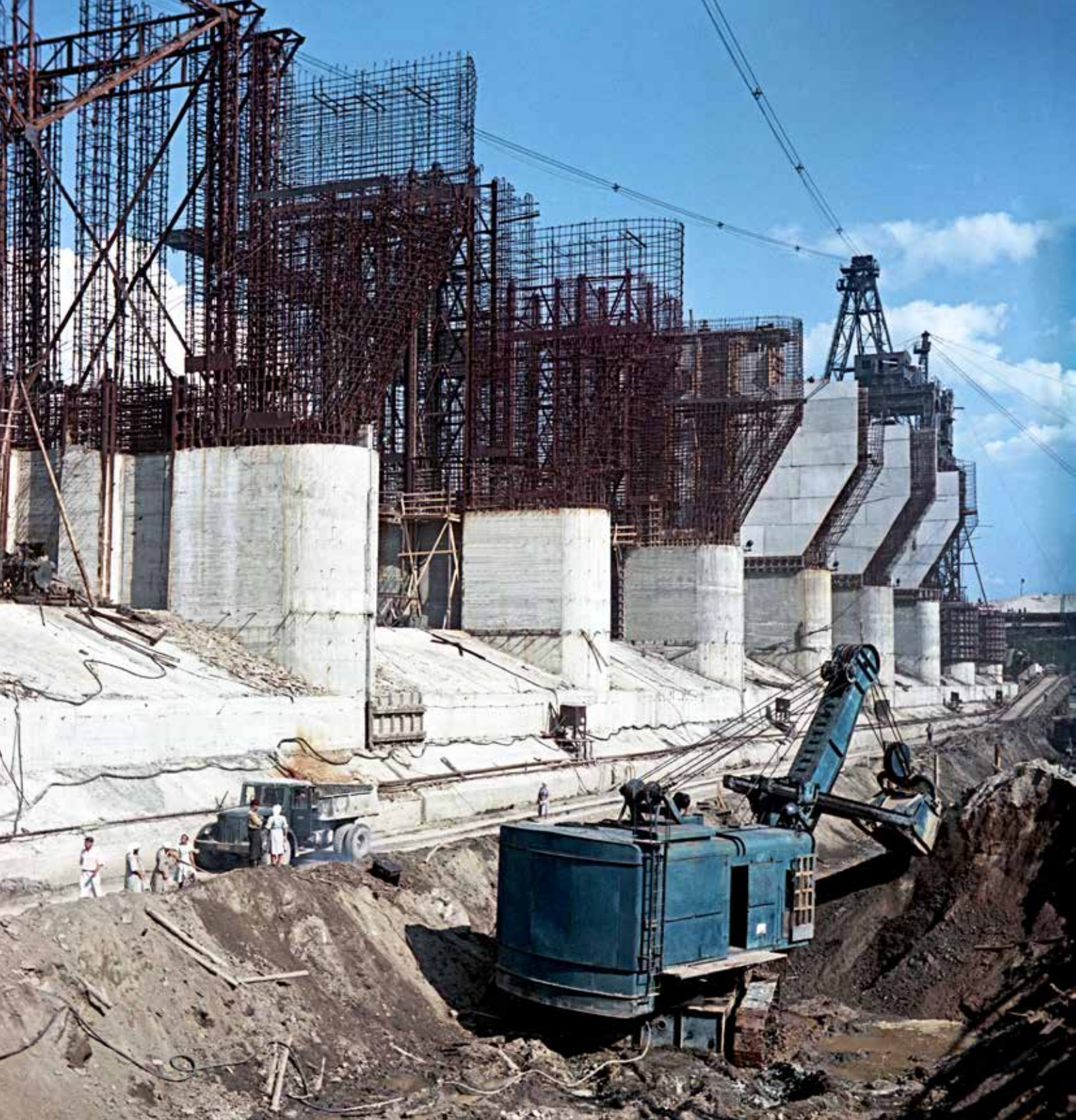
Строительство водосливной плотины
