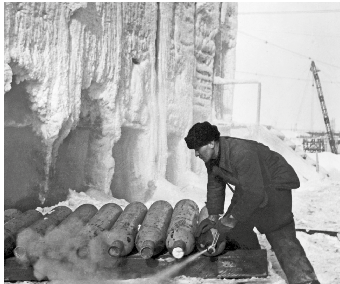
Подача баллонов для холодильной установки
