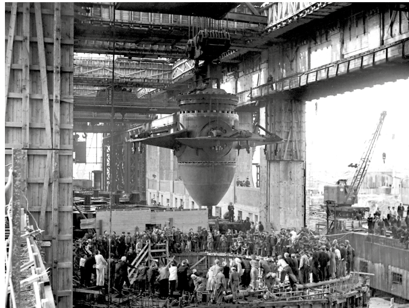
Спуск рабочего колеса в шахту гидроагрегата
