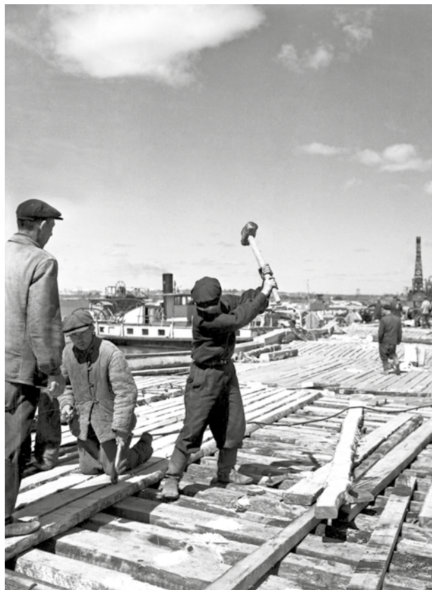
Строительство понтонного моста
