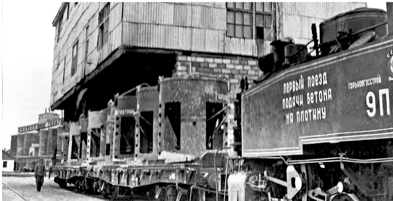
Первый поезд с бетоном прибыл на строительство ГЭС
