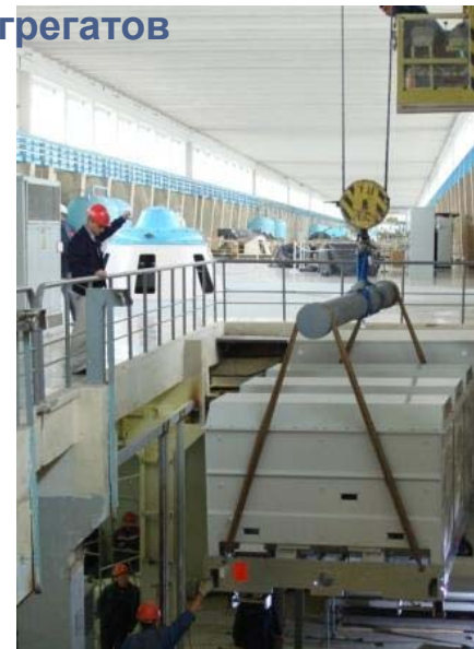
Комплексная замена 5-ти силовых блочных трансформаторов (по одному ежегодно)
