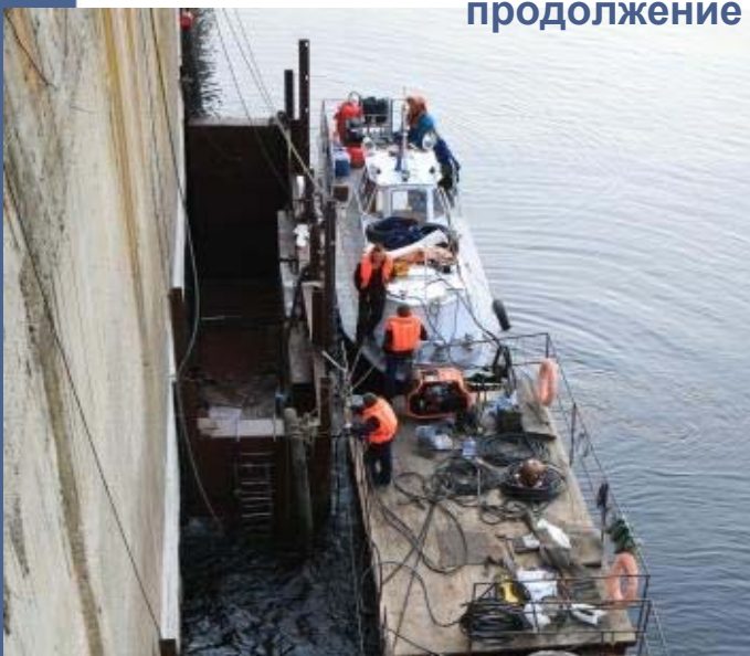
Реконструкция гидротехнических сооружений ГЭС
