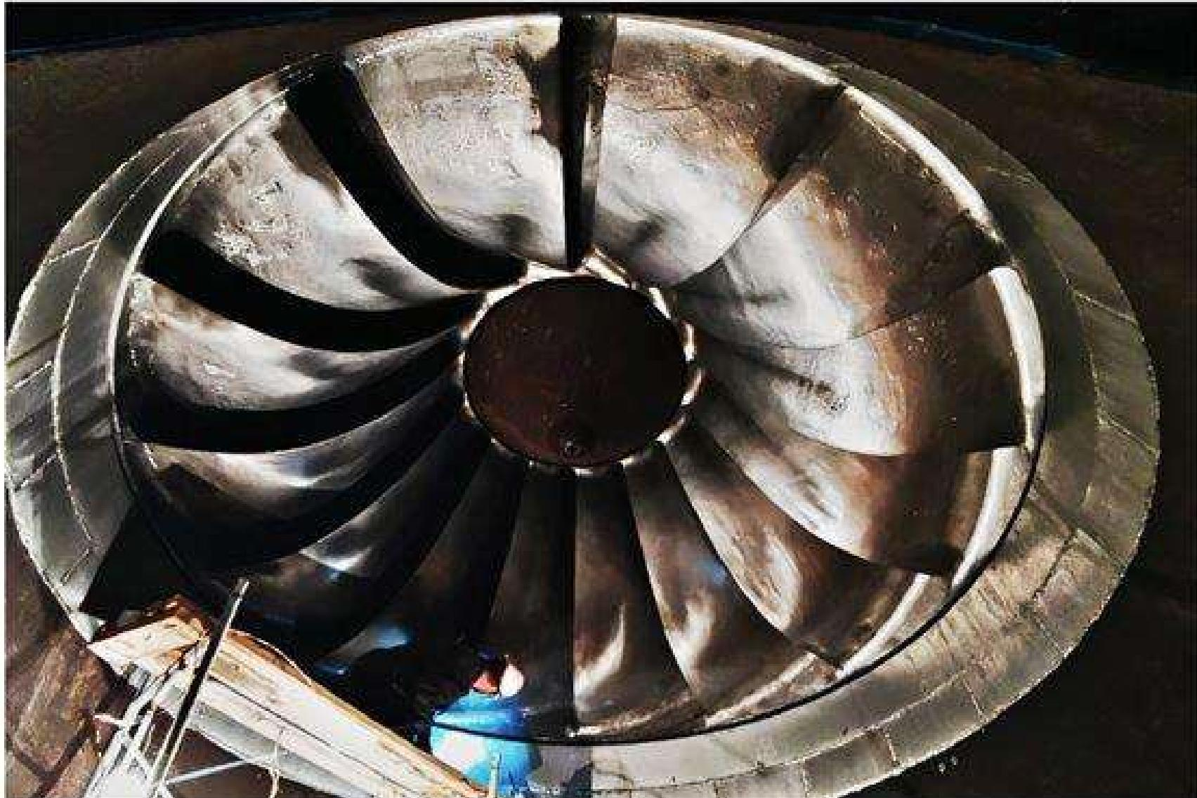
Объем и периодичность работ по контролю состояния металла конструктивных элементов гидротурбин на ГЭС описывает соответствующий стандарт организации (СТО) РусГидро. В нем приведены лишь общие требования, не учитывающие особенности конструкции конкретных гидротурбин. Новая методика, разработанная специально для Саяно-Шушенской и Майнской ГЭС, позволяет повысить эффективность обследований оборудования этих электростанций.
