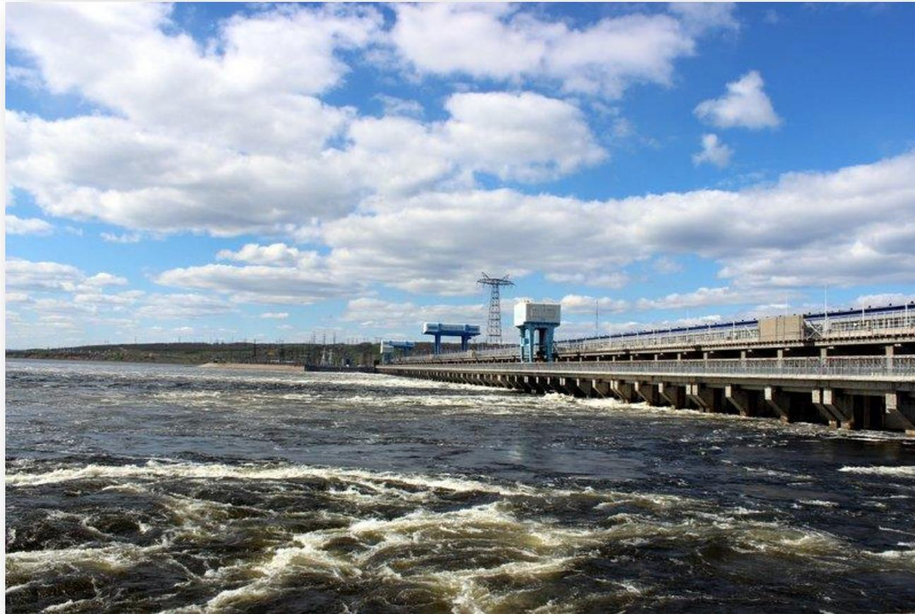
Суммарная пропускная способность гидросооружений – **53** тысячи м³/с (при НПУ).
