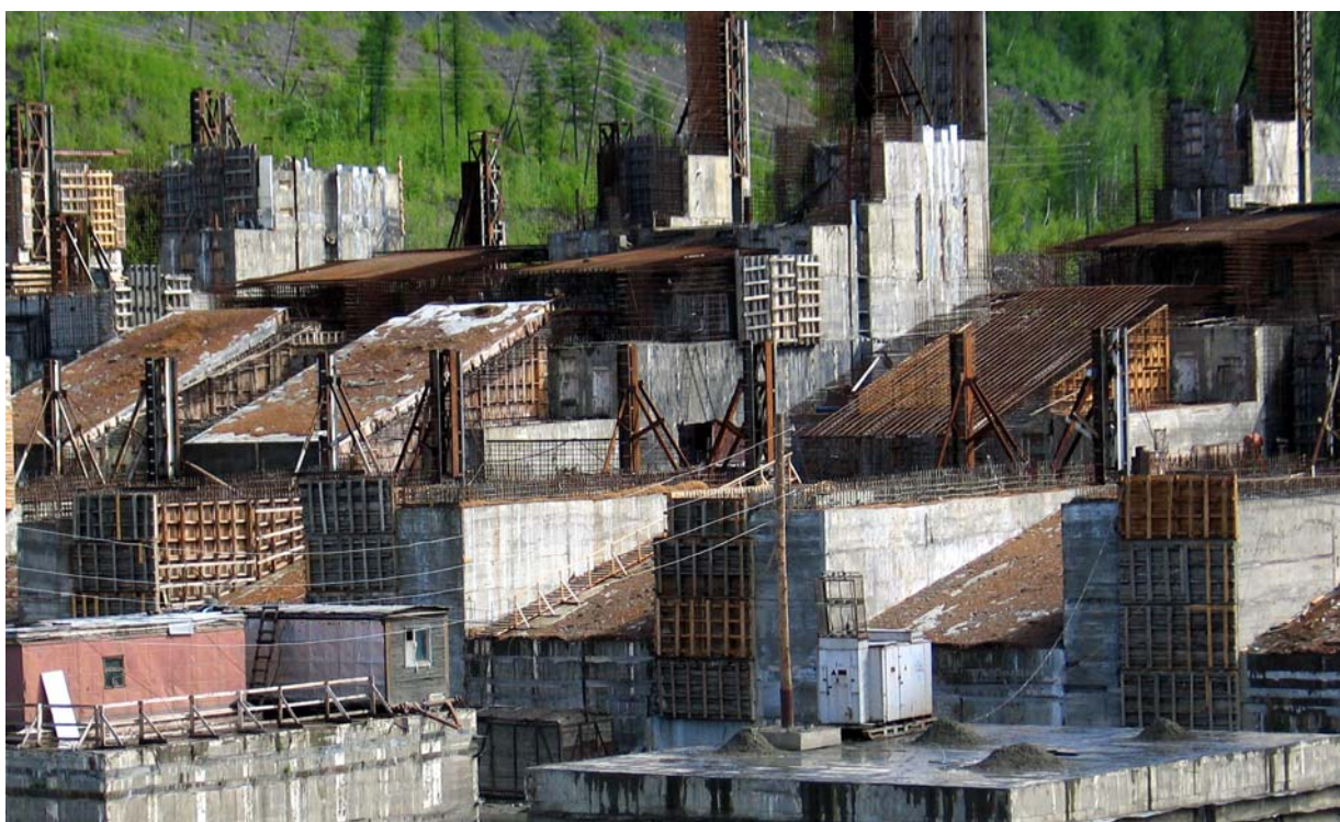
Усть-Среднеканская ГЭС. Водобросная бетонная плотина.
