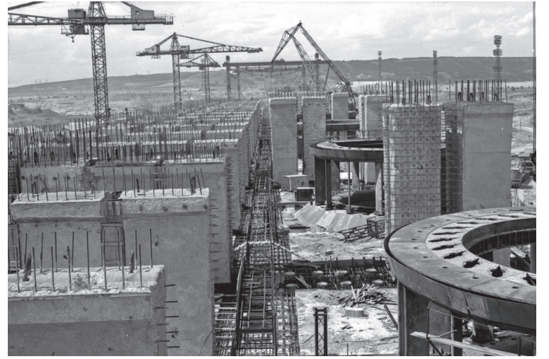
Совмещенный монтаж закладных частей гидроагрегатов со строительными элементами сборного железобетона.
