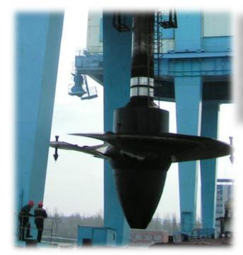
**24 гидроагрегата**, разработанных специально для Саратовской ГЭС с учетом ее особенностей (самая низконапорная станция Волжско-Камского каскада); **диаметр рабочего колеса турбины составляет 10,3 м**.
