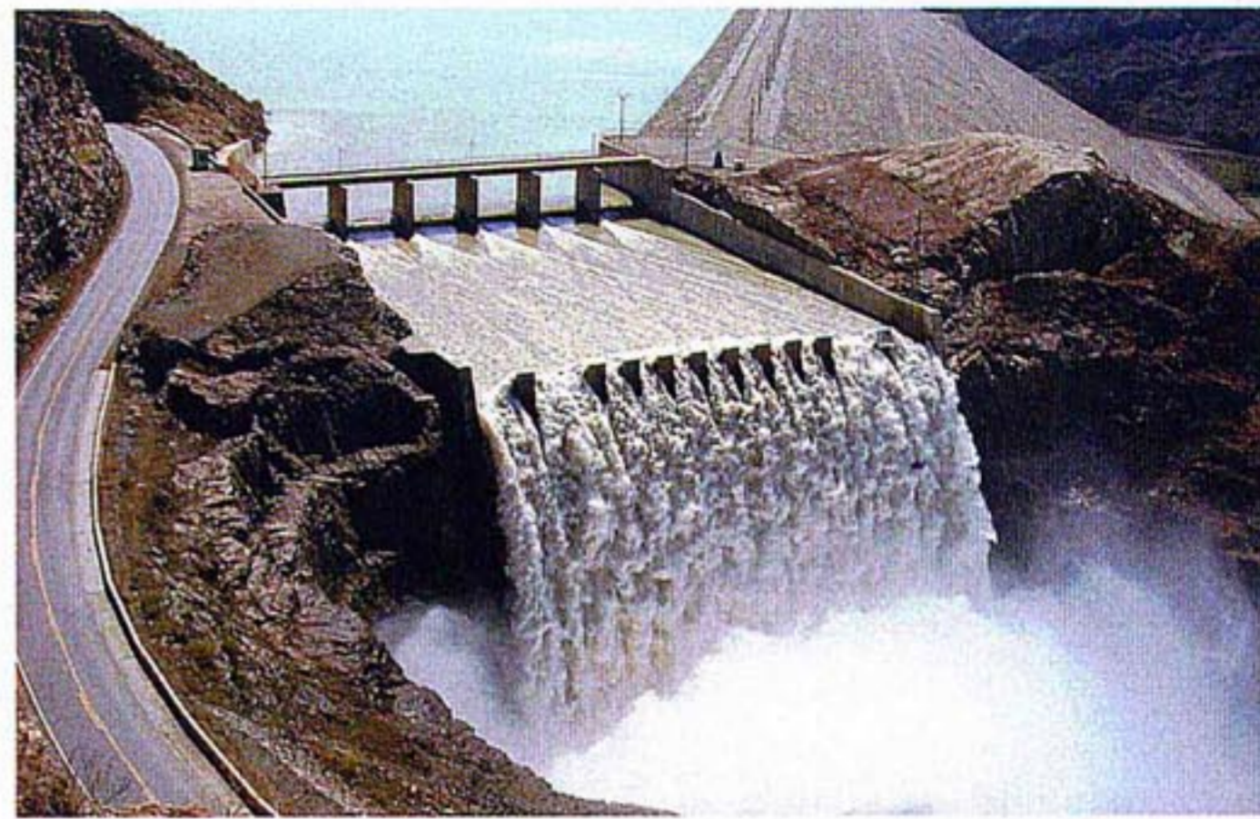
● НЕБОЛЬШАЯ ЭЛЕКТРОСТАНЦИЯ Галлито-Сиего мощностью 37 МВт. Она не входит в систему проекта Ольмос, однако ее фото дает некое представление о перуанской гидроэнергетике.
