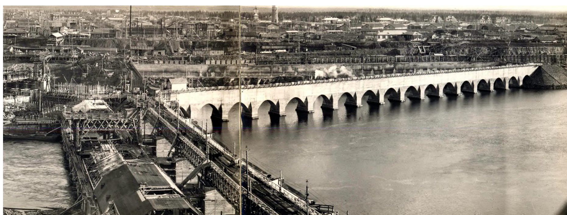
Строительство Волховской ГЭС, 1920-е гг.
