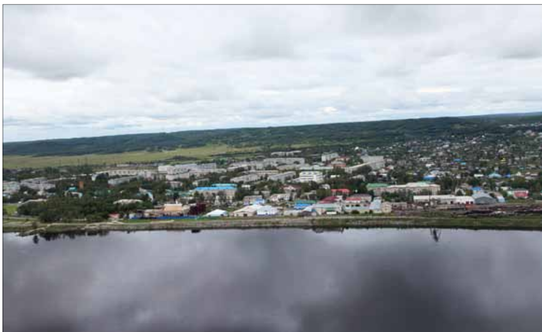
Рис. 3. Инженерная защита п. Новобурейский, август 2013 г. Фото пресс-службы филиала ОАО «РусГидро» — «Бурейская ГЭС».
