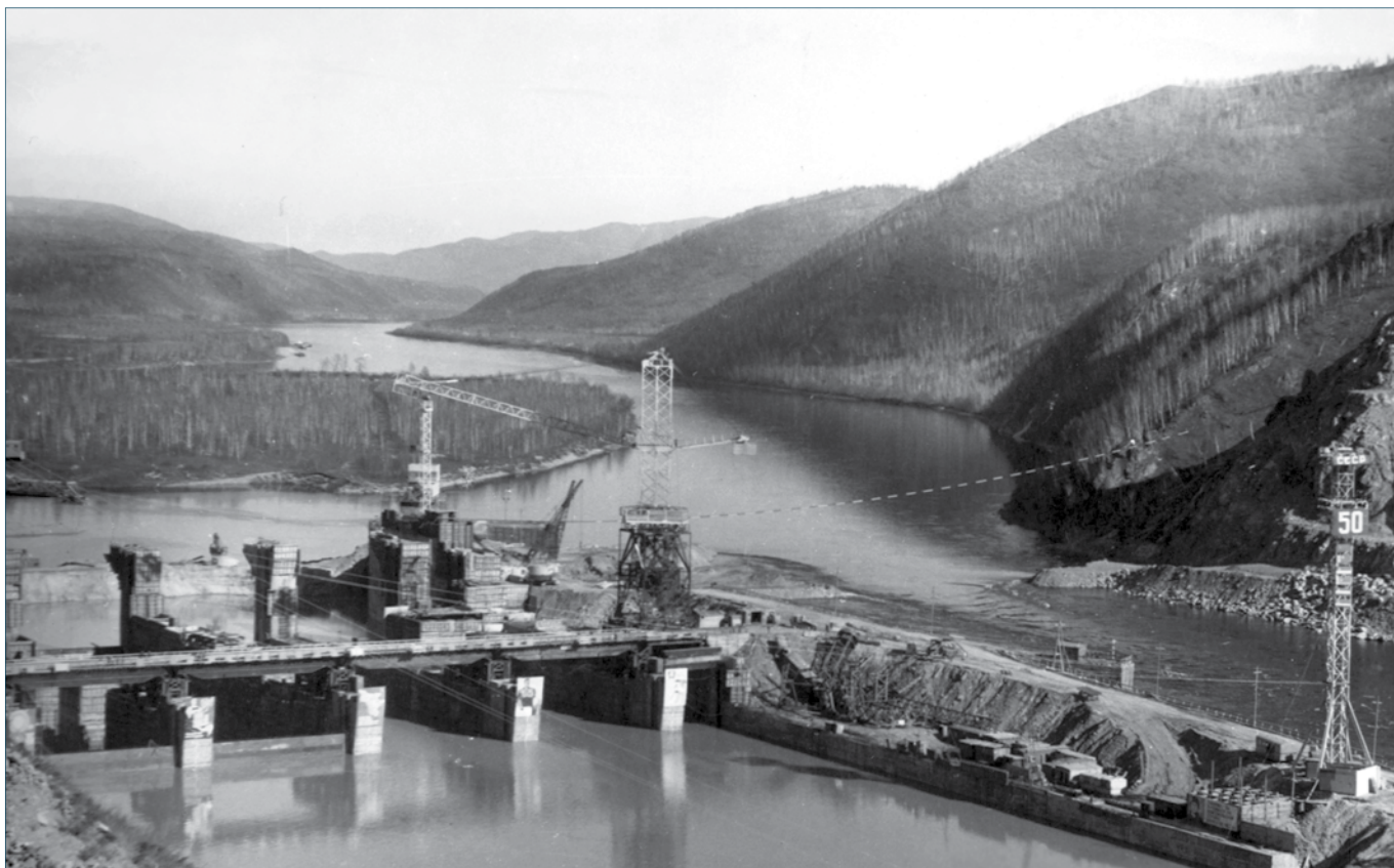
Рис. 5. Начало строительства водосбросной части плотины Зейской ГЭС. Фото П. Михалёва.
