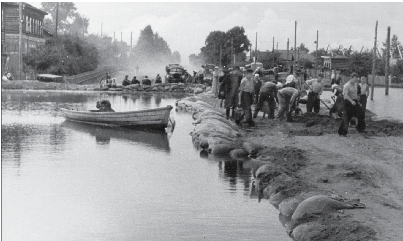
Рис. 3. Возведение дамбы на берегу р. Бурхановки. Благовещенск. 1958 г. Фото из фондов Госархива Амурской области.
