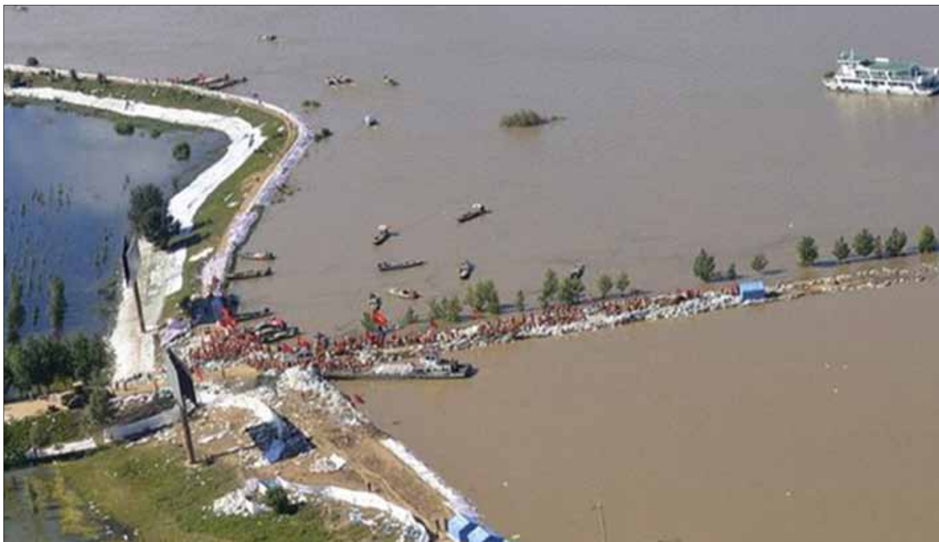
Рис. 3. Строительство защитной дамбы во время наводнения. Китай. Фото: неизвестный автор (Интернет).
