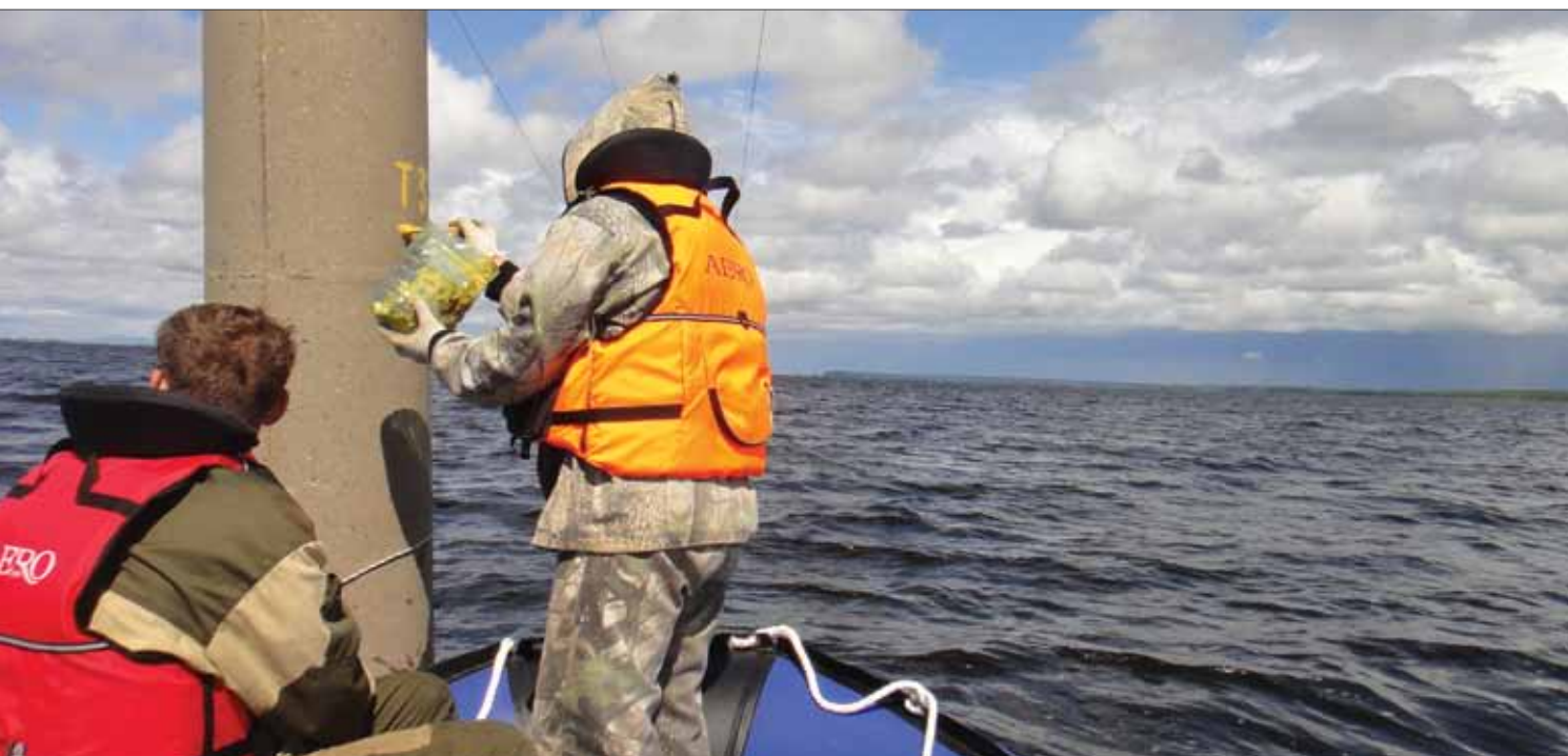
Рис. 2. Восстановление линии электропередачи ВЛ-35 «Дубки-Анастасьево» (Хабаровский край). Фото пресс-службы ОАО «ДРСК».
