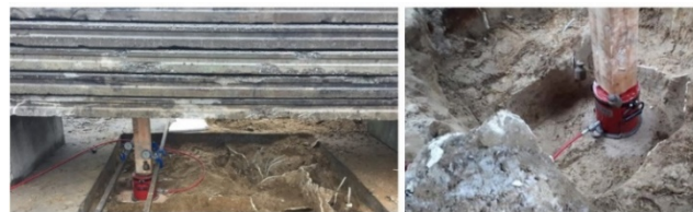
Рисунок 7 – Испытания грунтов штампом №3, 4 на инъектированном участке на глубине 0,4, 1,1 м соответственно
