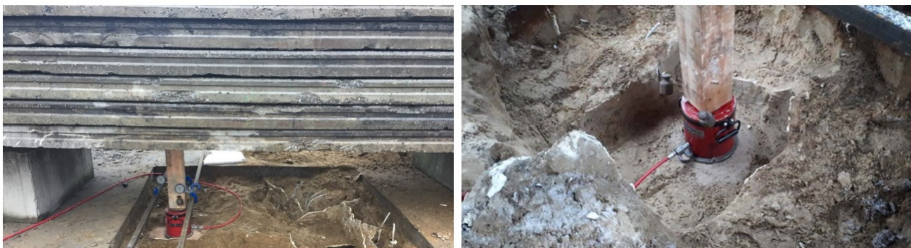
Рисунок 2.40 – Испытания грунтов штампом №3 и №4 на инъецированном участке на глубине 0,4 м и 1,1 м соответственно
