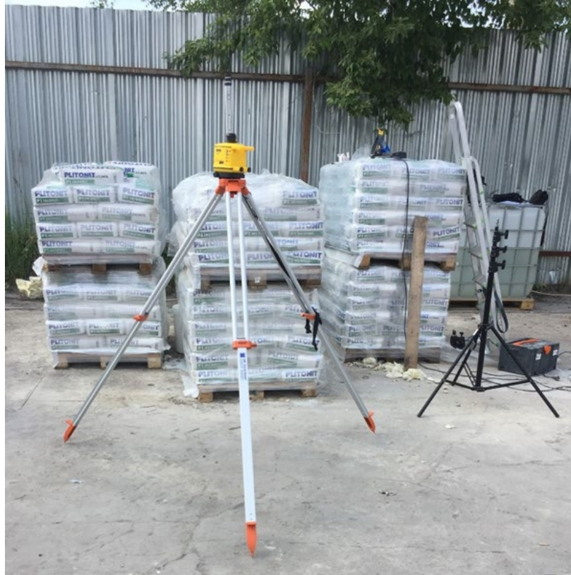
Рисунок 2.19 – Подготовка площадки к процессу инъектирования. Во время инъектирования используемая площадка была пригружена внешней статической нагрузкой (11 тонн, включая собственный вес бетонной плиты)
