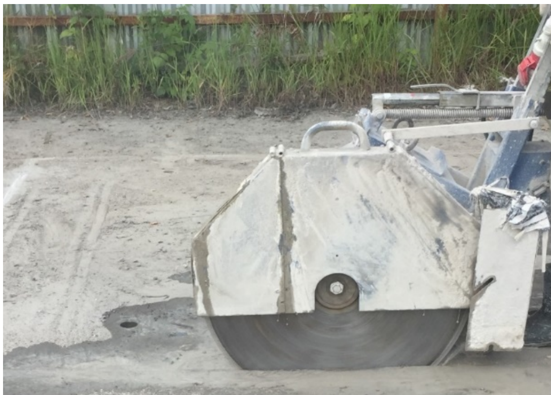
Рисунок 2.18 – Разрезание бетонной плиты на инъектируемом участке
