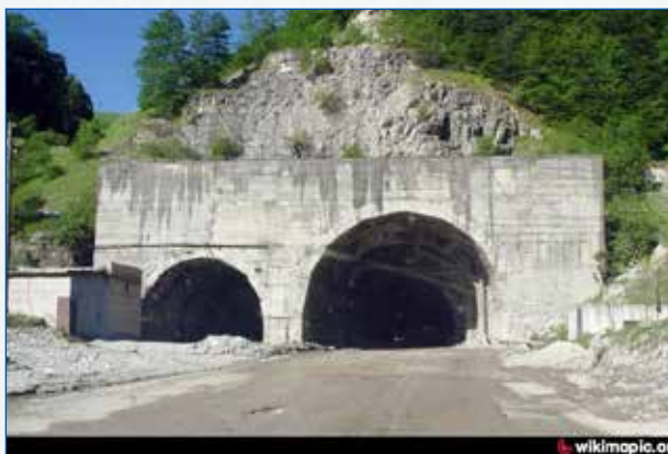
Гимринский автодорожный туннель
