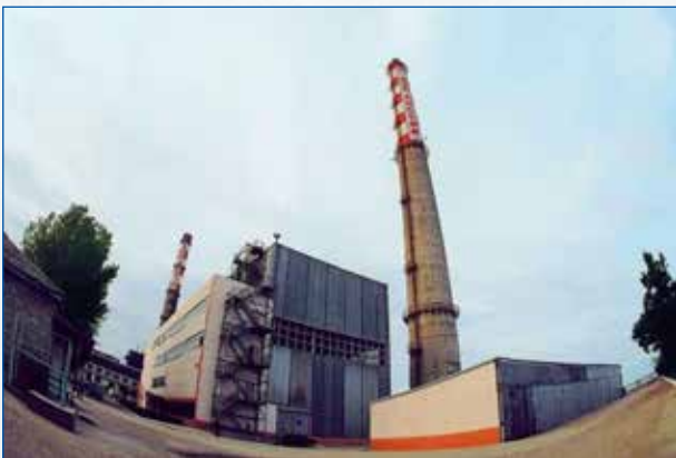
Махачкалинская ТЭЦ Makhachkalinskaya TPP
