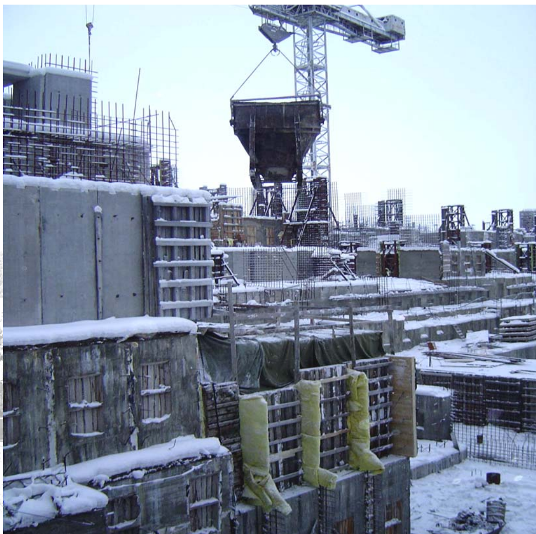
Станционная часть. Нижний бьеф. Бетонирование Блока С4
