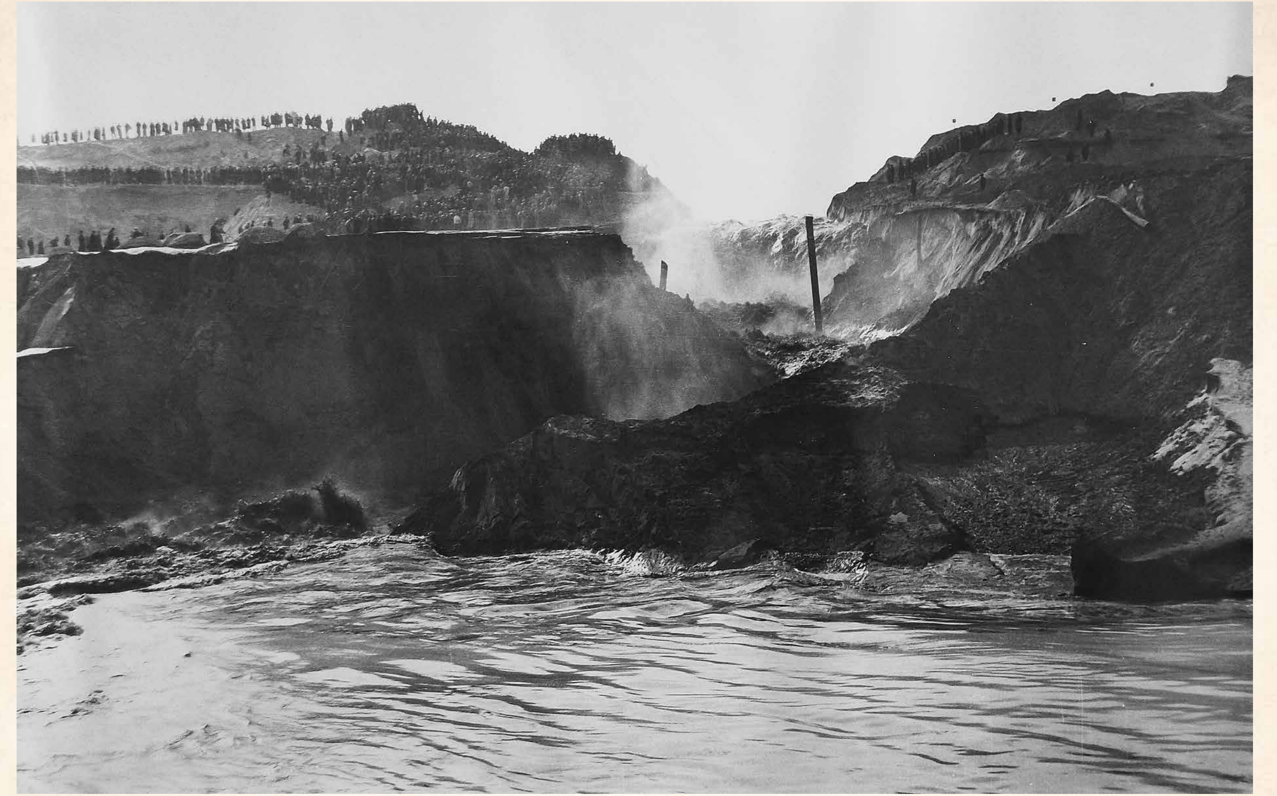
Начало затопления котлована через проран, образованный взрывом, в перемычке
