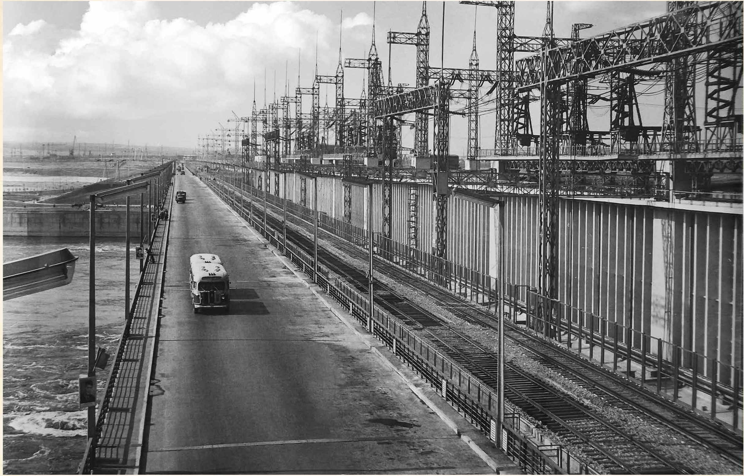
Железнодорожный и автодорожный переходы в пределах гидроэлектростанции
