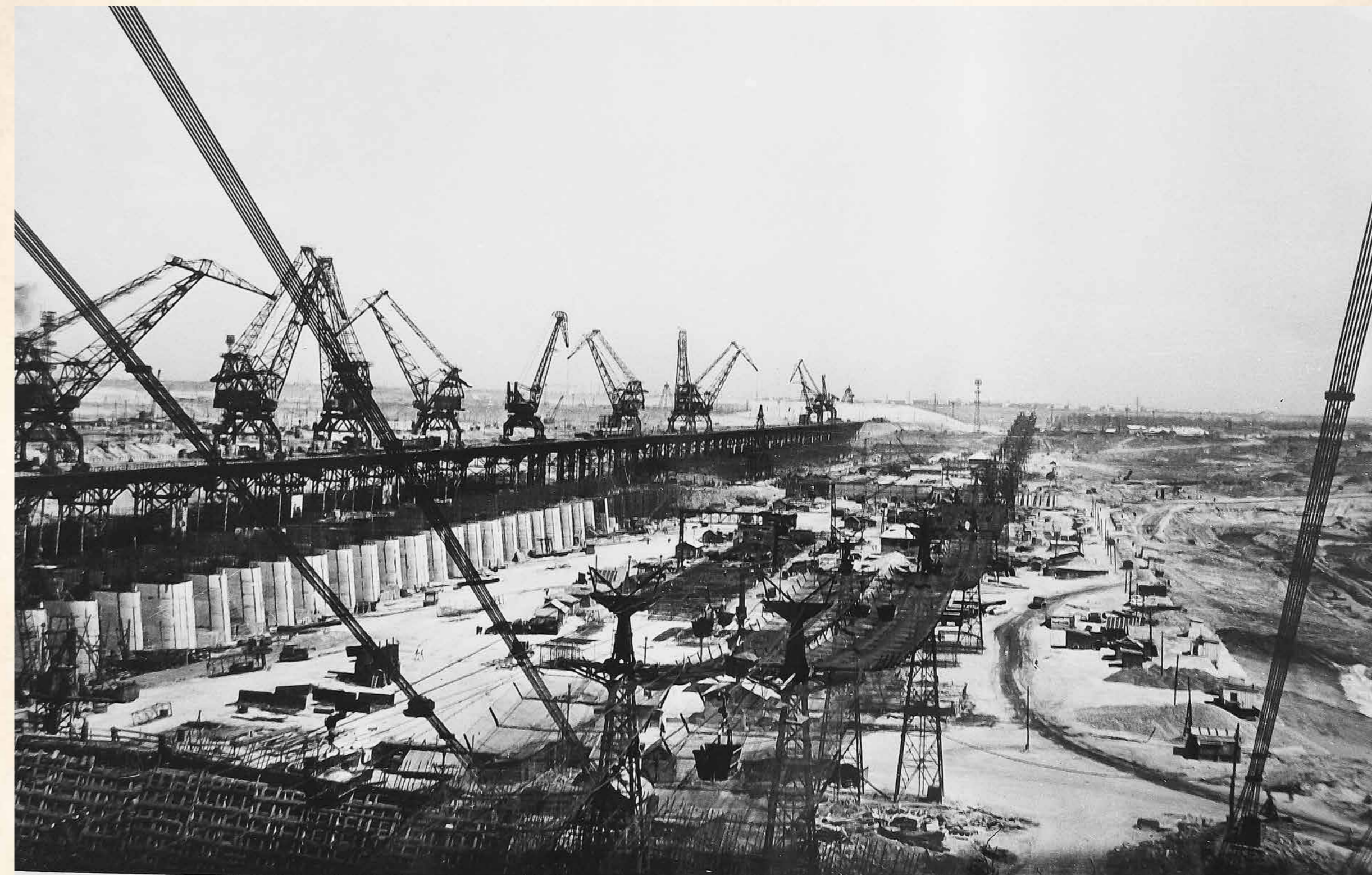
Вид с нижнего бьефа на гидроэлектростанцию перед затоплением
