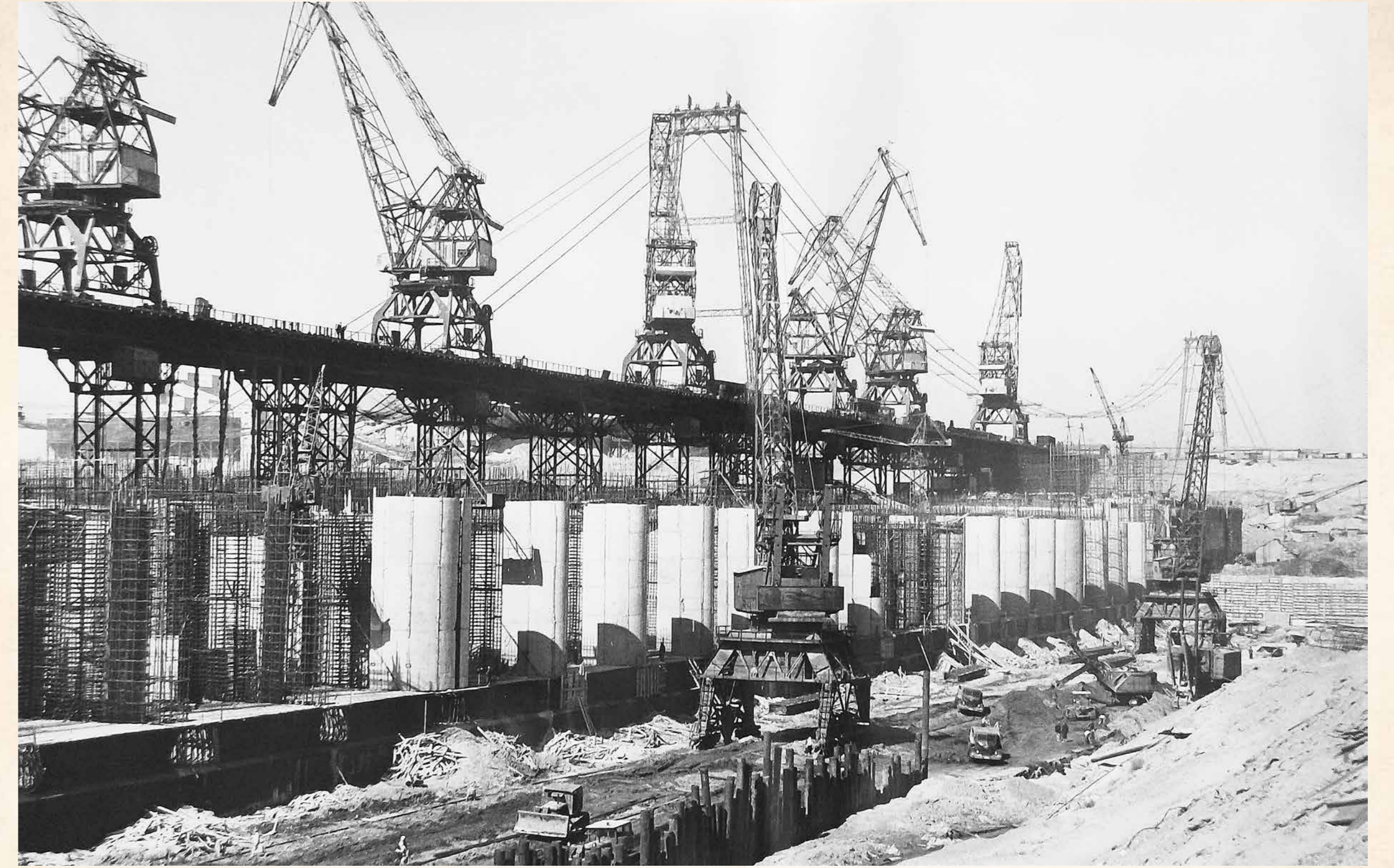
Вид с верхнего бьефа на строительство гидроэлектростанции в 1956 г.
