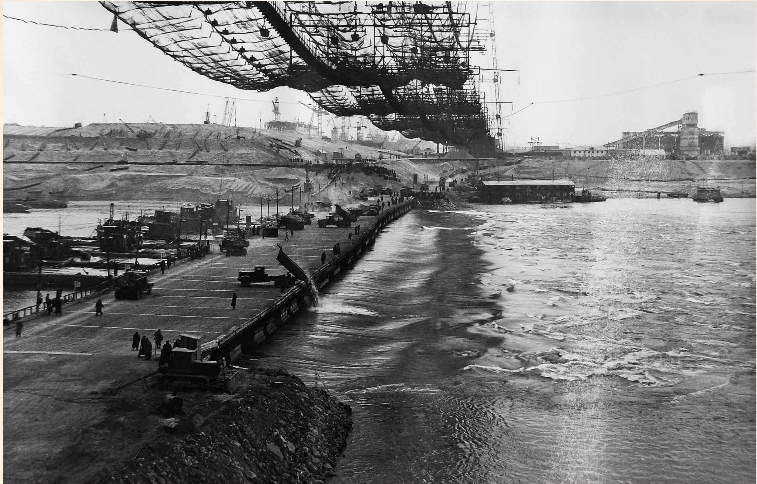
Перекрытие русла Волги с наплавного моста наброской камня 30 октября 1958 г.
