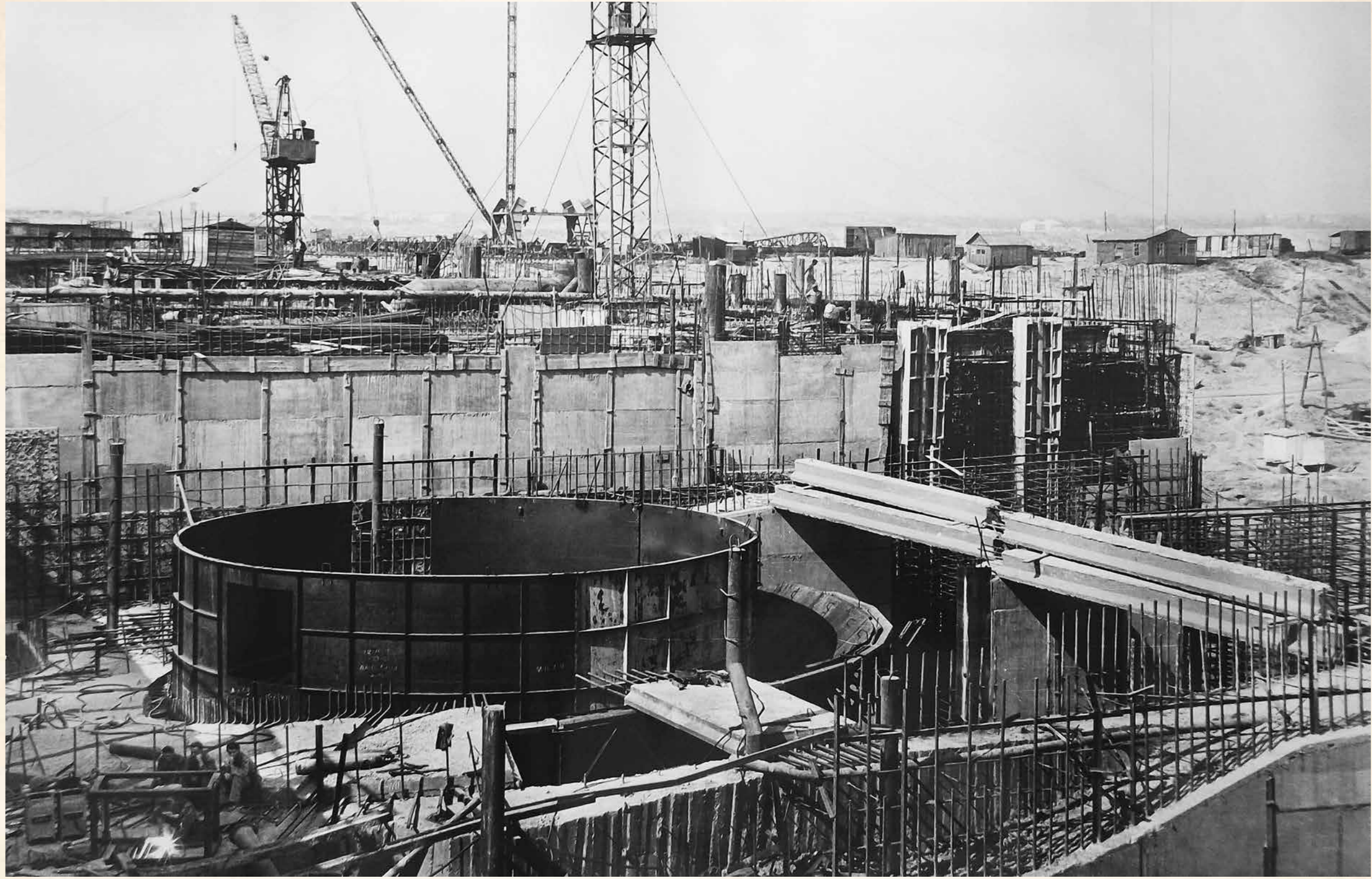
Облицовка шахты турбины
