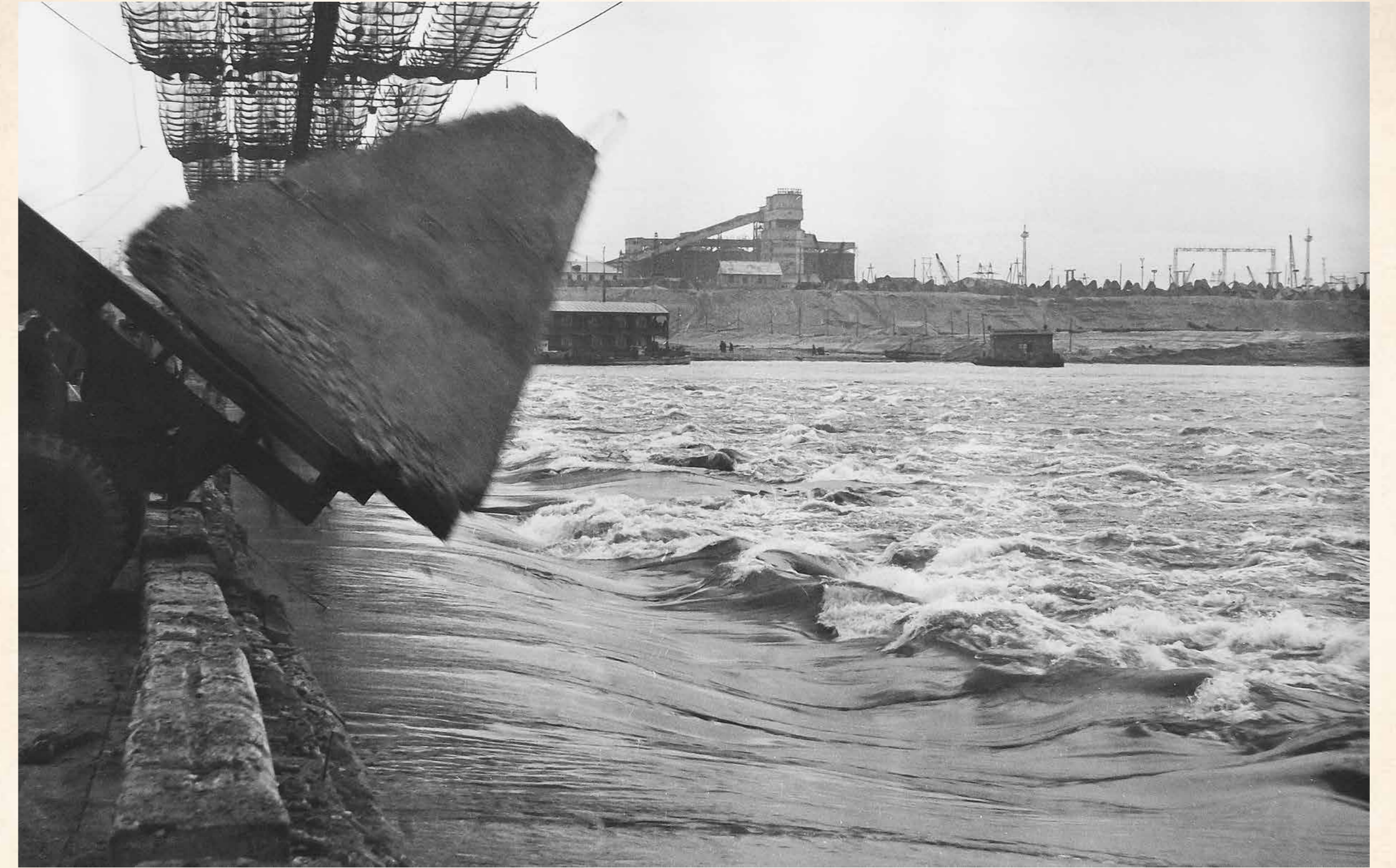
Перекрытие русла Волги с наплавного моста сбросом тетраэдров весом по 10 т каждый
