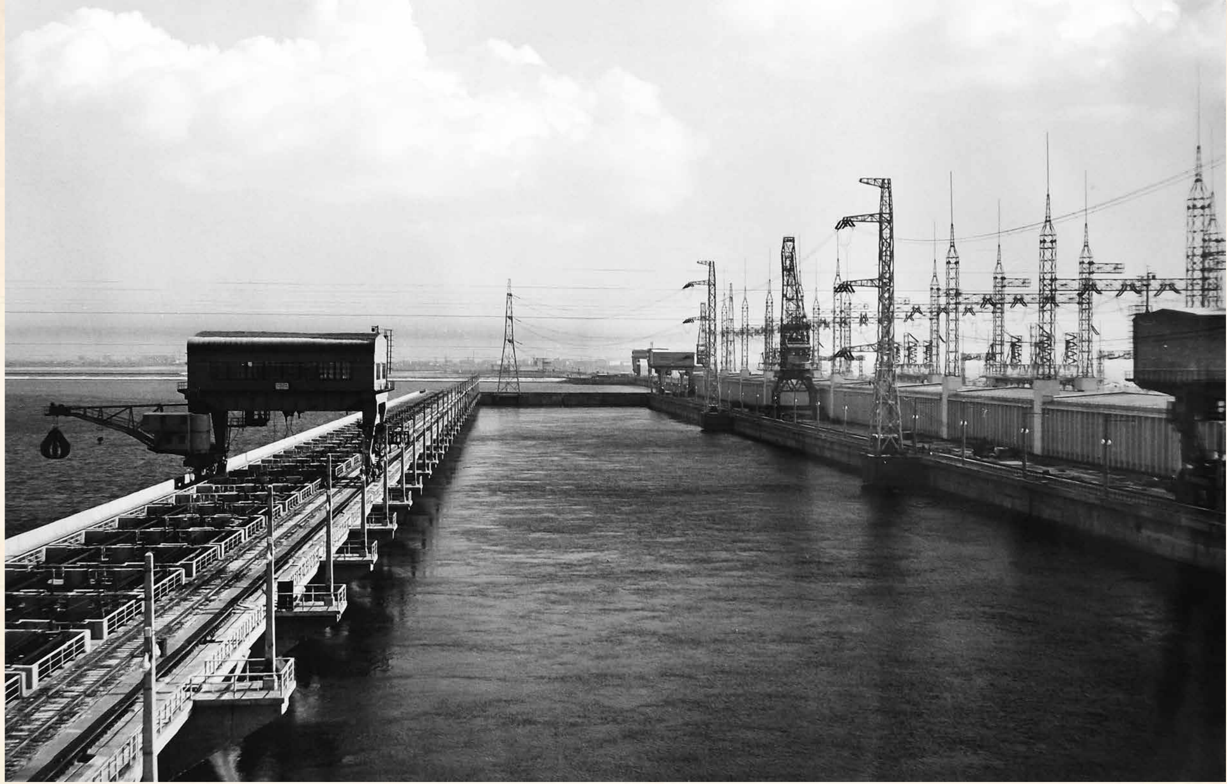
Вид с верхнего бьефа на сороудерживающее сооружение и гидроэлектростанцию
