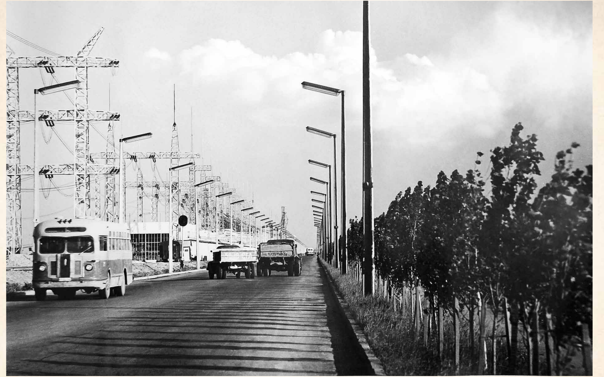
Автомобильный переход на русловой земляной плотине
