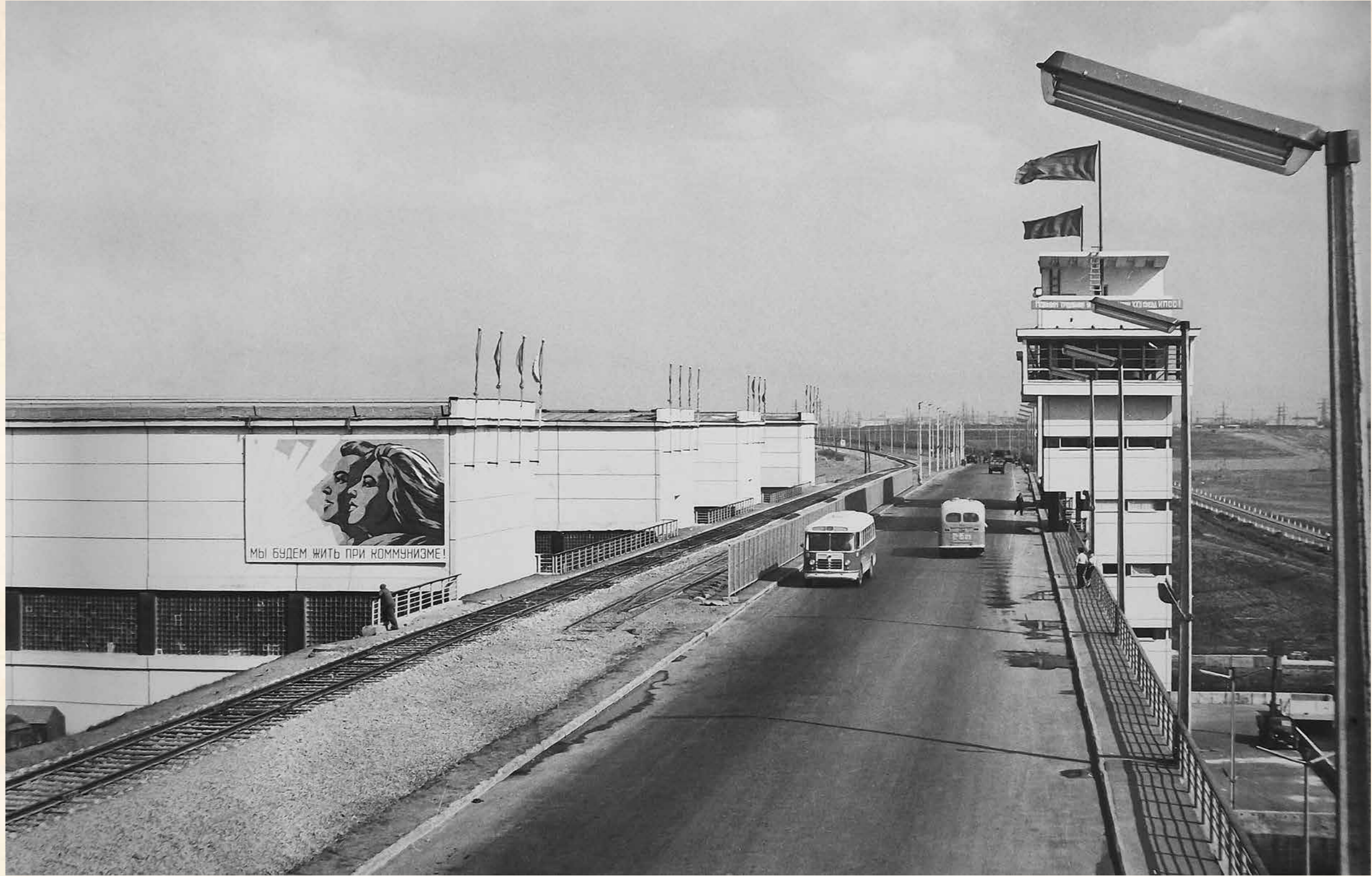
Железнодорожный и автодорожный переходы через шлюзы
