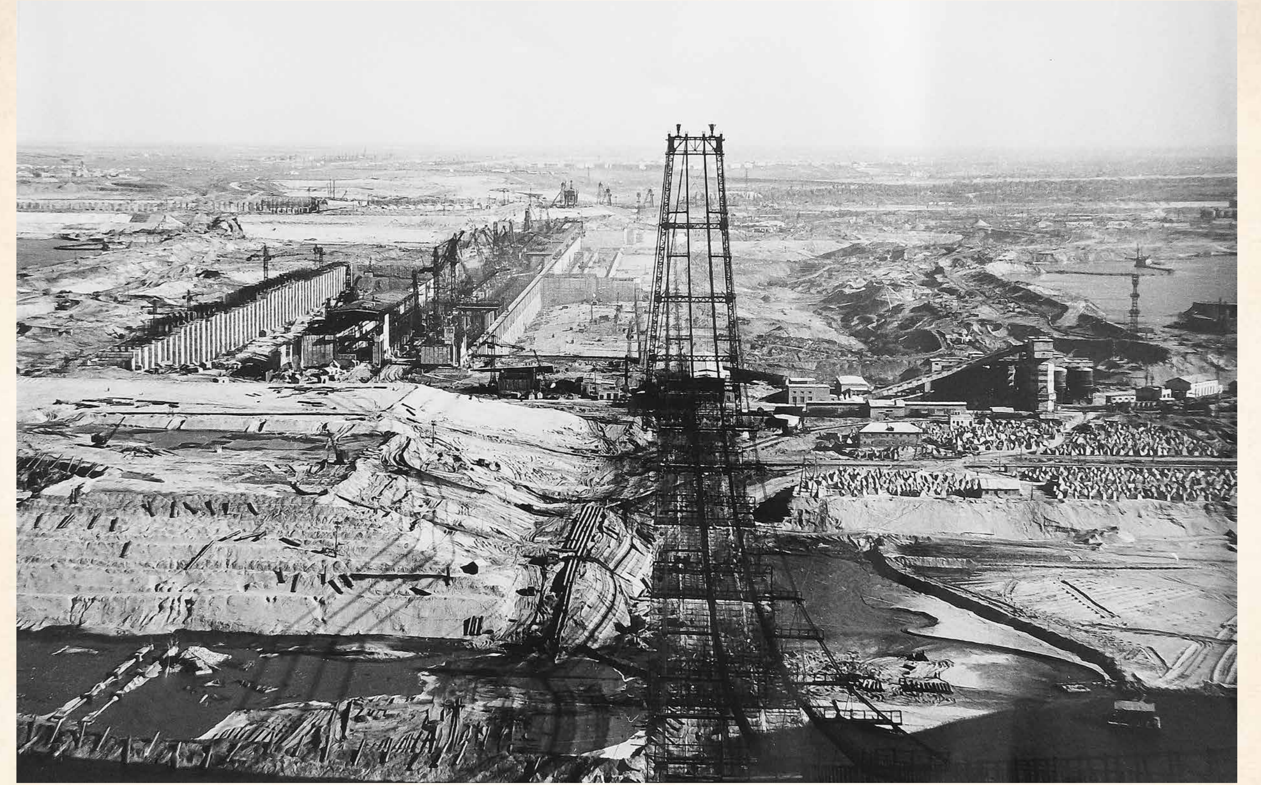
Общий вид строительства гидроузла до затопления котлована
