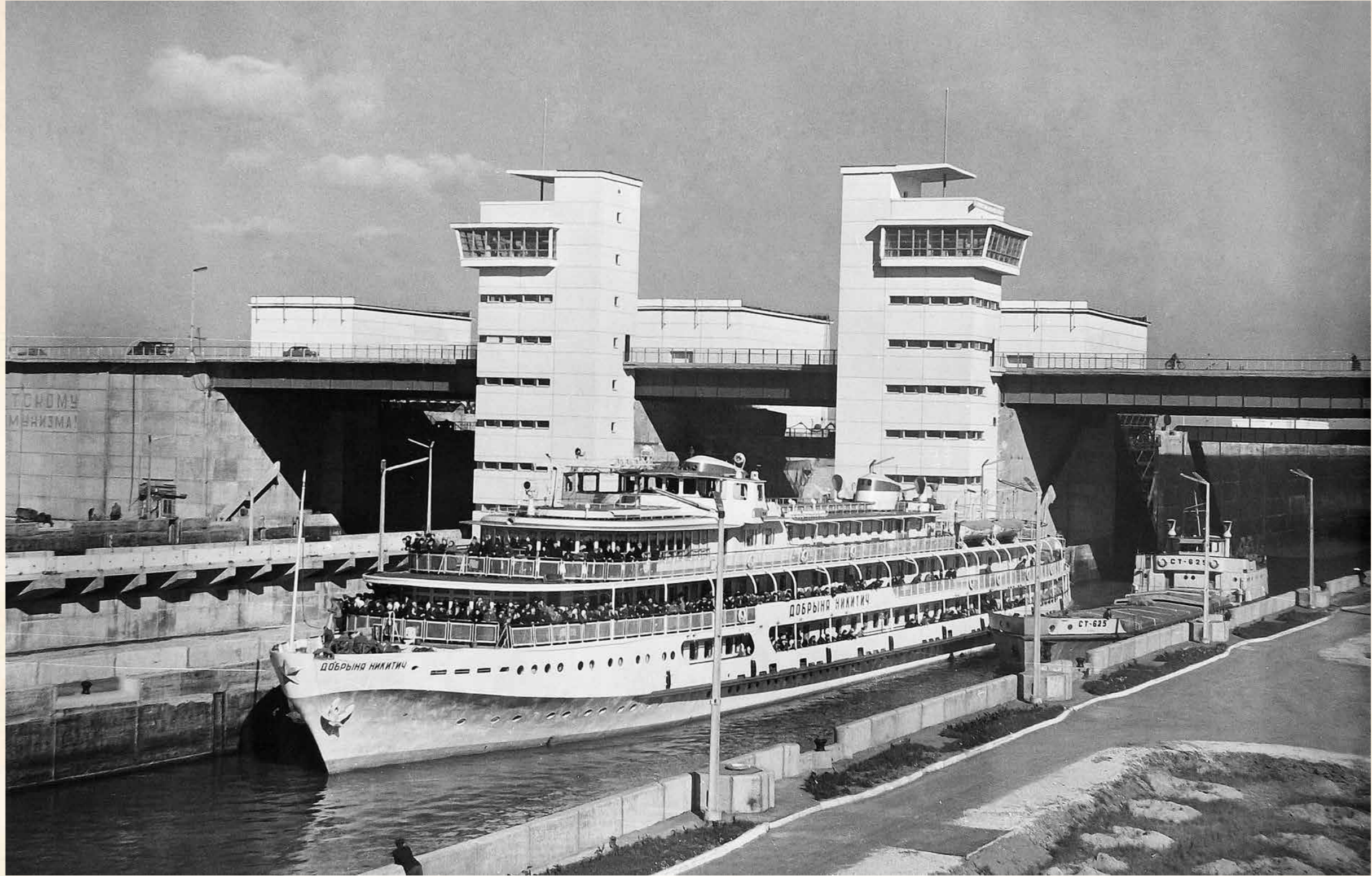
Шлюзование судов в нижней камере шлюза
