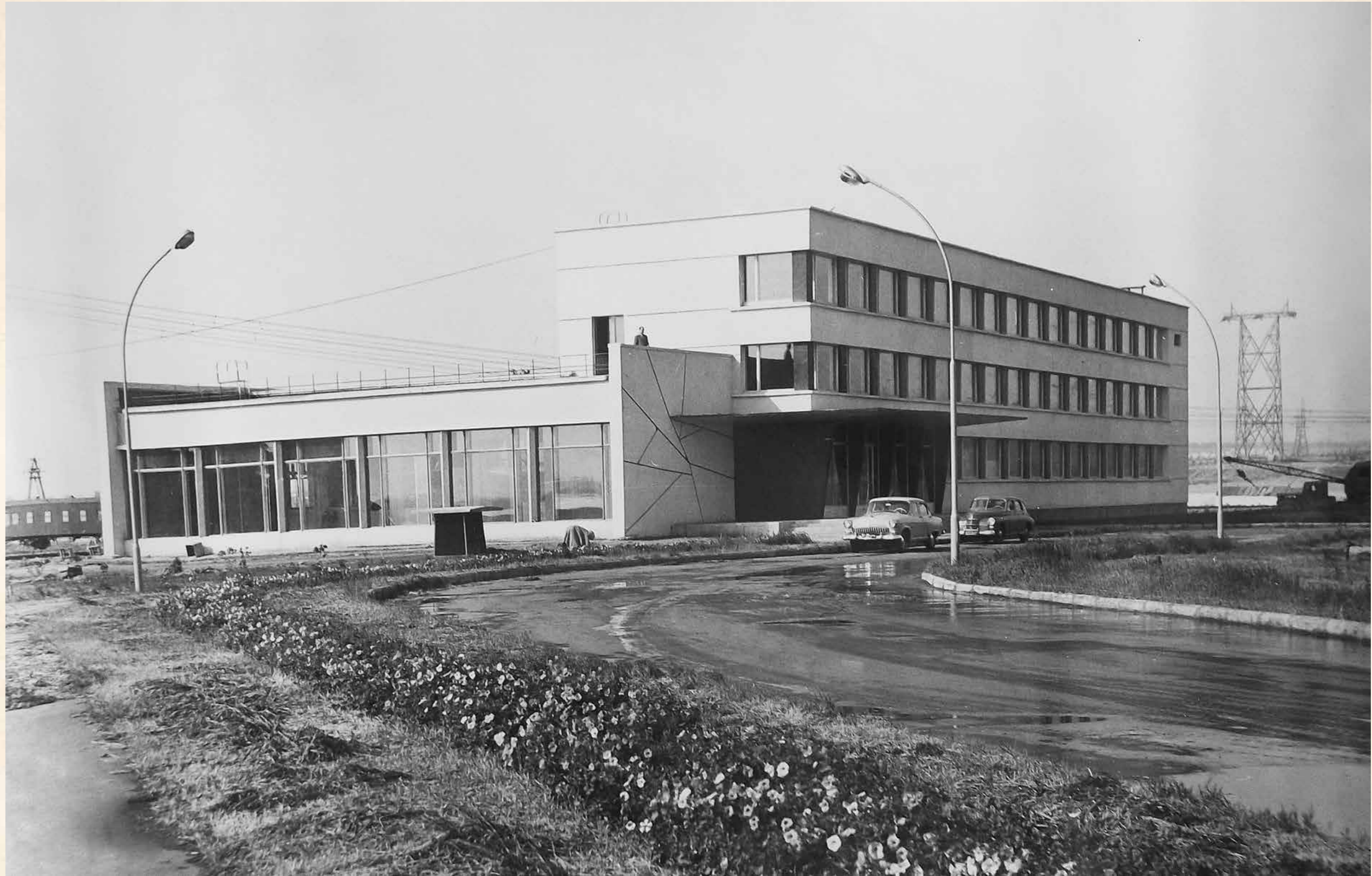
Службно-производственное здание ГЭС
