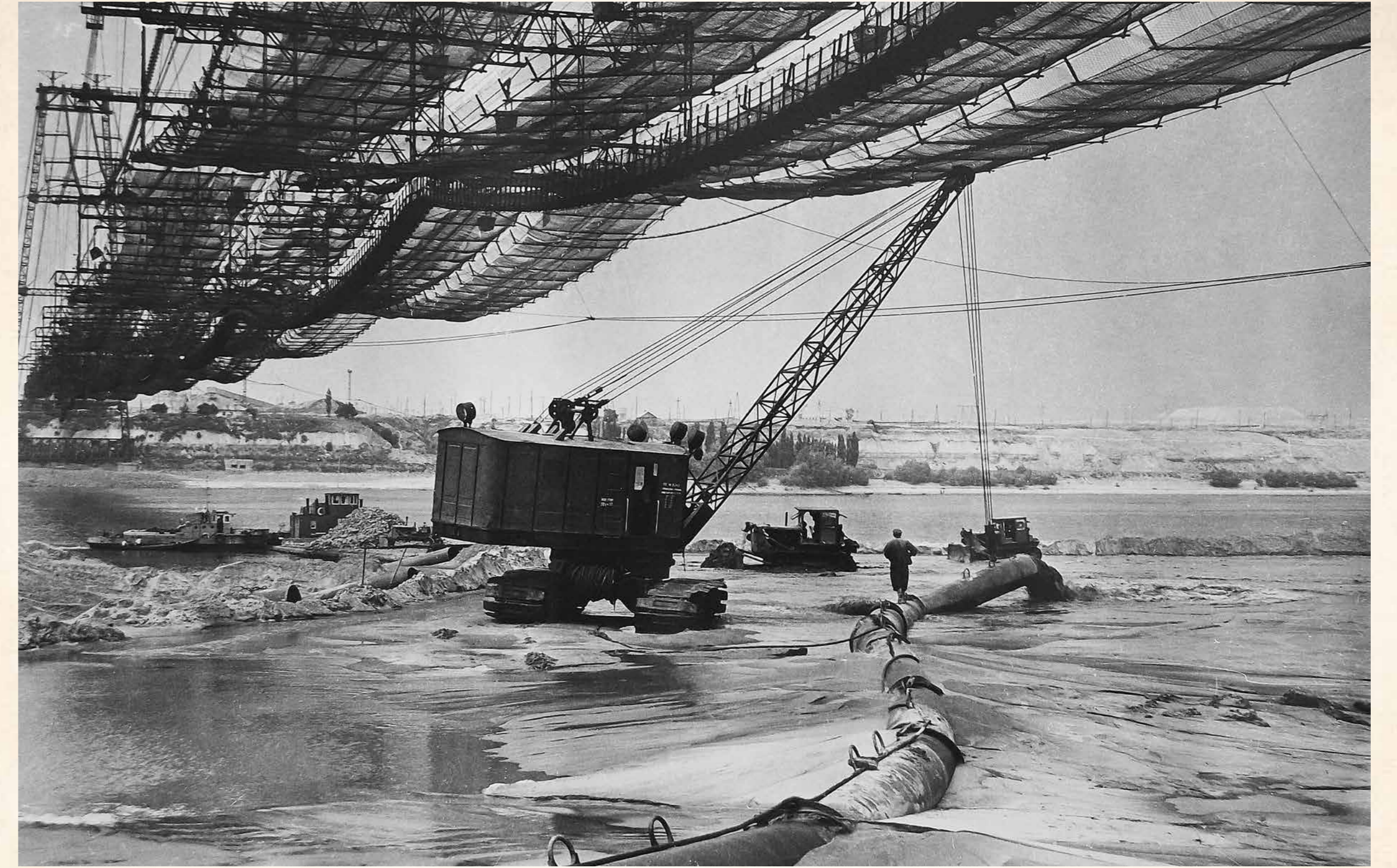
Намыв русловой плотины способом гидромеханизации перед перекрытием русла Волги
