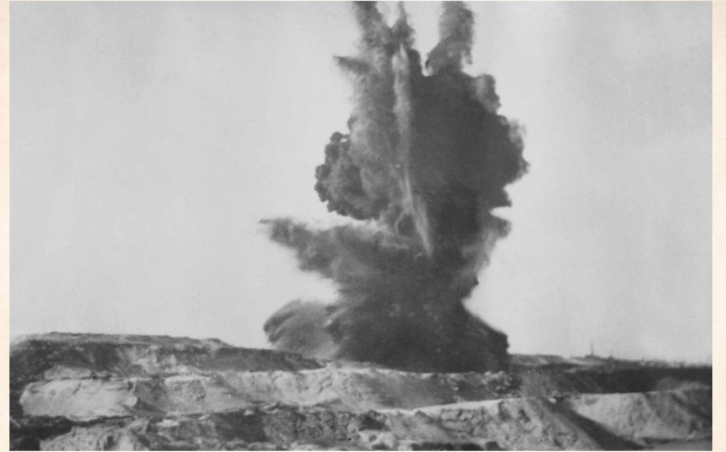
Взрыв низовой перемычки котлована 23 октября 1958 г.
