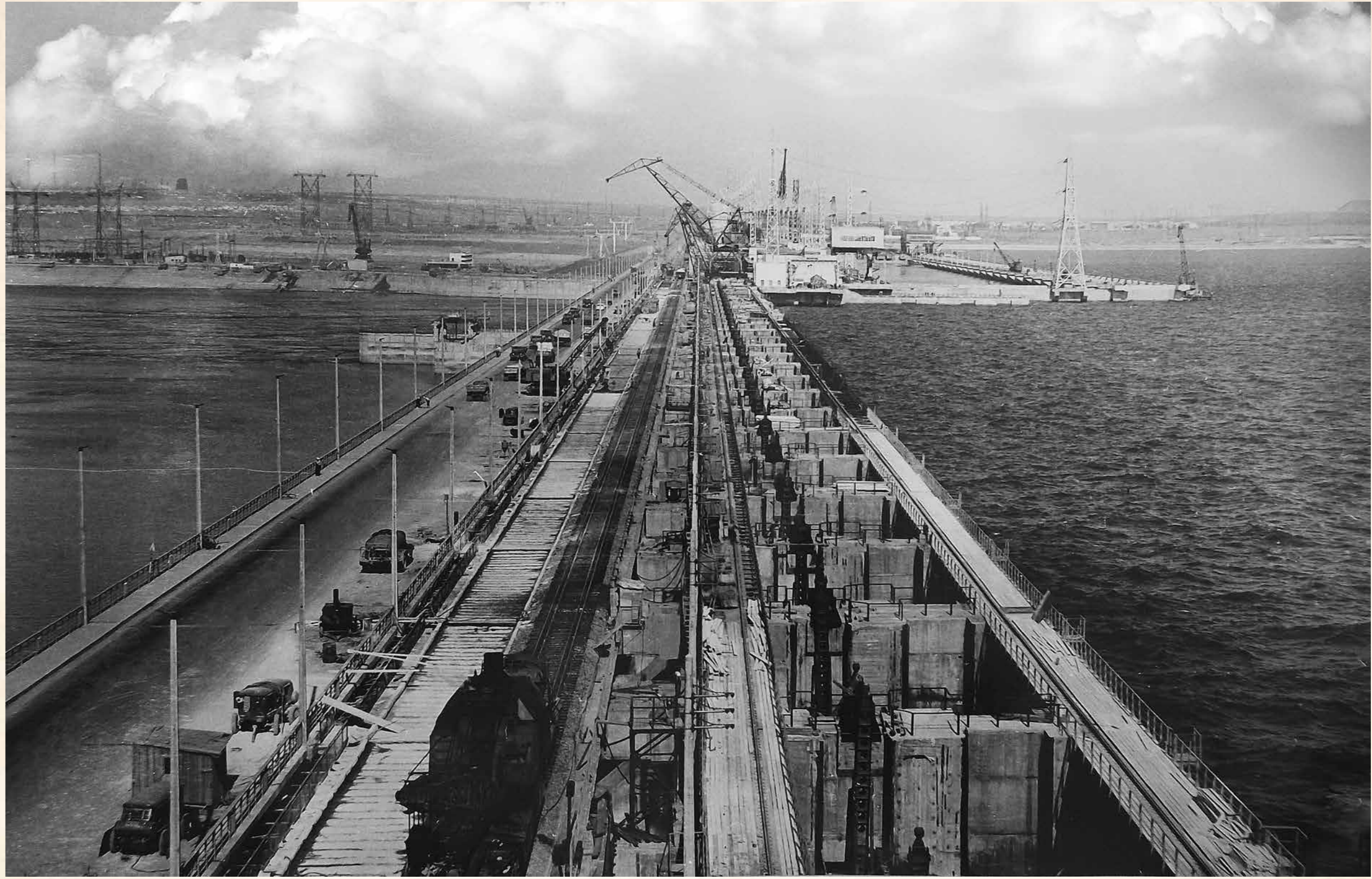
Железнодорожный и автодорожный переходы на водосливной плотине
