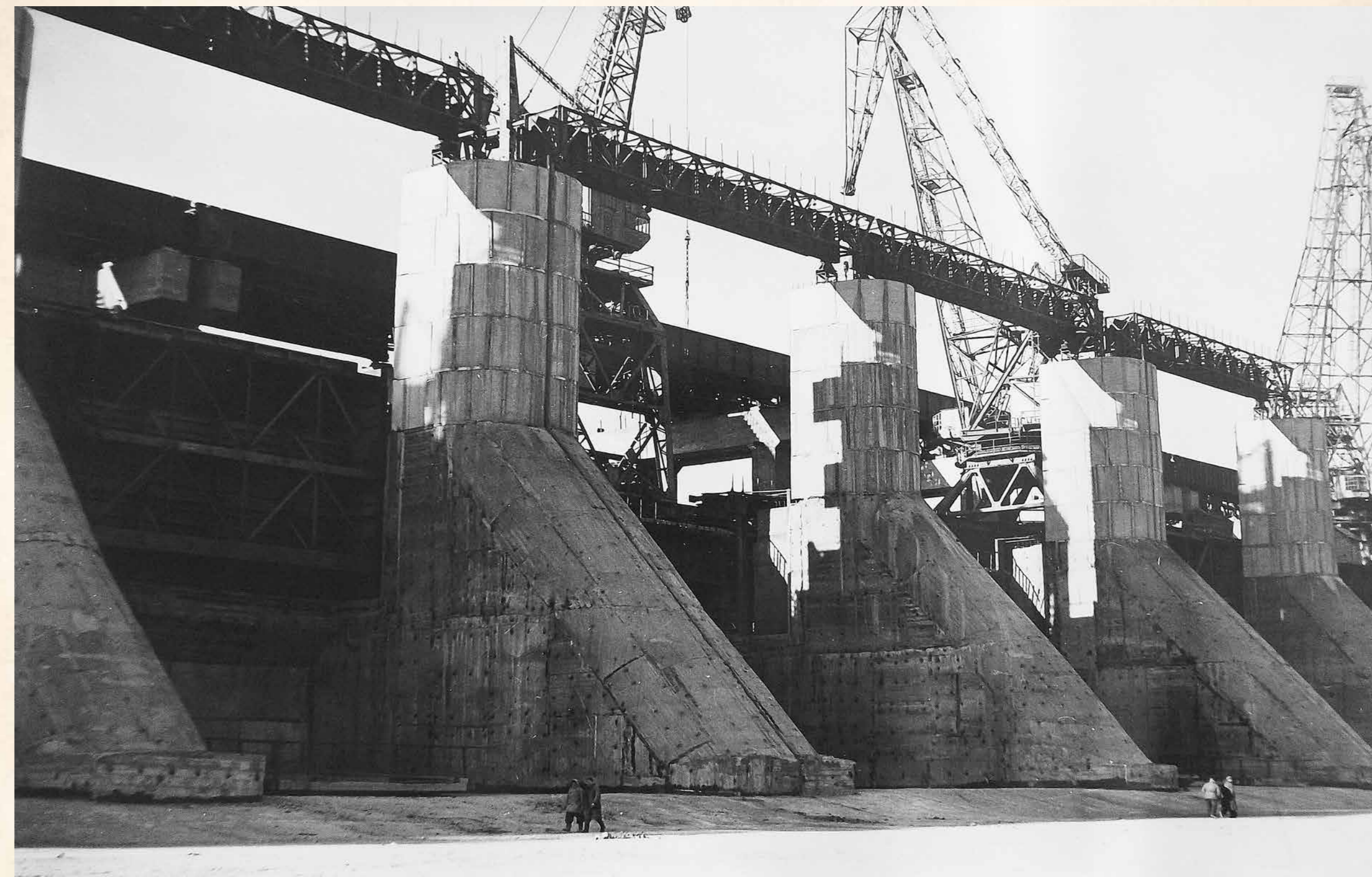
Вид с верхнего бьефа на водосливную плотину перед затоплением
