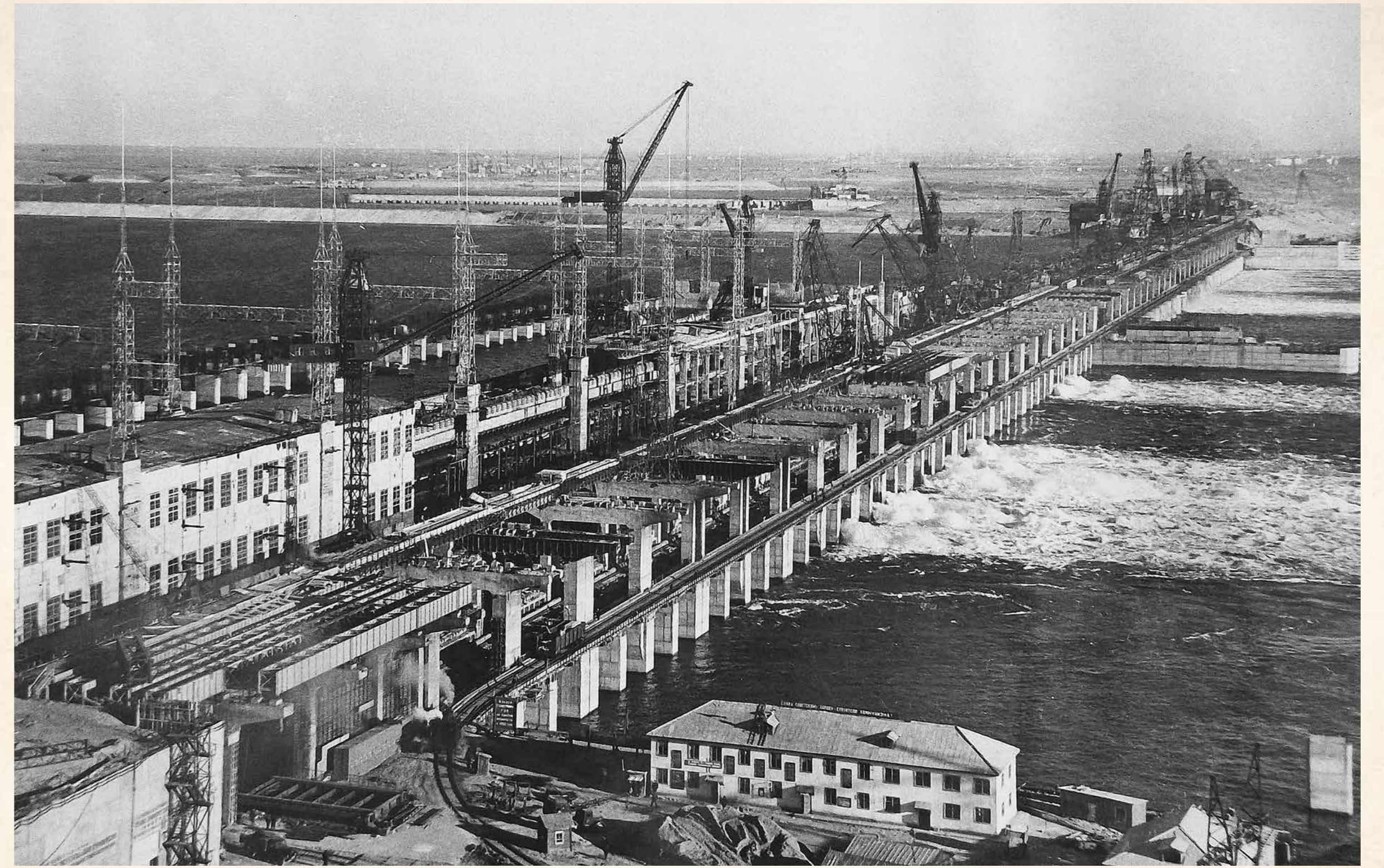
Вид с нижнего бьефа на гидроэлектростанцию после затопления в ноябре 1958 г.
