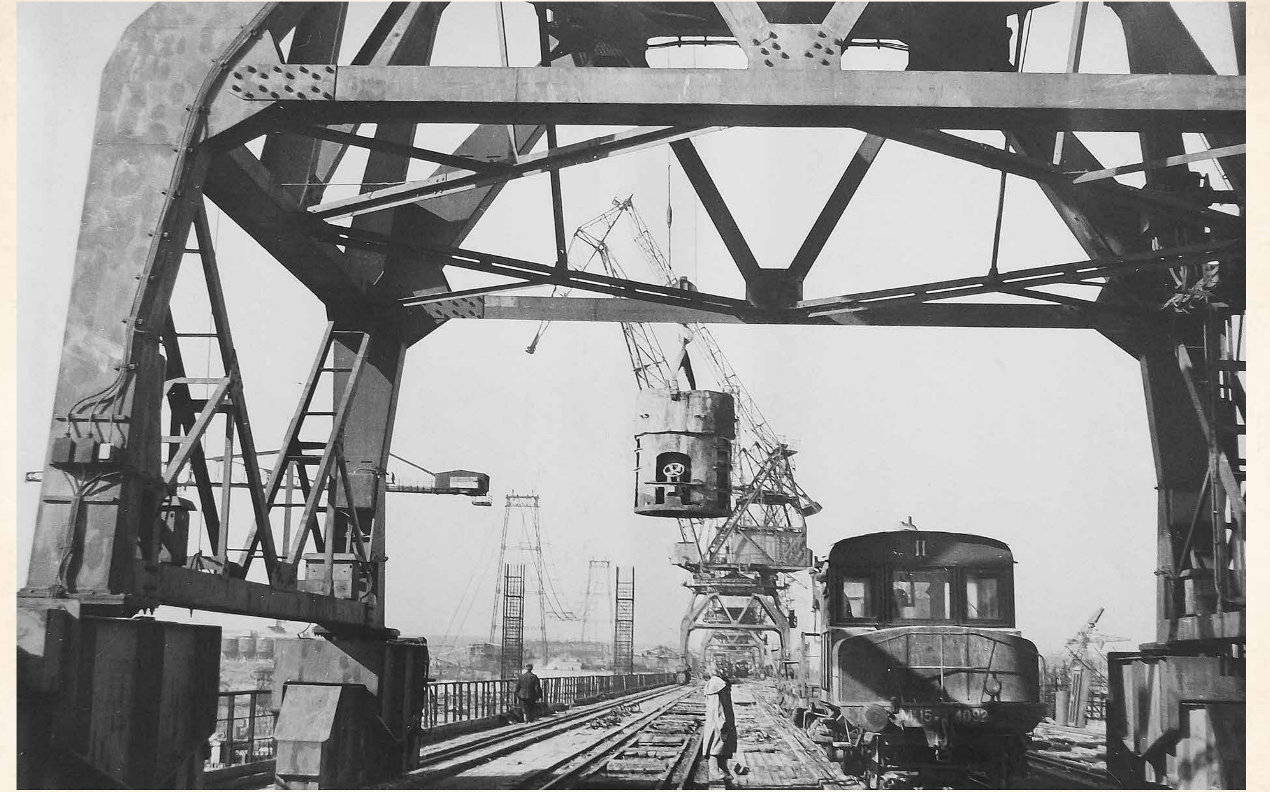
На бетоновозной эстакаде гидроэлектростанции и водосливной плотины
