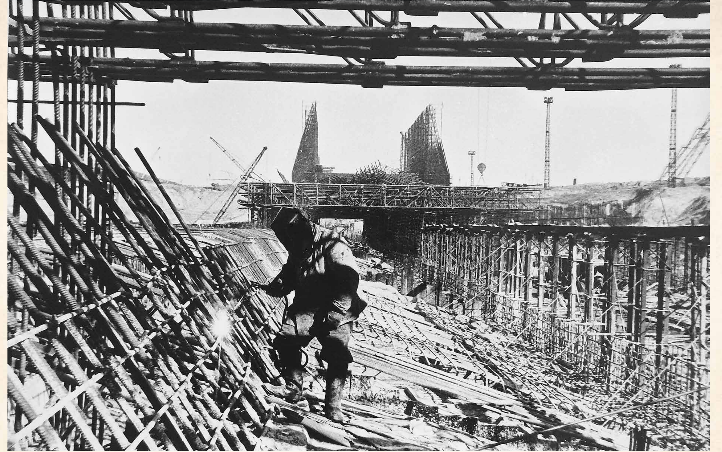
Сварка арматуры нижней камеры шлюза
