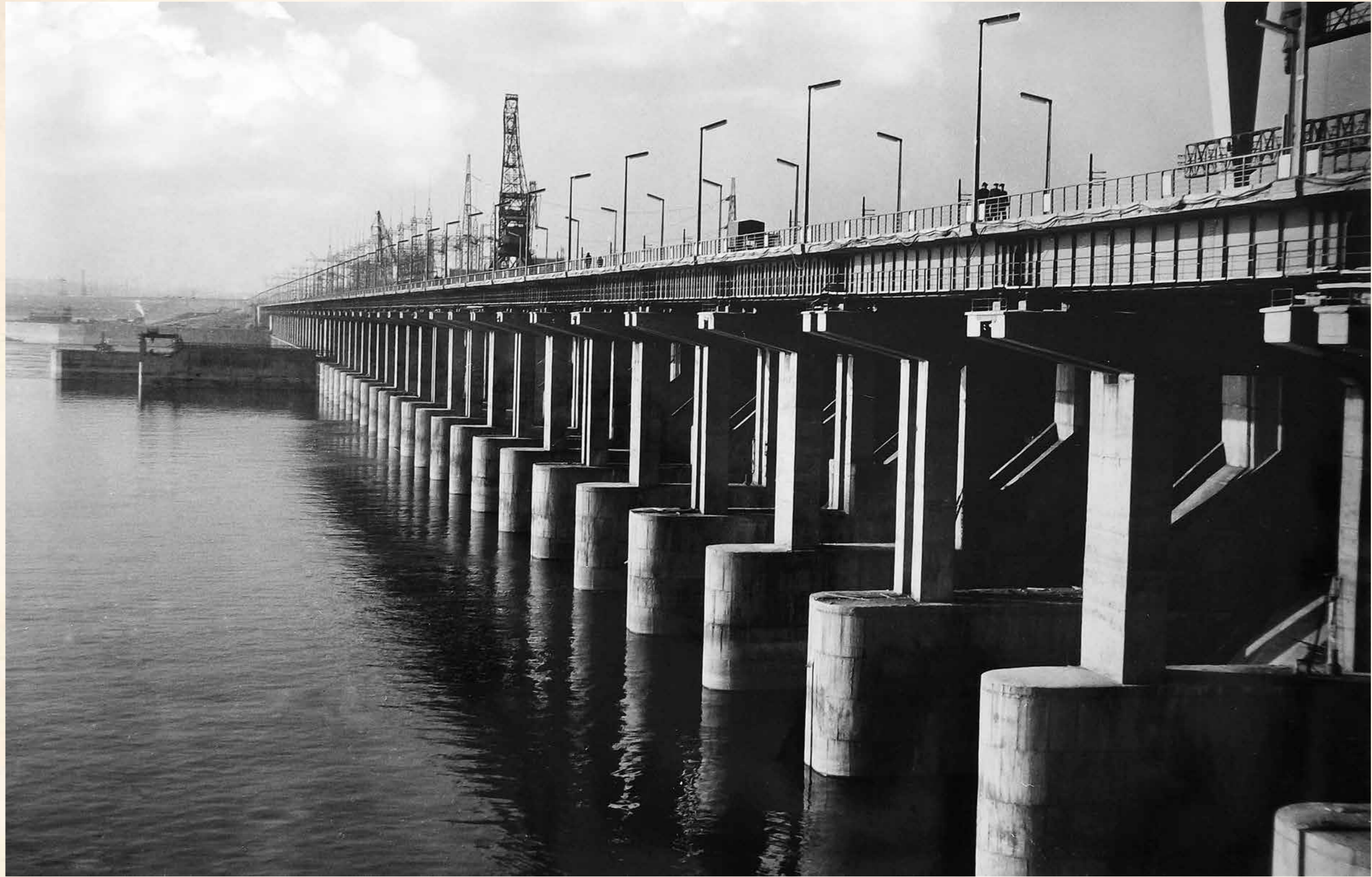
Водосливная плотина и низовой лоток рыбоподъемника
