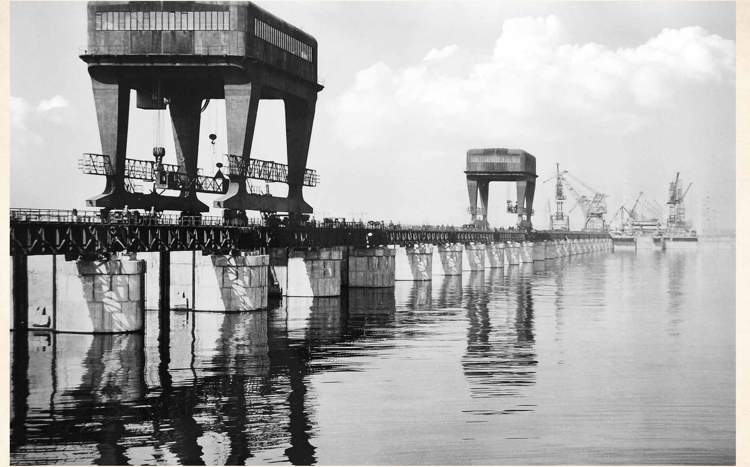
Вид с верхнего бьефа на водосливную плотину при наполненном водохранилище
