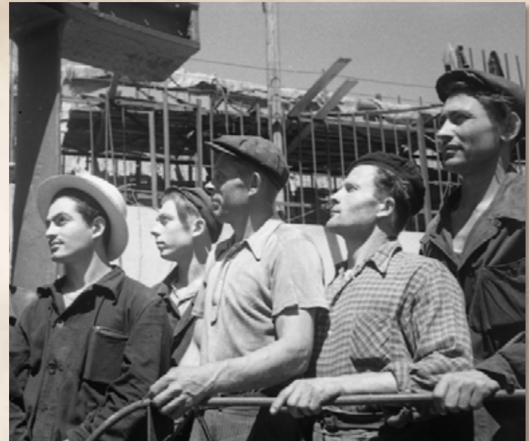
Бригада монтажников А. Тихашкова. 1958 год
