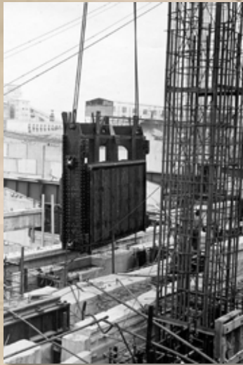
Монтаж закладных частей. Конец 1950-х годов
