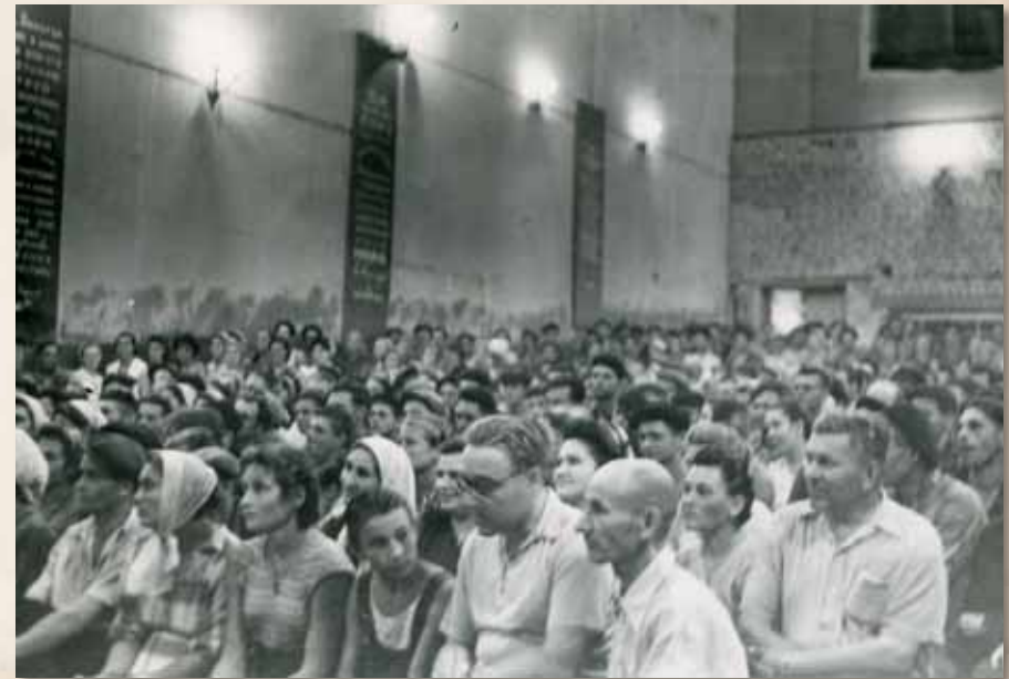
Клуб строителей, организованный в одном из отсеков турбины. 1958 год
