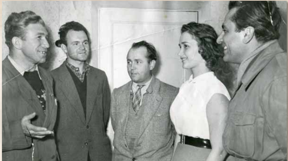
Выступление С. Я. Лемешева в котловане перед строителями Сталинградской ГЭС. 25 июня 1958 года
