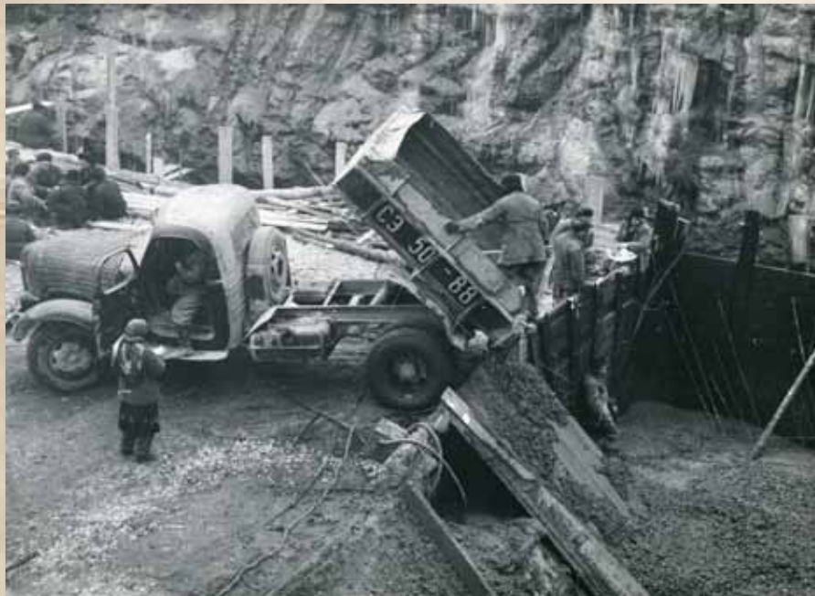
Подача бетона с кузова самосвала
