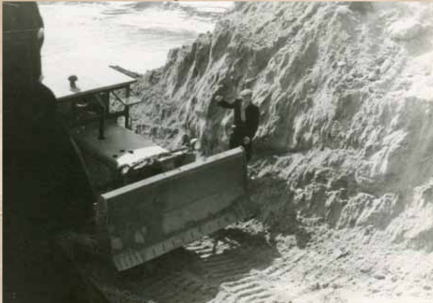
Разрезание перемычки нижнего подходного канала бульдозером. 10 апреля 1959 года
