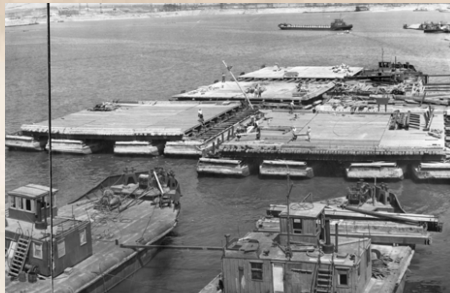
Наведение наплавного моста
