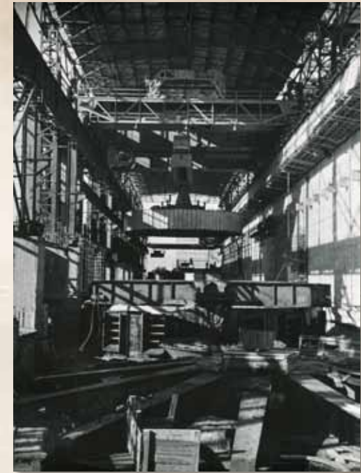
Перенос ротора генератора. 1958 год
