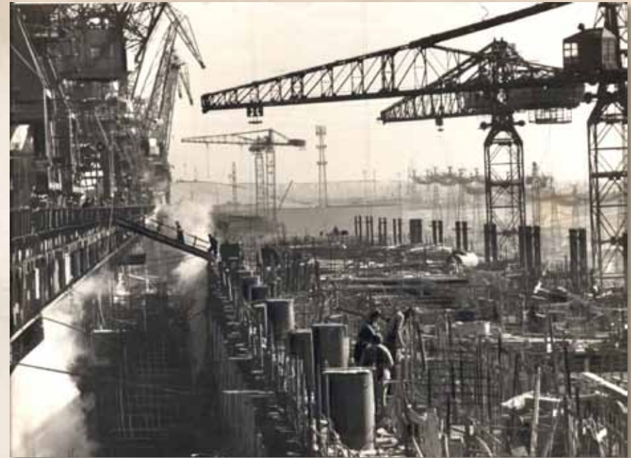
Монтажные работы на строительстве Сталинградской ГЭС. 1957 год
