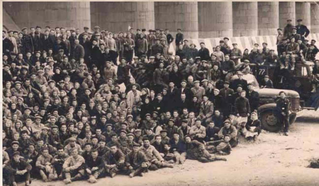
Коллектив строителей плотины в котловане Сталинградской ГЭС перед затоплением. Октябрь 1958 года
