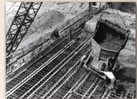
Специальный ковш для подачи бетона краном
