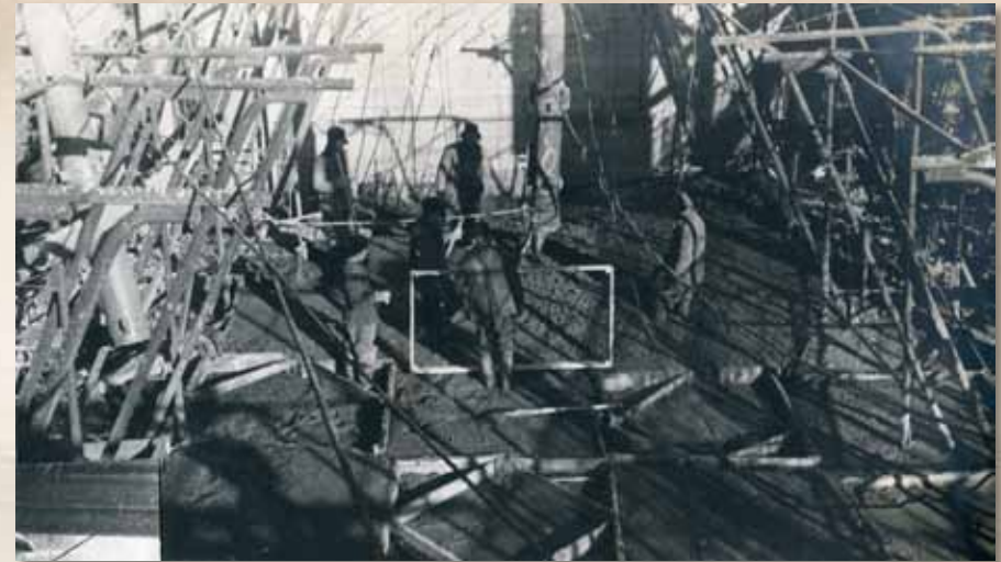
Укладка бетона с помощью виброхоботов. Декабрь 1955 года
