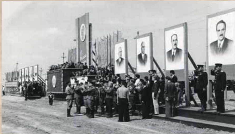
На митинге по поводу укладки первого бетона в фундамент Сталинградской ГЭС играет духовой оркестр. 5 сентября 1954 года
