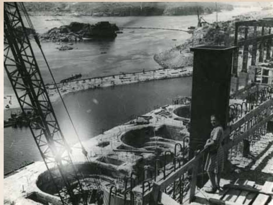
Вид на кратеры турбин с бетоновозной эстакады
