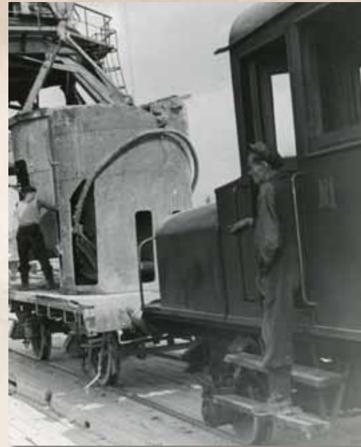
Транспортирование бетонной смеси в бабдях мотовозами. 1957 год
