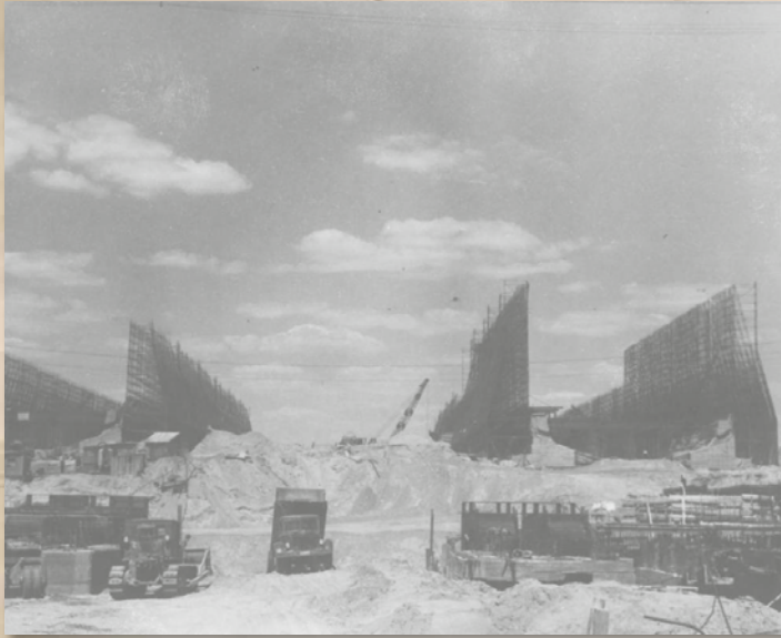
Армирование верхних камер шлюзов. 1956 год
