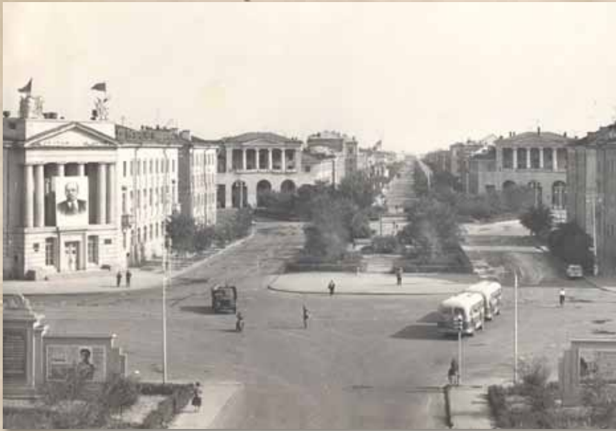
Въезд в г. Волжский. Город накануне торжественного пуска ГЭС. 1961 г.
