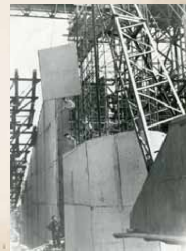
Установка плит-оболочек. 1956 год
