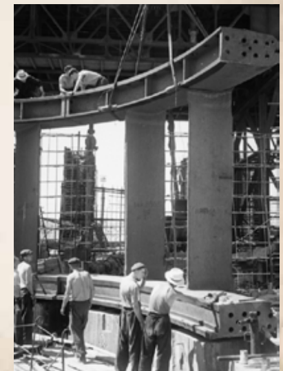
Установка в кратер агрегата деталей статора гидротурбины бригадой А. Тихашкова. 1957 год
