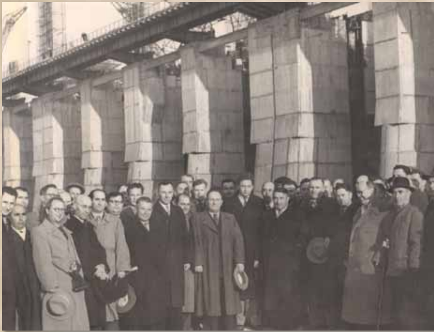
Приемочная комиссия, руководители строительства в котловане Сталинградской ГЭС. Октябрь 1958 года
