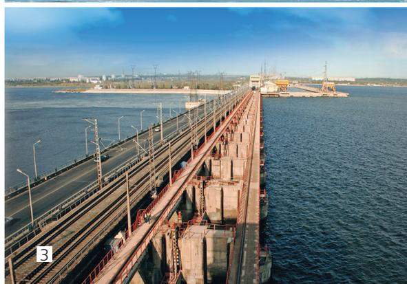
водосброс, по которому при опорожнении камер шлюзов сбрасывается вода в Ахтубу, и межшлюзовая гидроэлектростанция, оборудованная двумя гидроагрегатами мощностью по 11 МВт. Эта гидроэлектростанция использует падение воды, пропускаемой из верхнего бьефа в нижний подходной канал, для привлечения к шлюзам рыбы.
