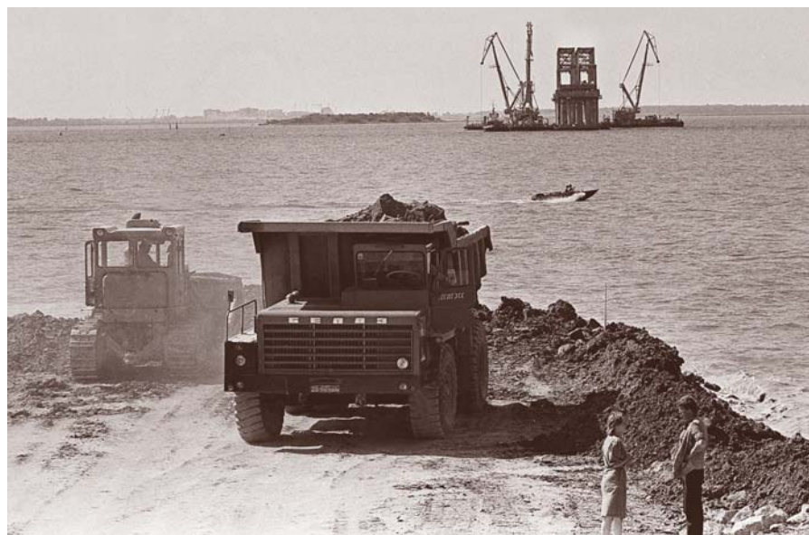
Строительство КЗС Ленинграда от наводнений
