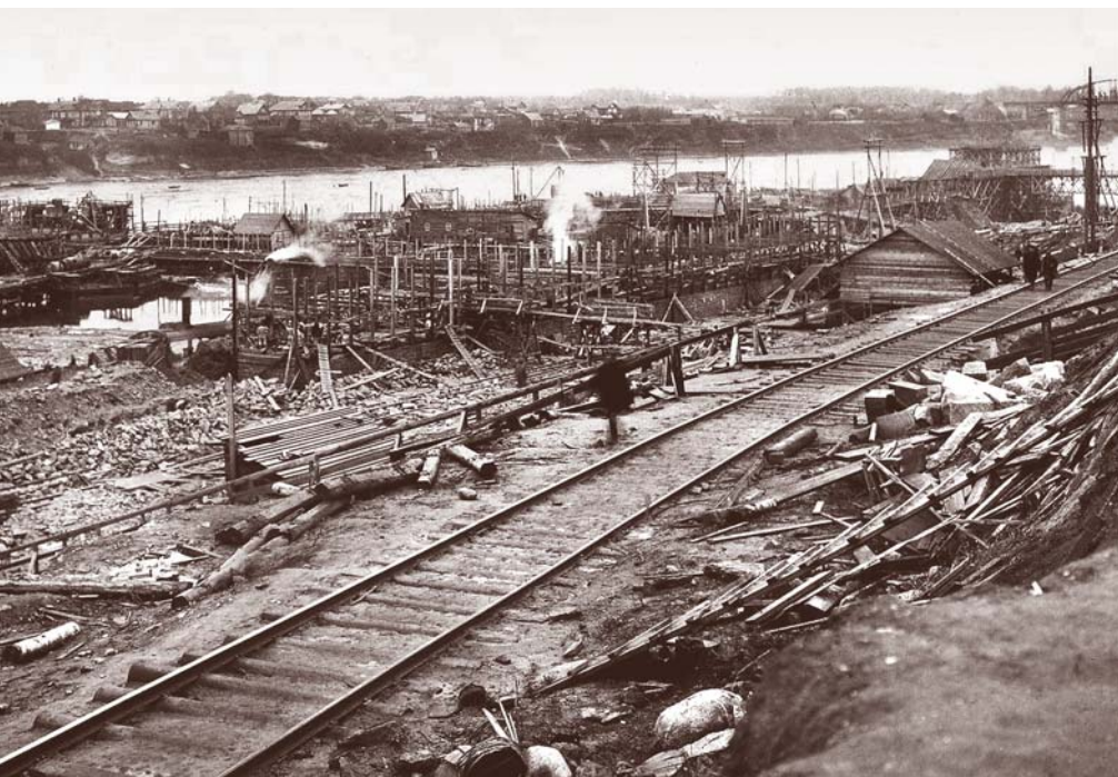
На строительстве Волховской ГЭС, 1923 год
