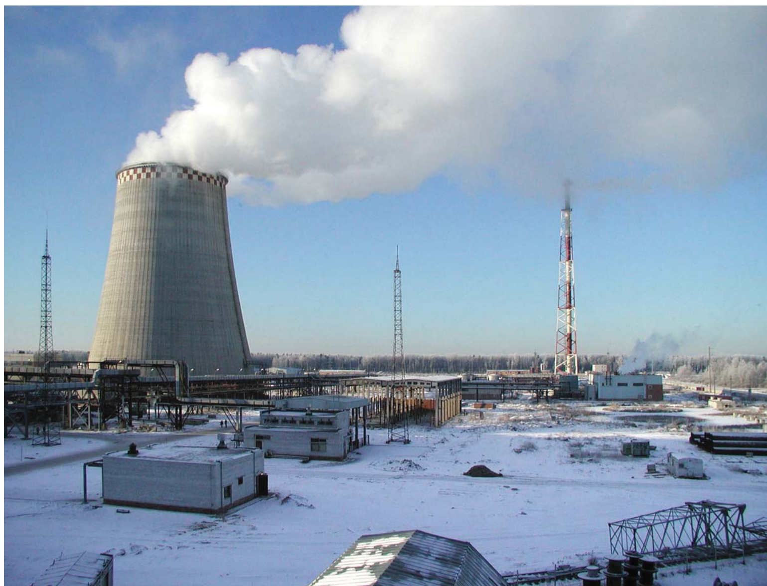
Южная ТЭЦ в Санкт-Петербурге
