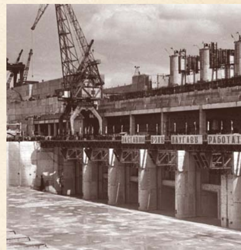
Строительство Плявиньской ГЭС
