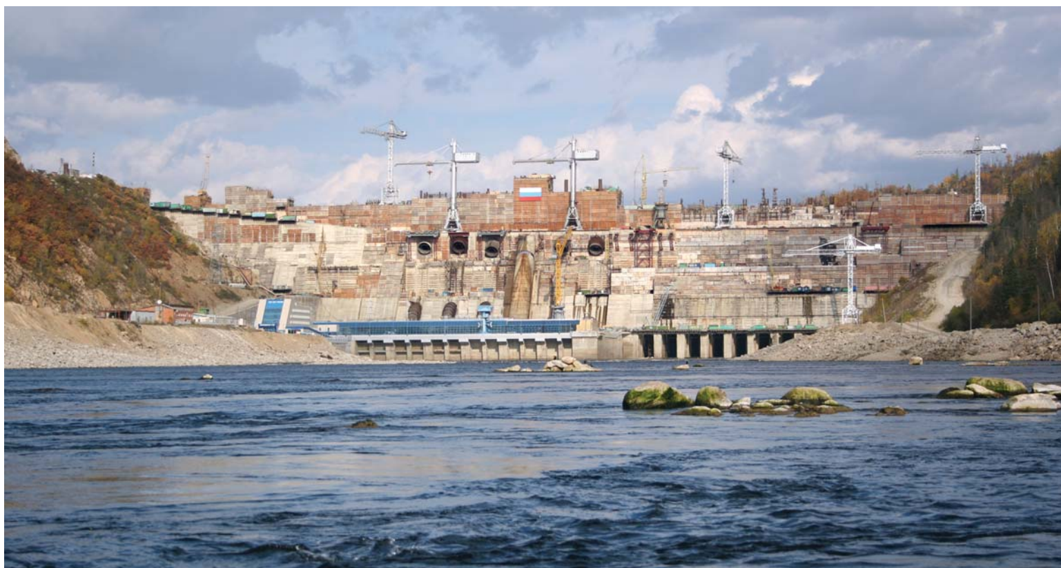
Строительство Бурейской ГЭС
