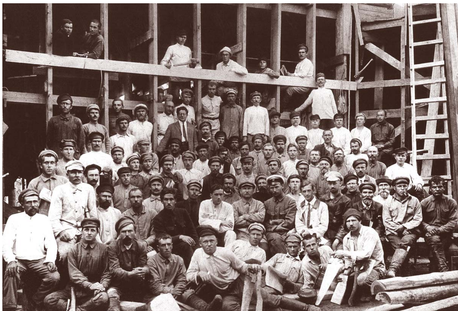
Строители Волховской ГЭС, 1924 год
