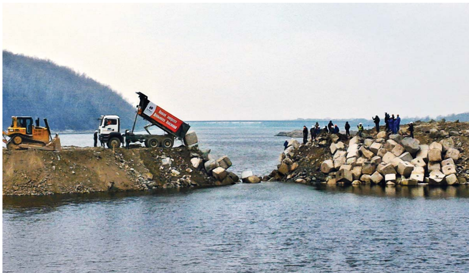
Перекрытие Буреи в створе Нижне-Бурейской ГЭС 19 апреля 2016 года
