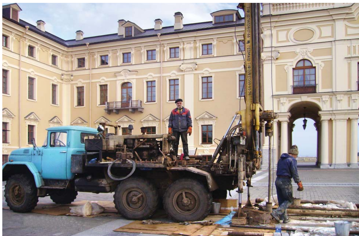
Установка пьезометров для обследования Дворца конгрессов в Стрельне
