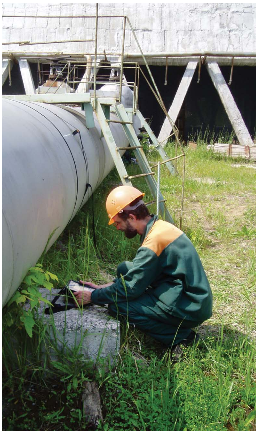
Натурные испытания градирни № 5 Казанской ТЭЦ-2
