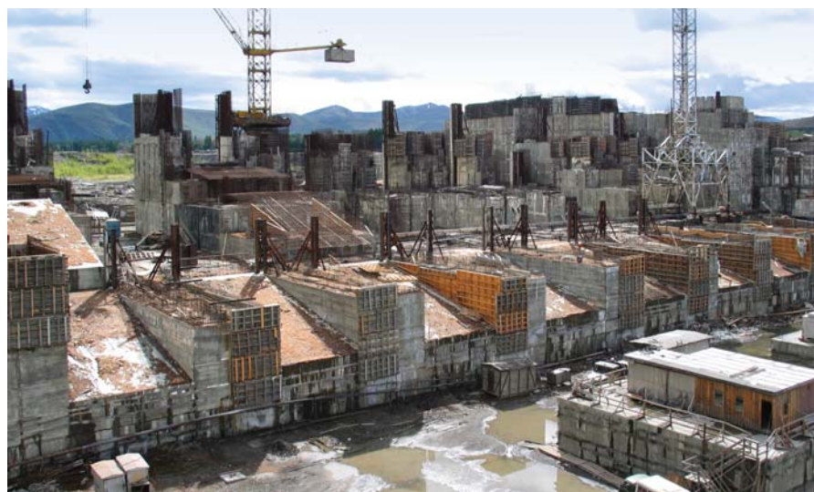
Строительство Усть-Среднеканской ГЭС
