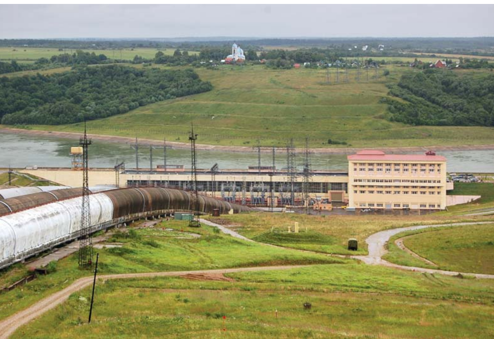
Загорская ГАЭС, годы строительства – 1980–2003
