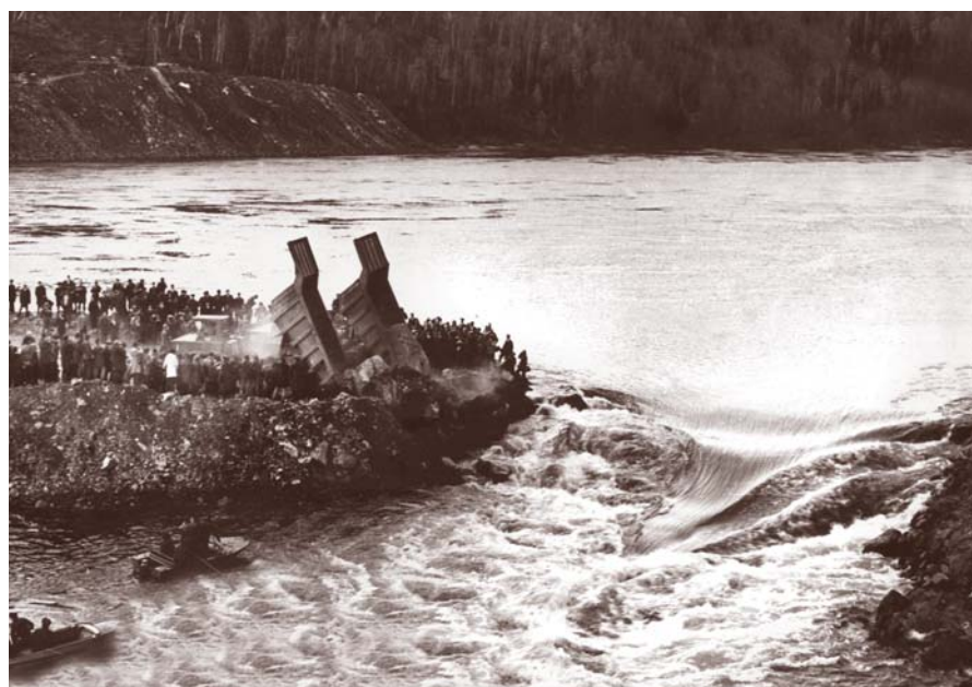
Перекрытие Енисея в створе Саяно-Шушенской ГЭС 11 октября 1975 года
