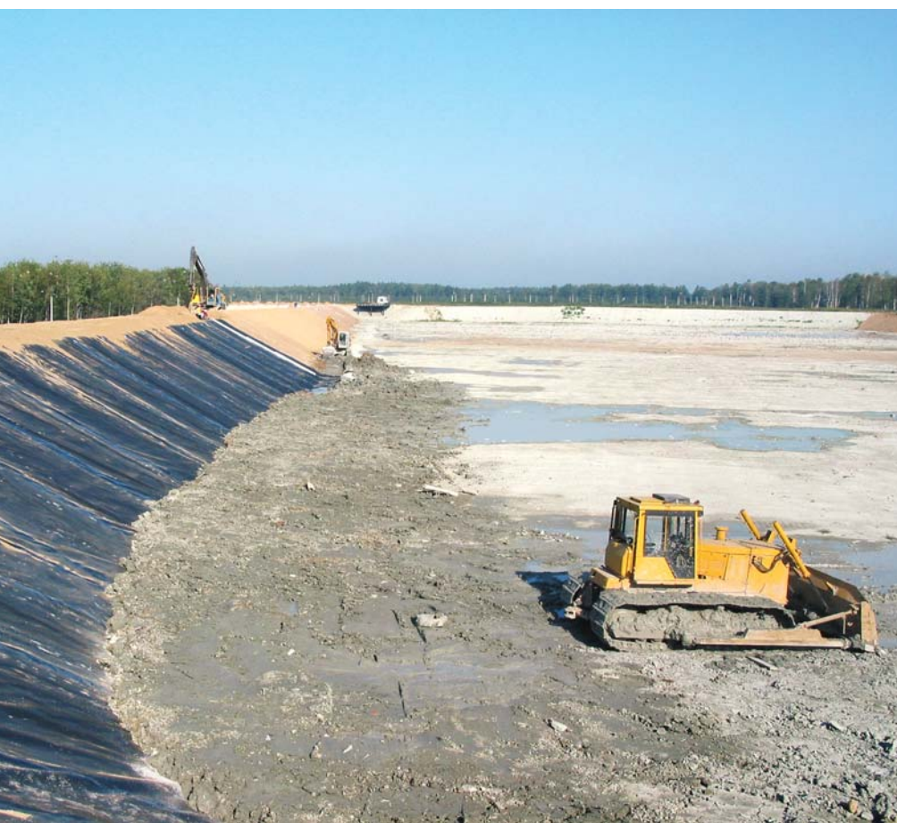
Строительство полимерного экрана на накопителе сточных вод
