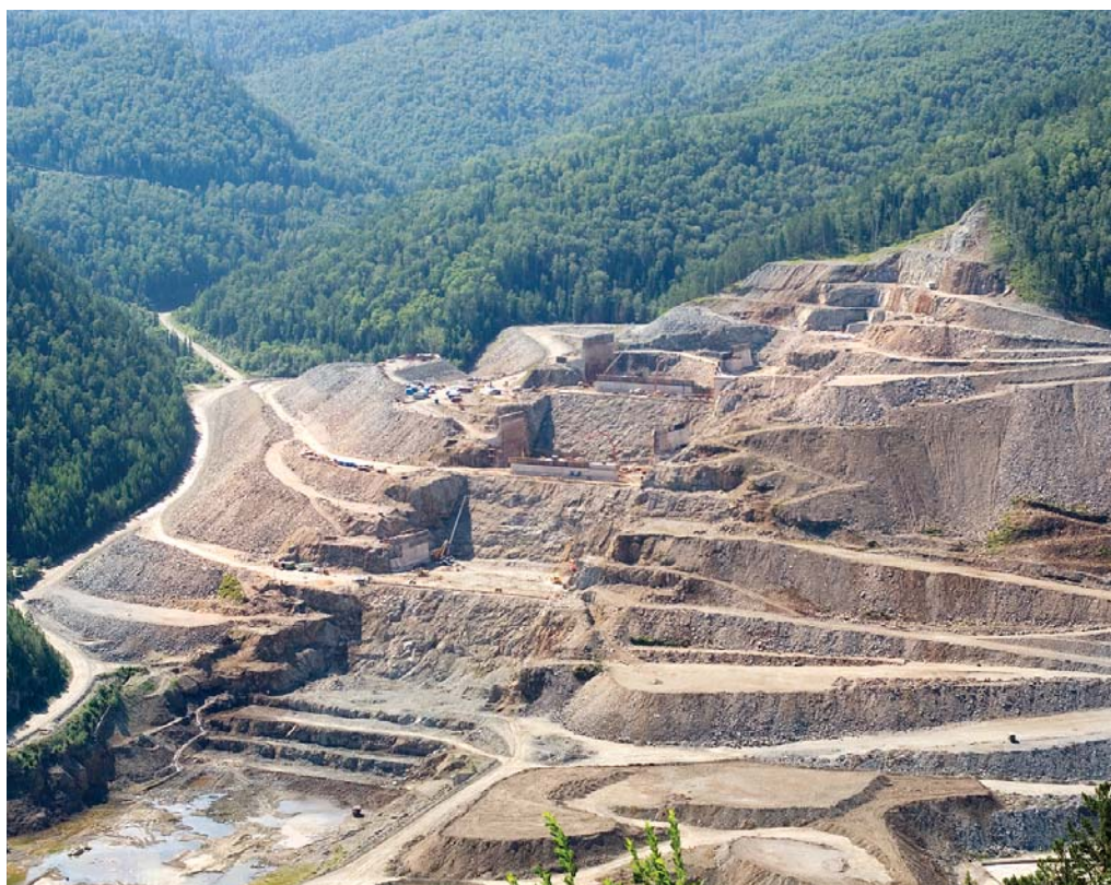
Строительство берегового водосброса Саяно-Шушенской ГЭС
