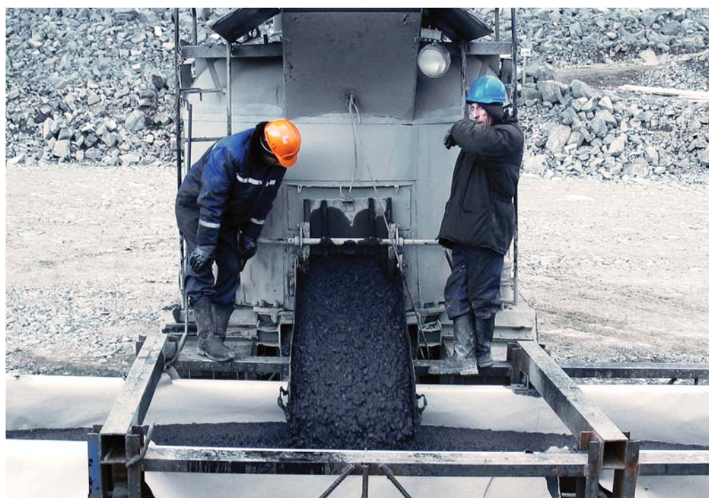
Заливка асфальтобетона в диафрагму Богучанской ГЭС
