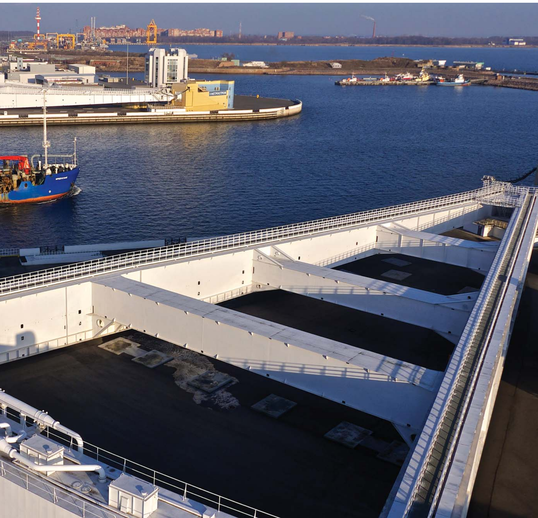
Судопроектное сооружение С-1. Вид на плавучие затворы-батопорты
