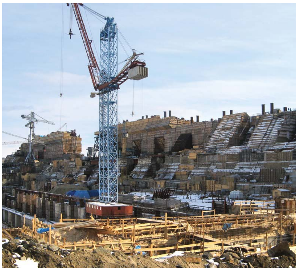
Строительство Богучанской ГЭС
