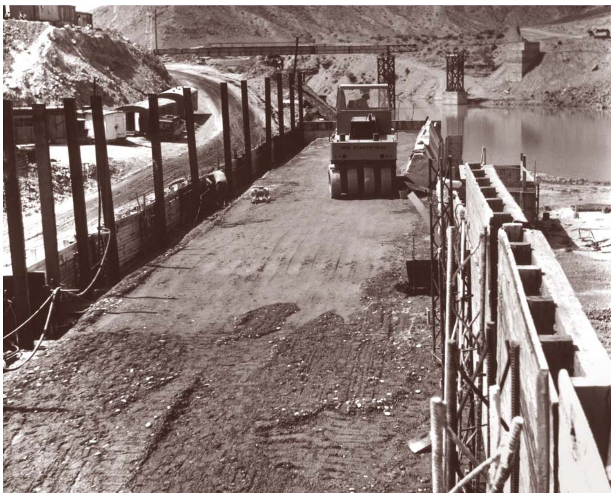
Укатка малоцементной бетонной смеси на строительстве Ташкумырской ГЭС
