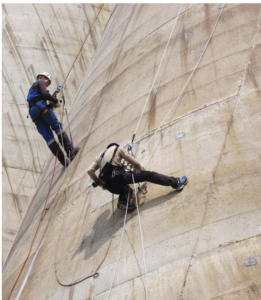
Обследование водоводов Бурейской ГЭС
