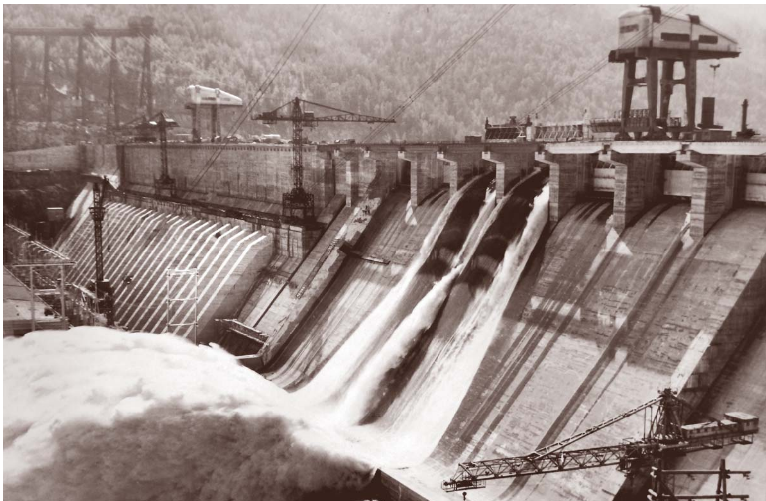
Пропуск паводка через водосливную плотину Красноярской ГЭС, 1970-е годы
