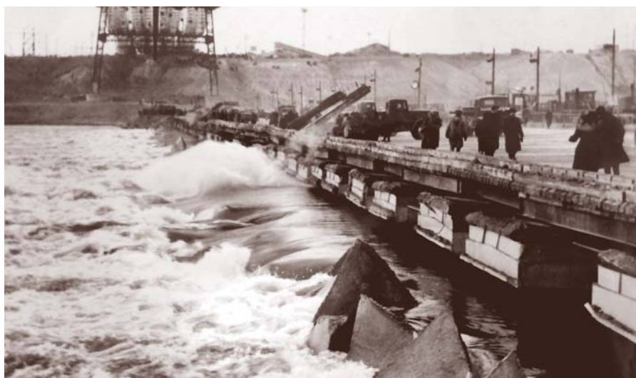
Перекрытие Волги на строительстве Волжской ГЭС
