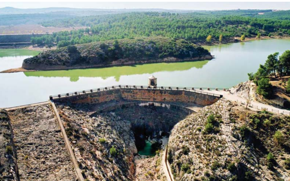
Старейшая в мире арочно-гравитационная плотина Almansa (Испания)
