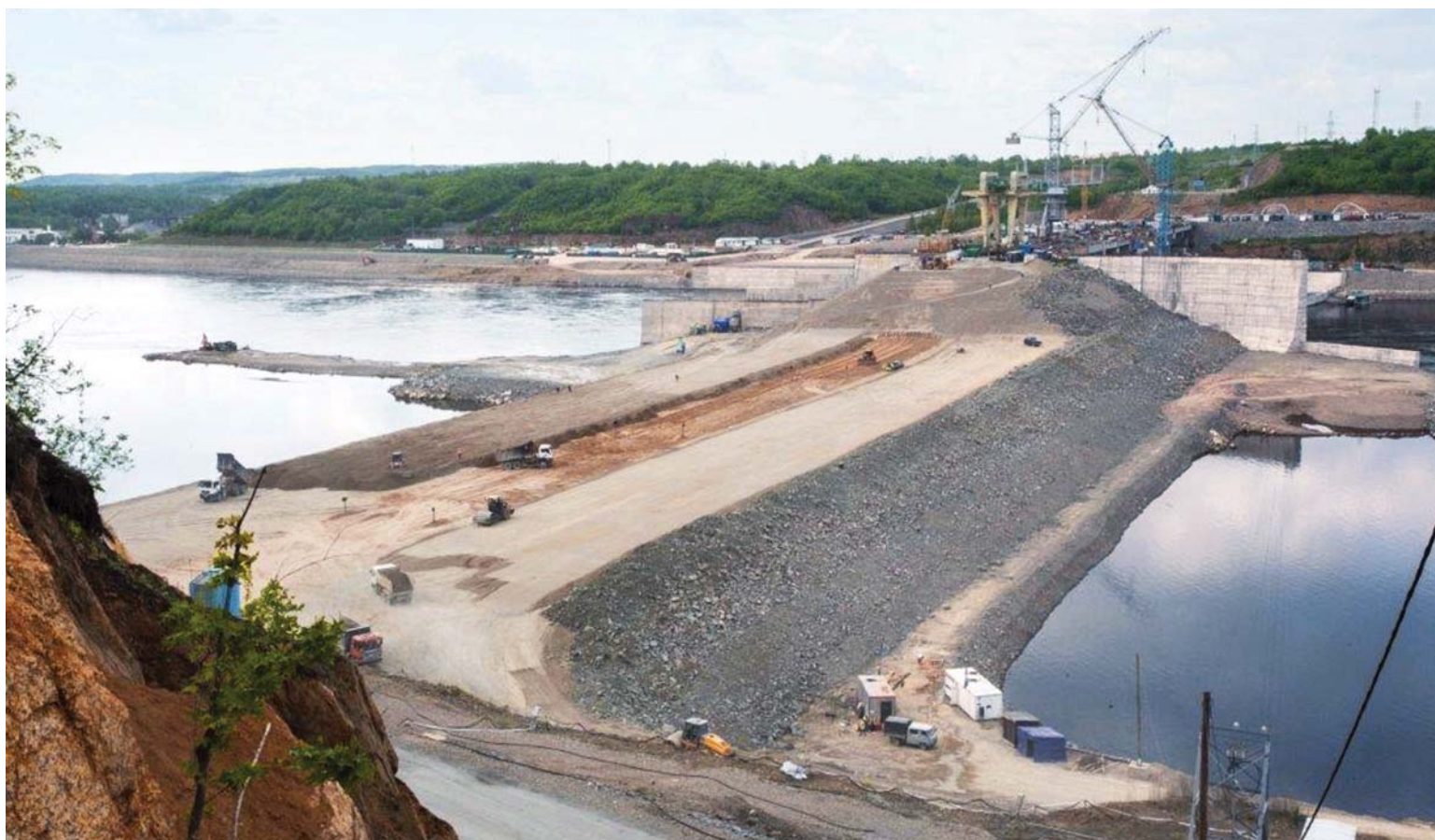
Грунтовая плотина Нижне-Бурейской ГЭС
