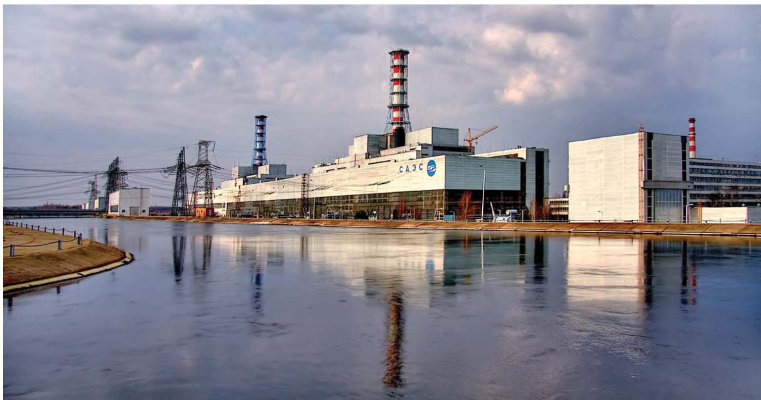
Смоленская АЭС, годы строительства – 1975–1982
