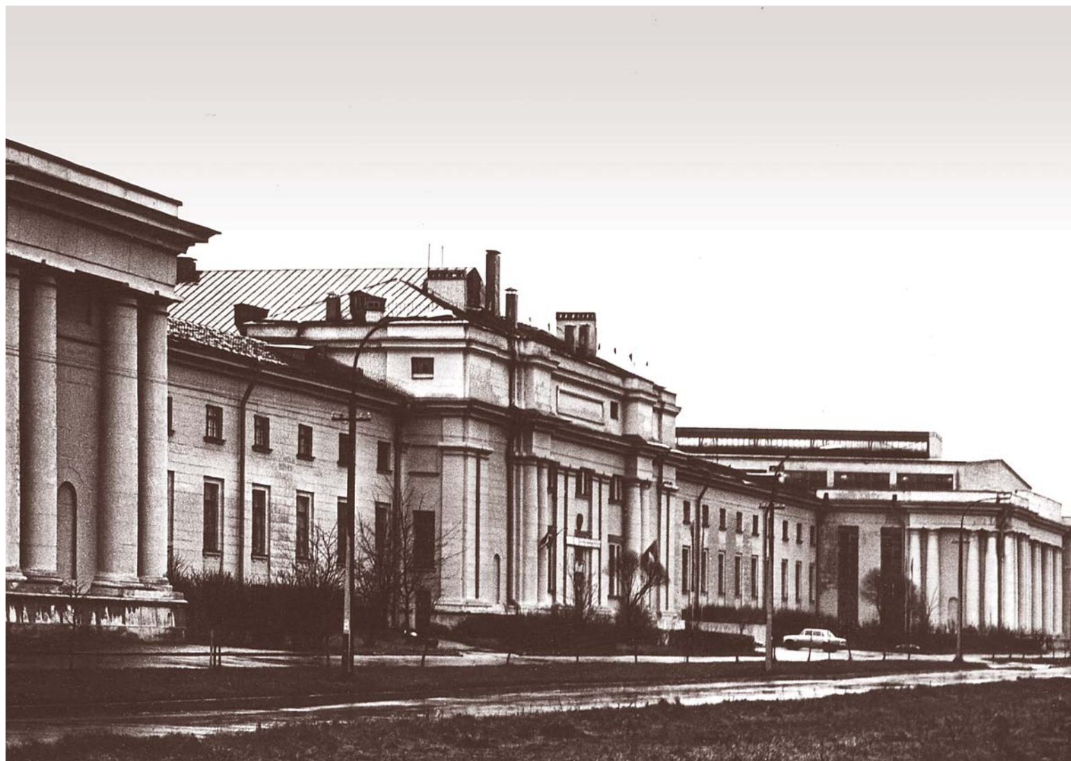
Здание корпуса II ВНИИГ им. Б.Е. Веденеева, построено в 1965 году
