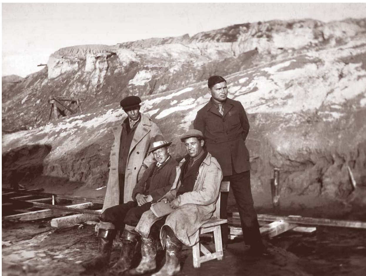
Сотрудники лаборатории грунтов и оснований на исследованиях для строительства объекта НКВД, 1940 год
