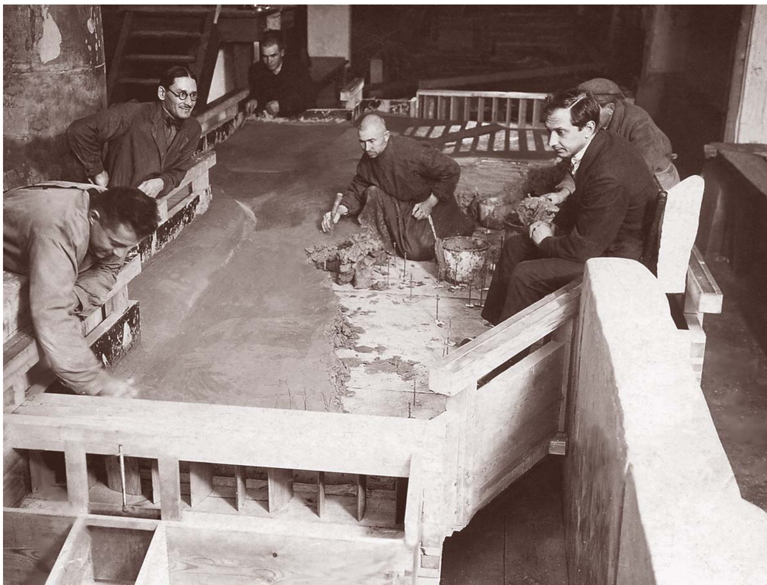
Строительство гидравлической модели, начало 1930-х годов
