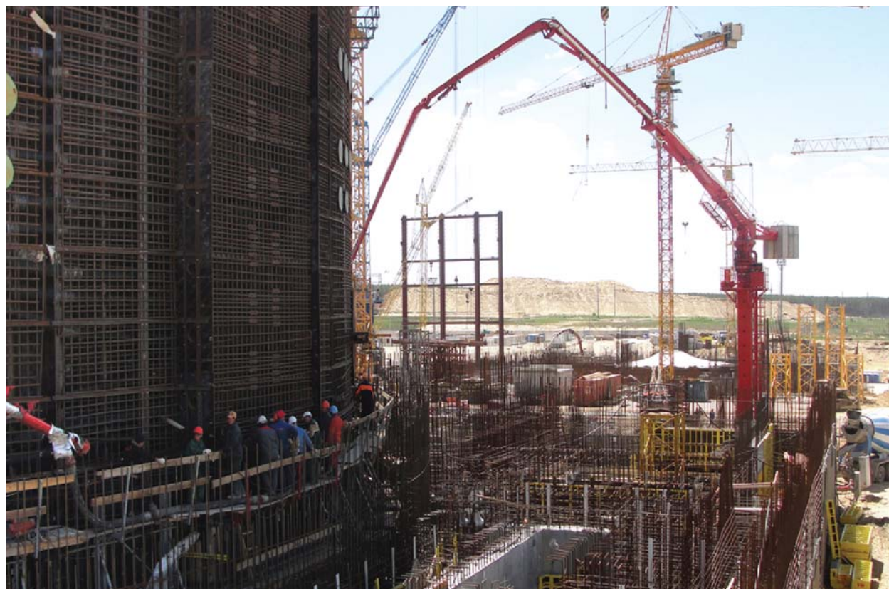
Бетонирование блоков Нововоронежской АЭС
