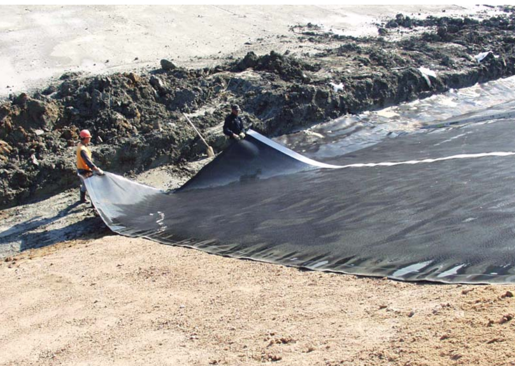
Укладка полимерной геомембраны на грунтовое основание
