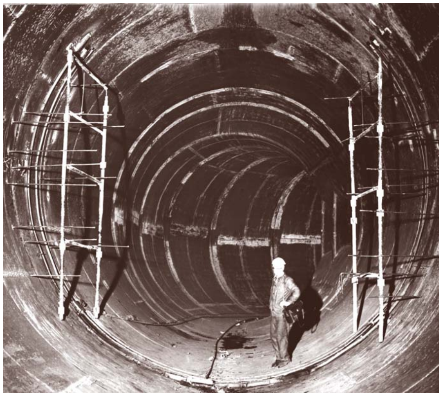
Исследование оболочки водовода Саяно-Шушенской ГЭС, 1970-е годы
