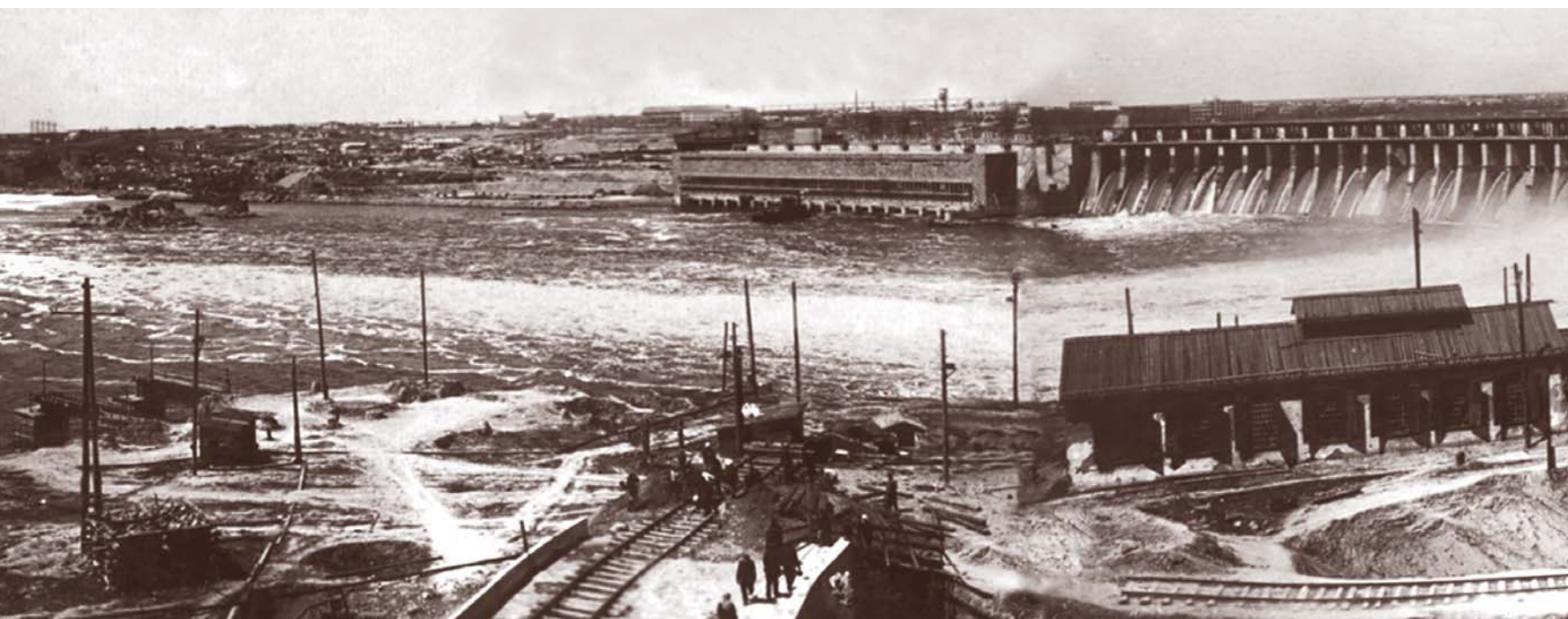
Общий вид строительства Днепровской ГЭС, 1930-е годы
