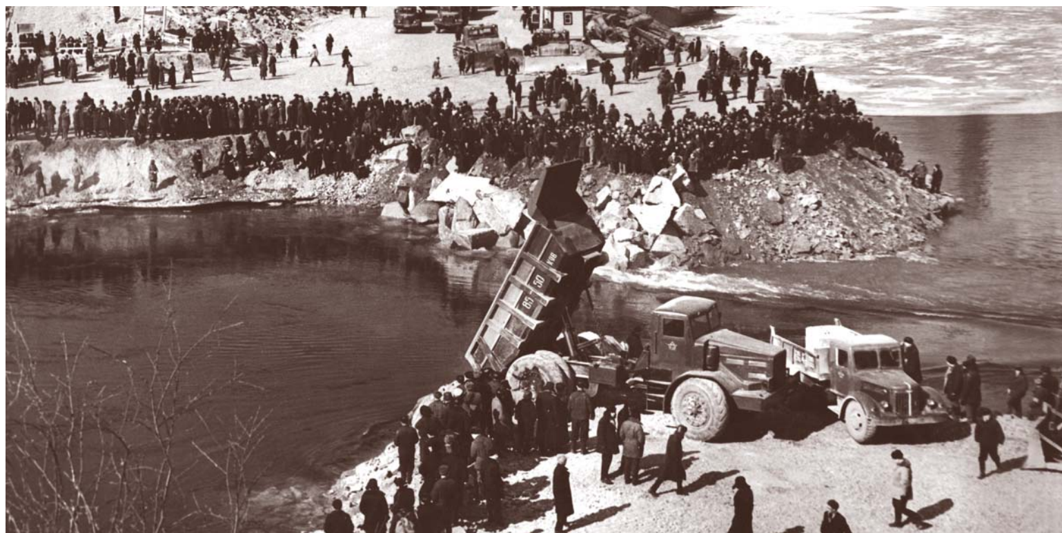
Перекрытие Енисея на строительстве Красноярской ГЭС, 1963 год
