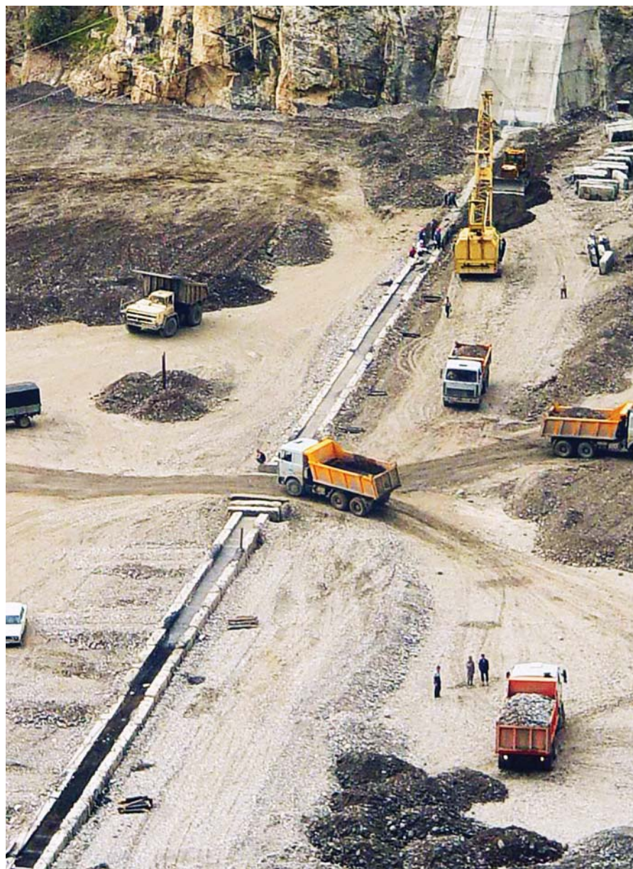
Строительство литой асфальтобетонной диафрагмы на плотине Ирганайской ГЭС
